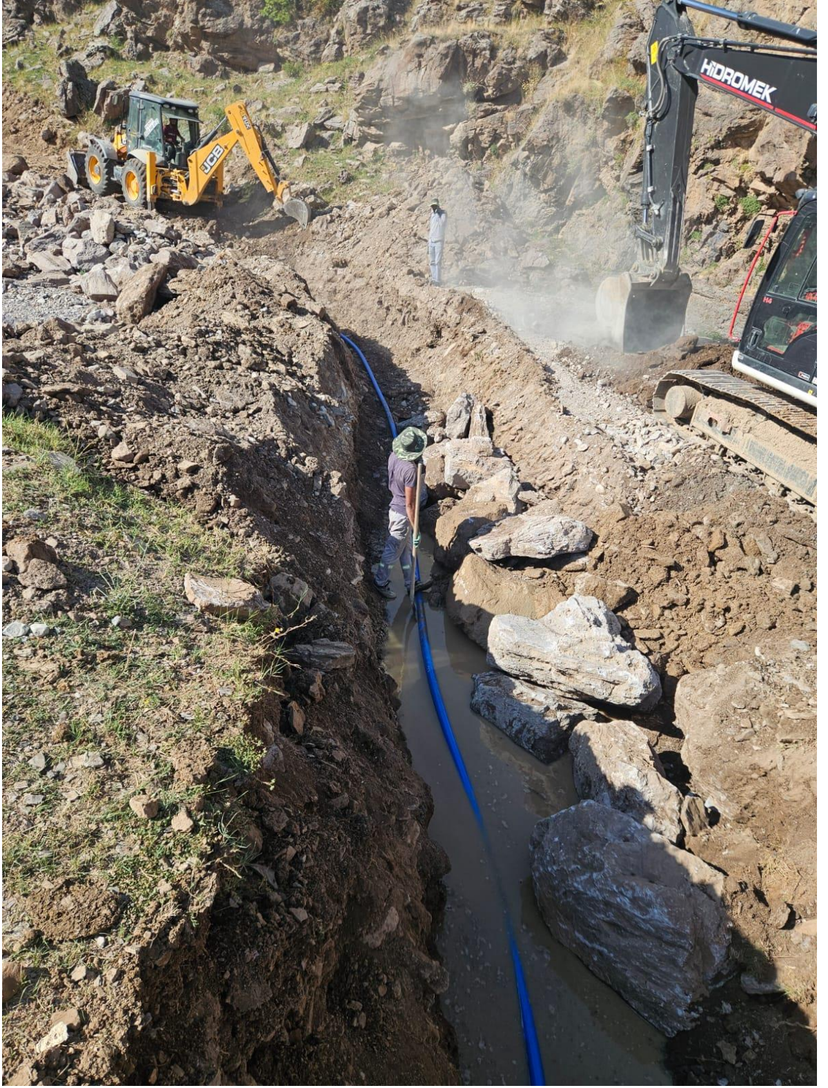
Kağızman Aydıncavak ve Yağlıca Köyleri Selden Etkilenen İçmesuyu Hatlarının yapımı
