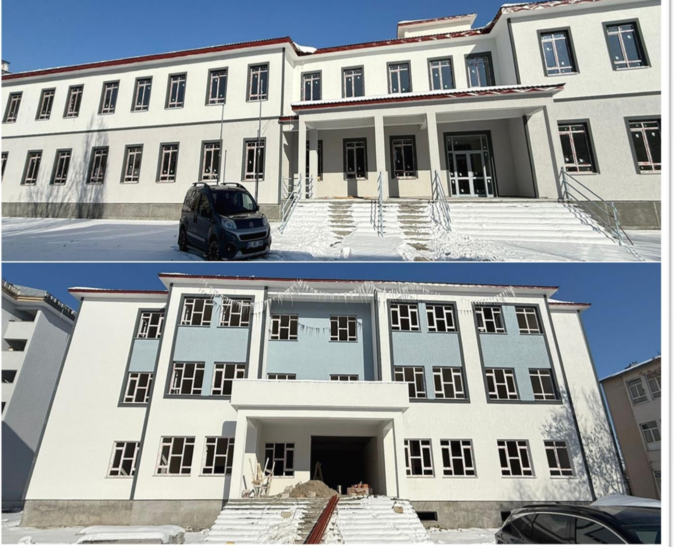
Kars Merkez Cumhuriyet Lisesi 12 + 12 Derslikli A-B Blok Anadolu Lisesi Yapım İŖi
