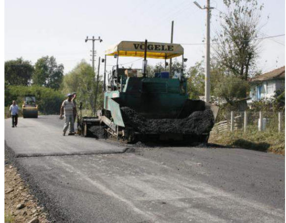
Sıcak Asfalt Yol Çalışması
