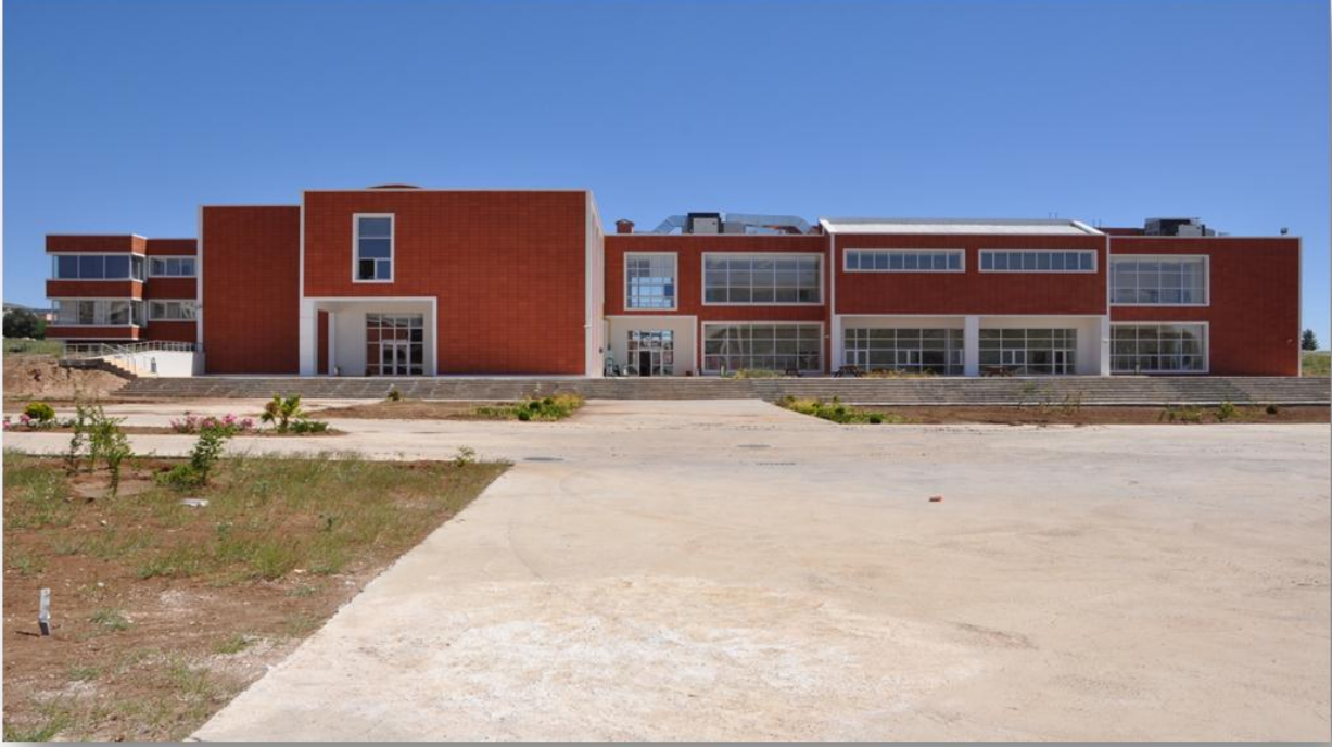
İİBF Binası (Aralık 2011)
