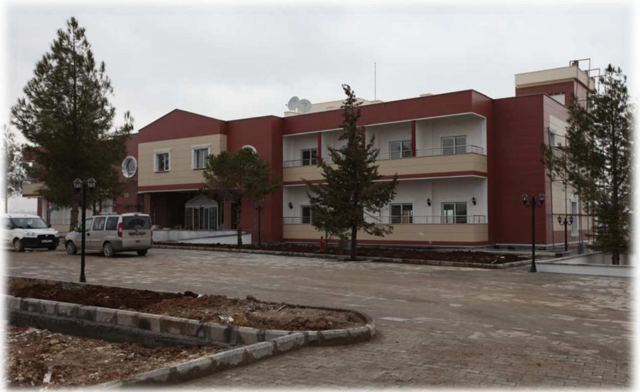
MYO Turizm ve Otelcilik Uygulama Oteli İnşaatı (Aralık 2011)
