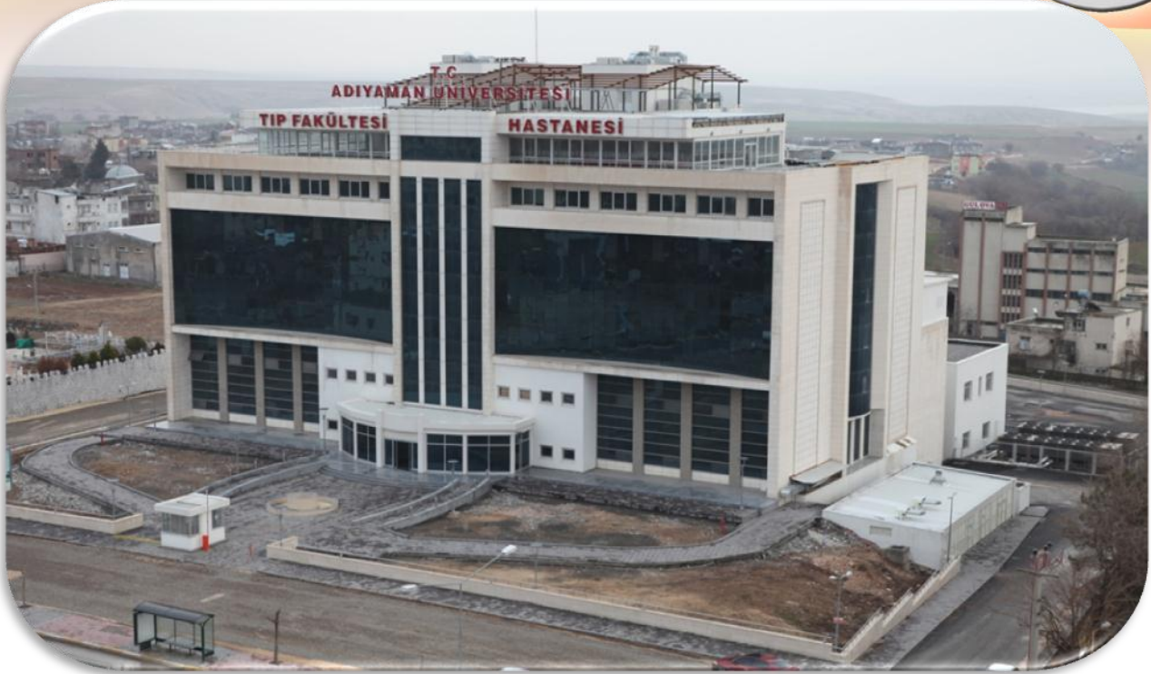
Tıp Fakültesi Araştırma Uygulama Hastanesi 1.Etap (Aralık 2011)
