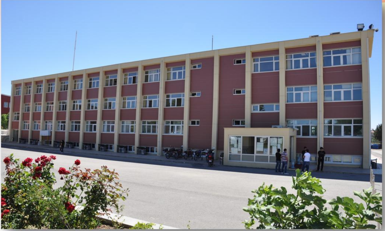
Meslek Yüksekokulu Binası (Aralık 2011)
