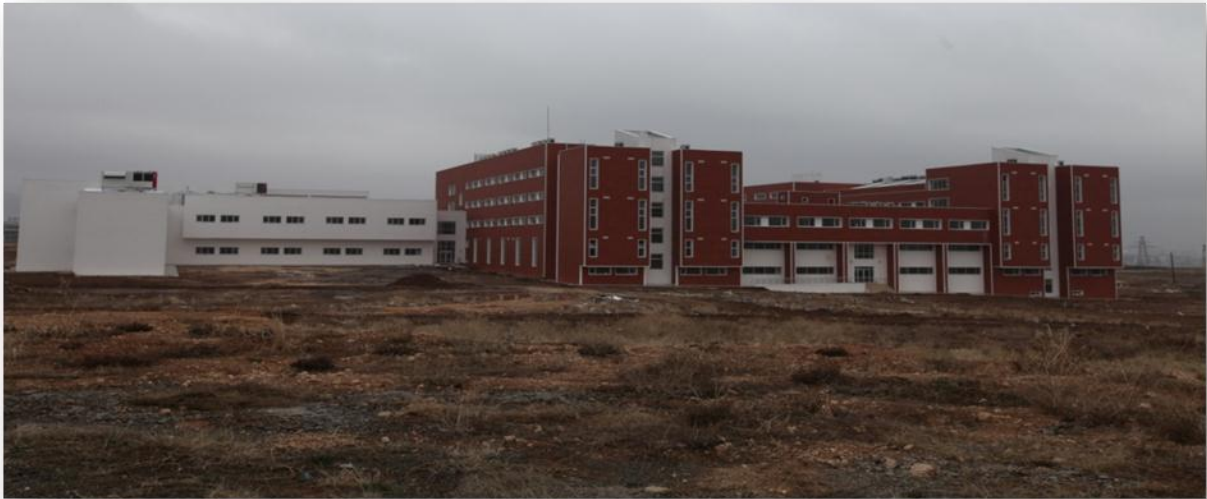
Merkezi Derslikler İnşaatı Görünümü (Aralık 2011)
