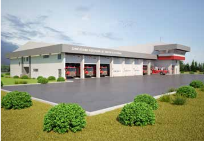
Isparta ARFF Binası
