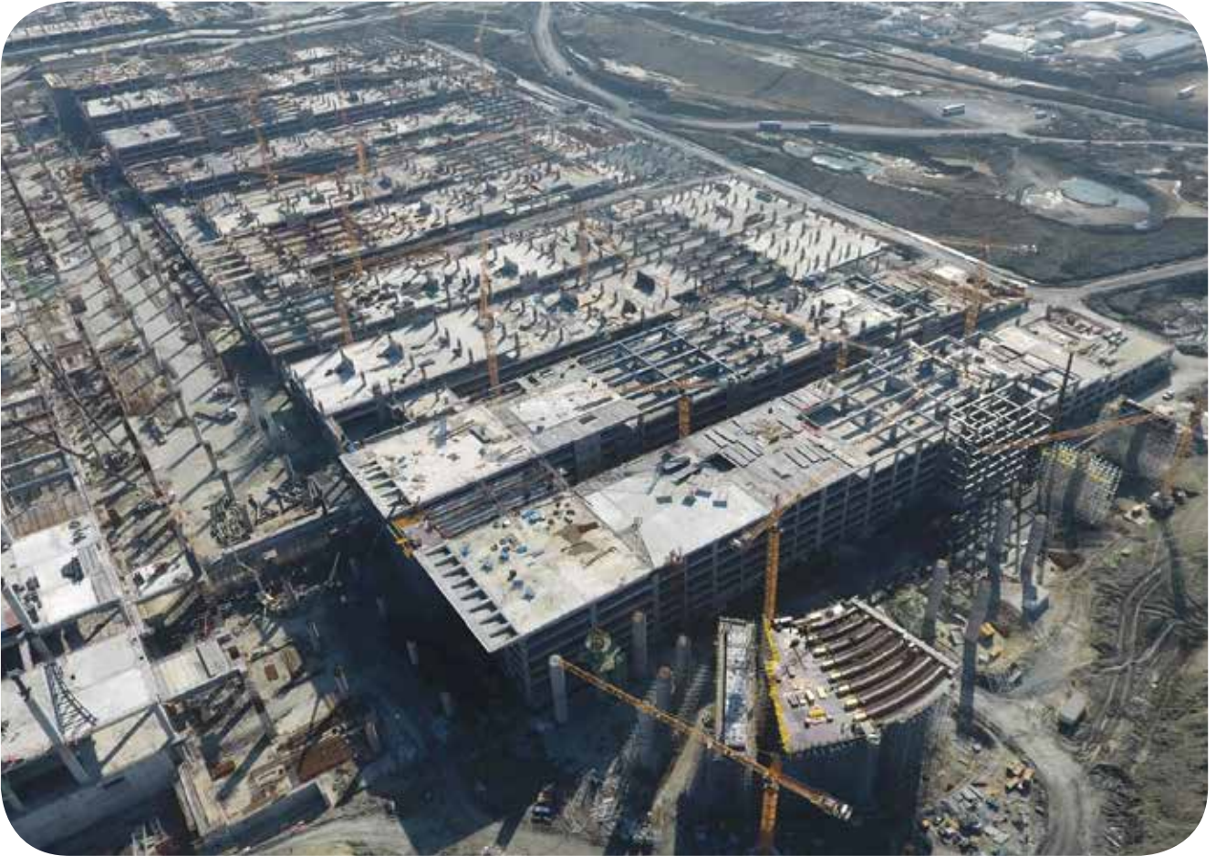
Terminal Ottopark Binası
