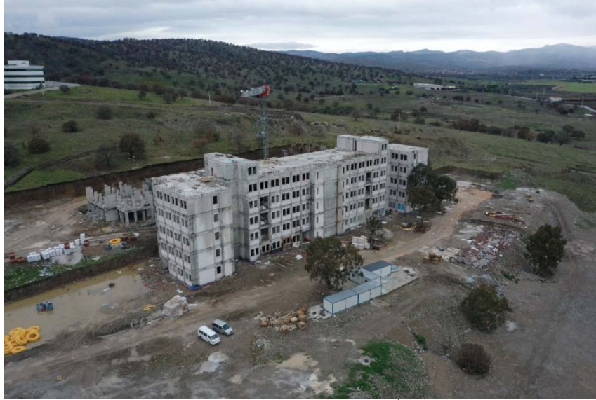
Derslik ve Merkezi Birimler İnşaatı
