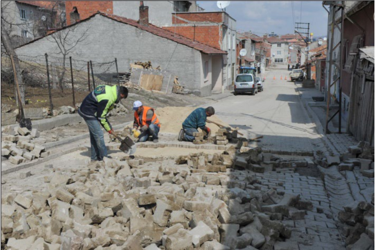
Kilit parke taşı tamirâtı çalışmaları
