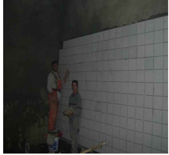
Köy İçme Suları Depo Yapımı
