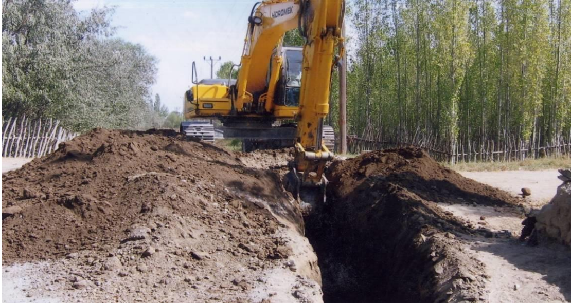
Köy İçme Suları Çalışmalarından Görünüm
