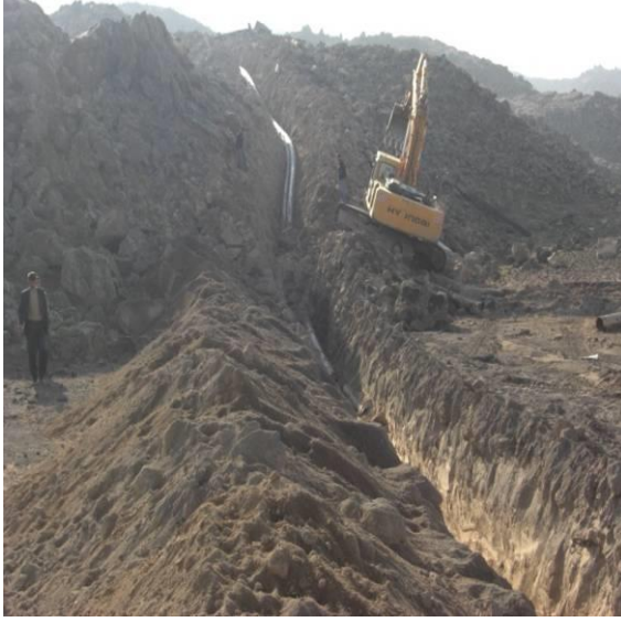
Köy İçme Suları Kanal Kazı Dolgu İşleri
