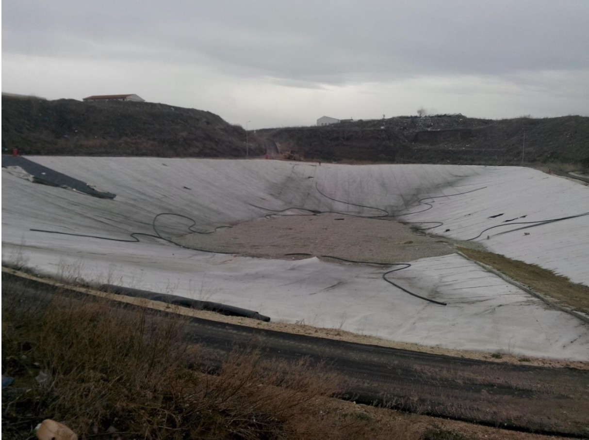
Katı Atık Düzenli Depolama Sahası 2. Lot Alanı 1. Kademe
