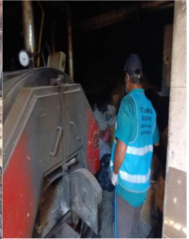
(Vatandaşlarımızın talepleri doğrultusunda bodrum katları ve kazan daireleri bölümlerinin ilaçlanması)
