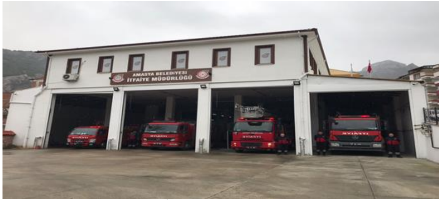
İtfaiye Hizmet Binası
