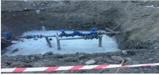
(Basınç Ölçme Odası )
