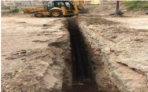
(Şeyhcui Mah. Kanalizasyon hat çalışması)
