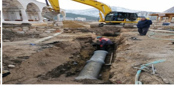
(Bahçeleriçi Mah. Yağmur suyu hat çalışması)
