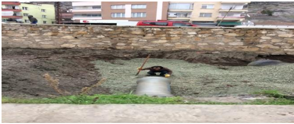
(Hızırpaşa Mah.Yağmur suyu hat çalışması)
