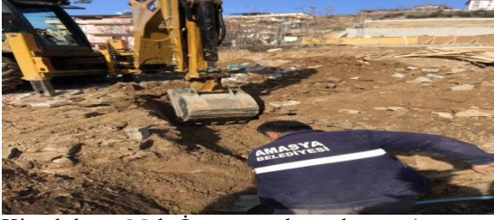
(Kirazlıdere Mah. İçme suyu hat çalışması )
