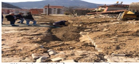
(Kirazlıdere Mah. İçme suyu hat çalışması)
