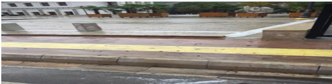
Belediye İmar Yolları, Kaldırımlar, Parklar ve Belediye Tesis Alanları Bakım Onarım ve Yenileme Projesi (PROJE/Başlama Tarihi: 2018 PROJE/Bitiş Tarihi:2018)(Toplam Proje Bedeli:2.958.000,00-TL/ Fiziki Gerçekleşme:%100)
