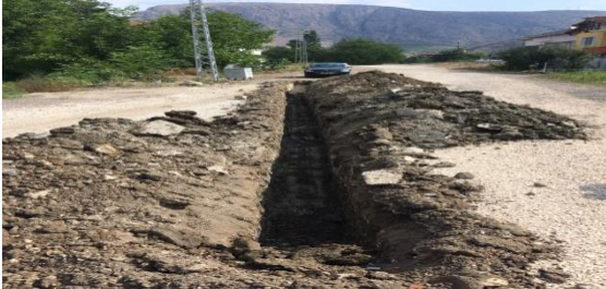
(Helvacı Mah. İçme suyu hat çalışması)
