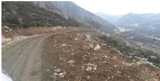
(Sarılar Mah.İçmesuyu hat çalışması)
