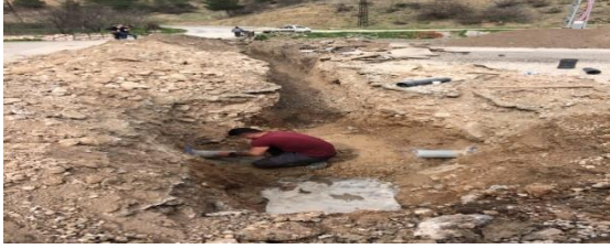
(Göllübağları Mah.İçme suyu hat çalışması )
