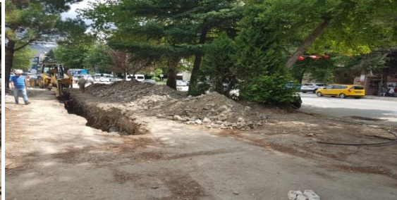
(Pirinççi Mah. Yağmur suyu hat çalışması)
