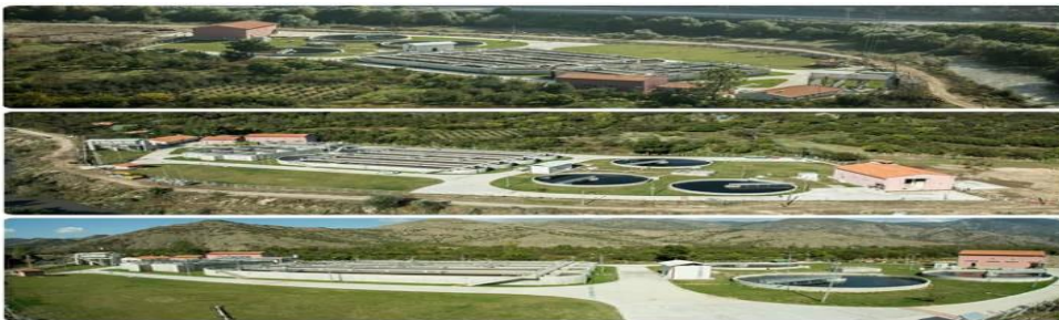
(Amasya Atıksu Arıtma Tesisi)
