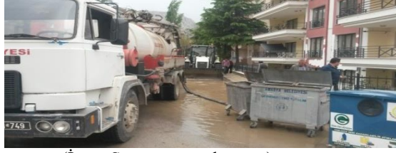
(İçme Suyu arıza çalışması)
