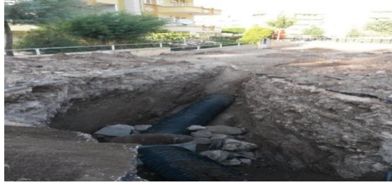
(Kanalizasyon tamirat çalışması)
