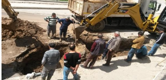
(Hızırpaşa Mah.İçmesuyu hat çalışması)
