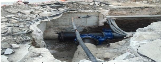
(İçme Suyu hat tamirati)
