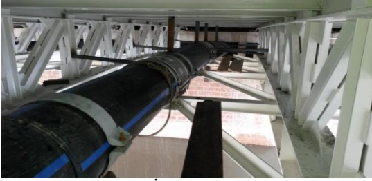
(Depolar arası İçme Suyuhat tamirati )
