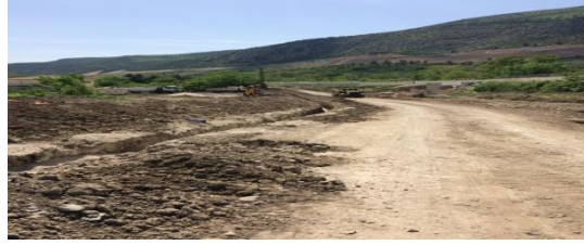
(Akbilek Mah.İçme Suyu hat çalışması)
