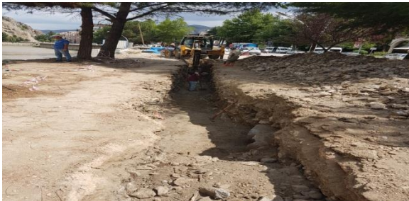
(Pirinççi Mah. Yağmur suyu hat çalışması)
