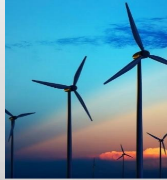
2 RÜZGAR ENERJİSİ SANTRALİ
