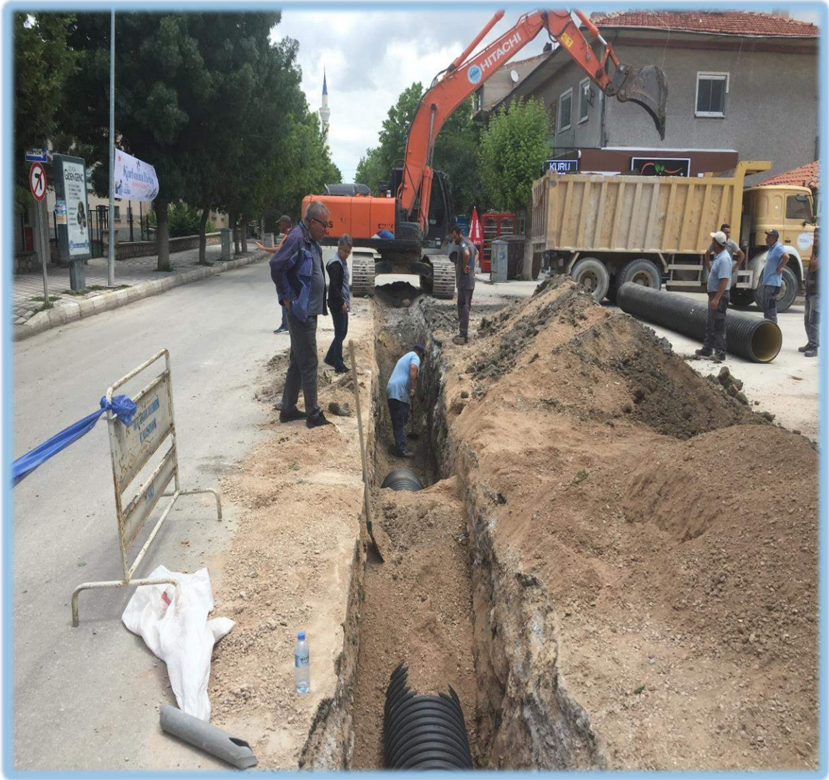
Yağmur Suyu Hattı Yapım İşi
