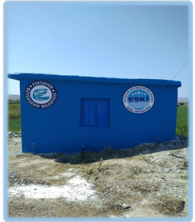
Depo Tadilatı Sonrası
