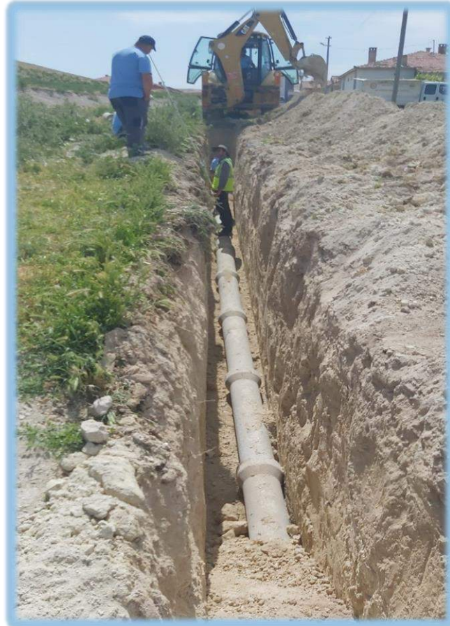
Kanalizasyon Hattı Yapım İşi
