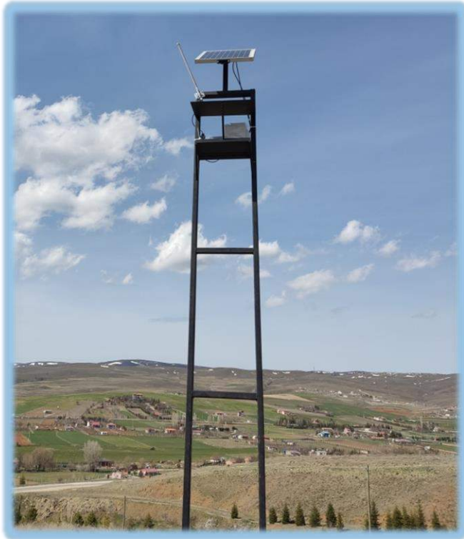
Güneş Panelli Haberleşme Sistemi Kurulması İşi
