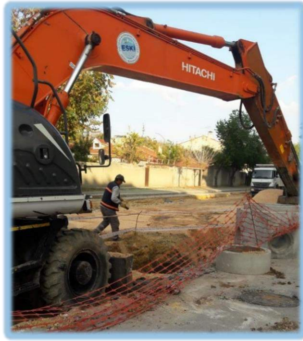
Kanalizasyon Ana Kanal Tamir Çalışması
