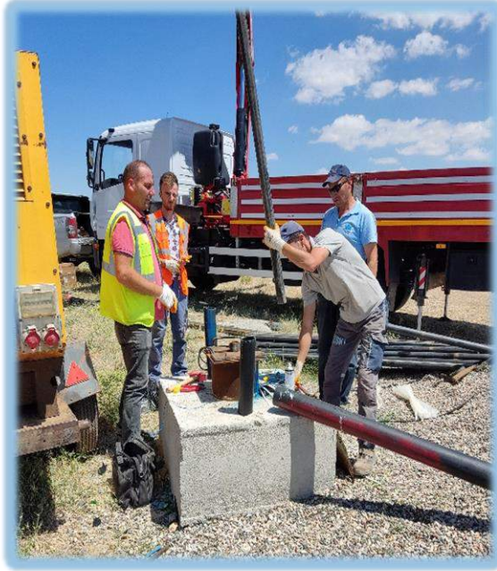
Sondaj Kuyusu Pompa Montajı
