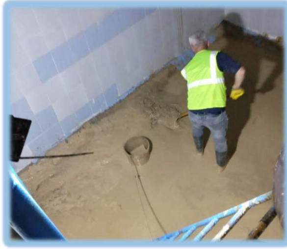
Depo Temizliği Çalışması (öncesi)
