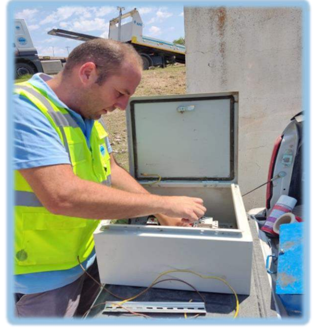
Elektrik Pano Tamir İşi
