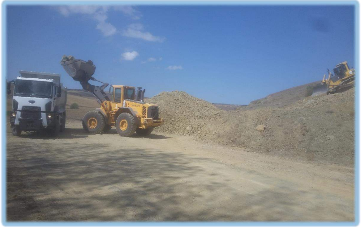
Dolgu Malzemesi Yükleme Çalışması
