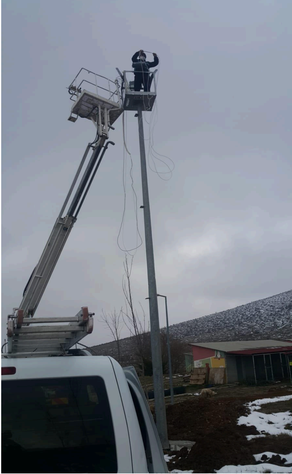
Barınak Çevre aydınlatma çalışmaları
