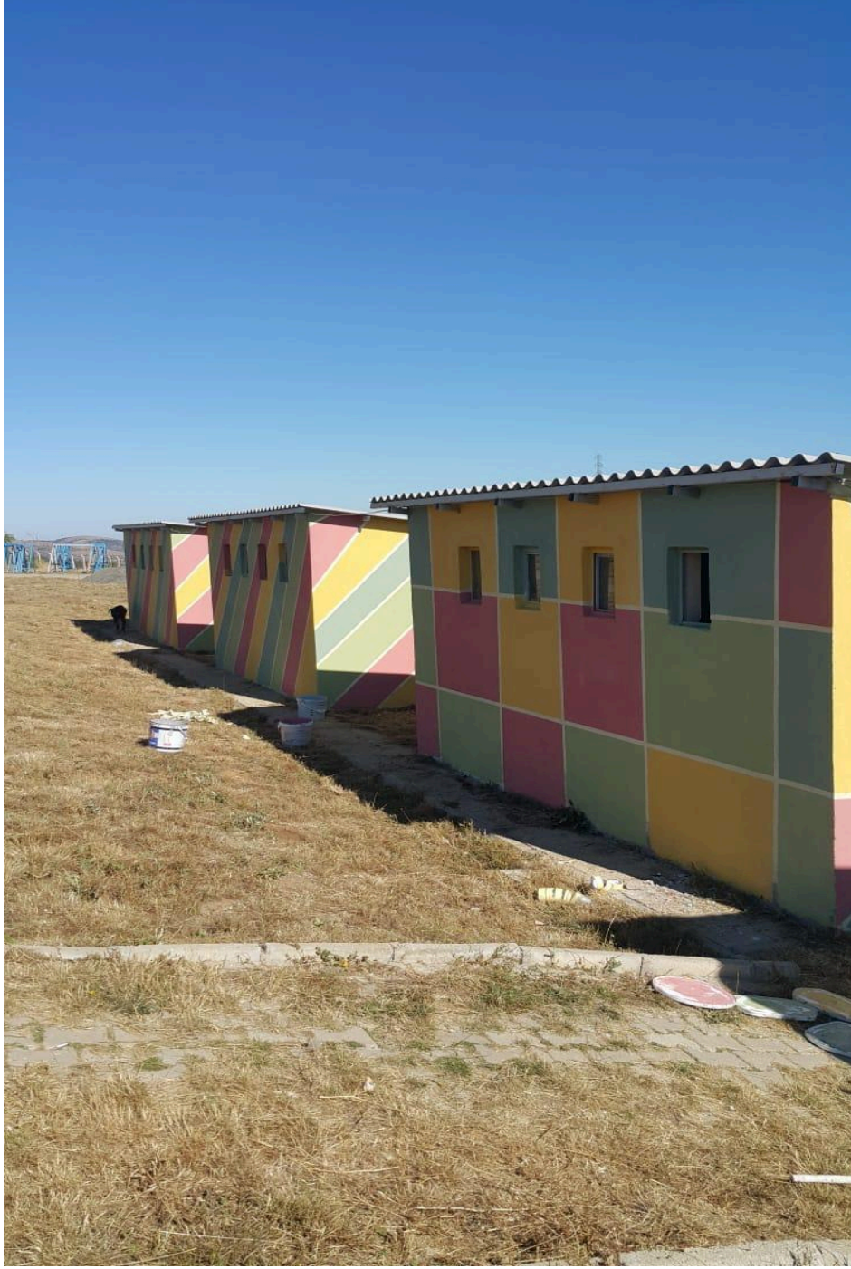
Barınakta bulunan kulübelerimize dış cephe boya çalışması
