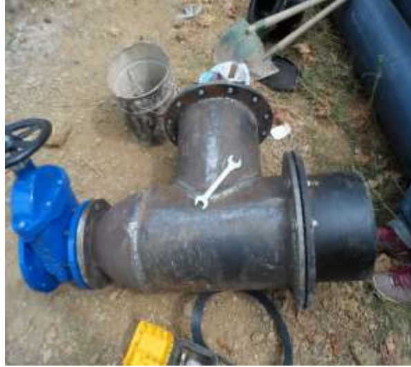
Açık Beton Kanalın Borulu Sisteme Çevrilmesi (Merkez Safran Köyü)
