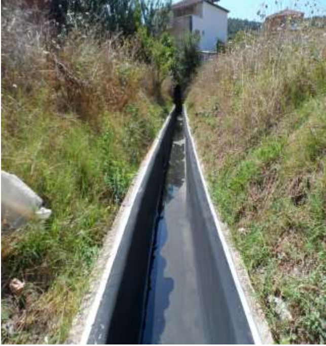
Beton Kanalda sızdırmazlığın önlenmesi için membran kaplama yapılması
