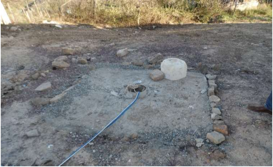
Çiftlikköy Denizçalı Köyü Derin Sondaj Kuyusu çalışması
