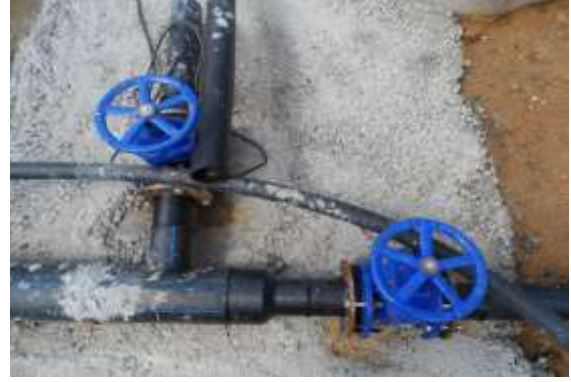
İlyasköy Göleti Sulama Hattı Ayrım Vanaları
