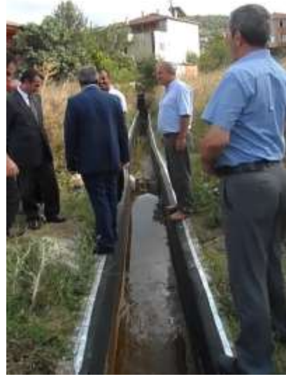
Beton Kanalda sızdırmazlığın önlenmesi için membran kaplama yapılması
