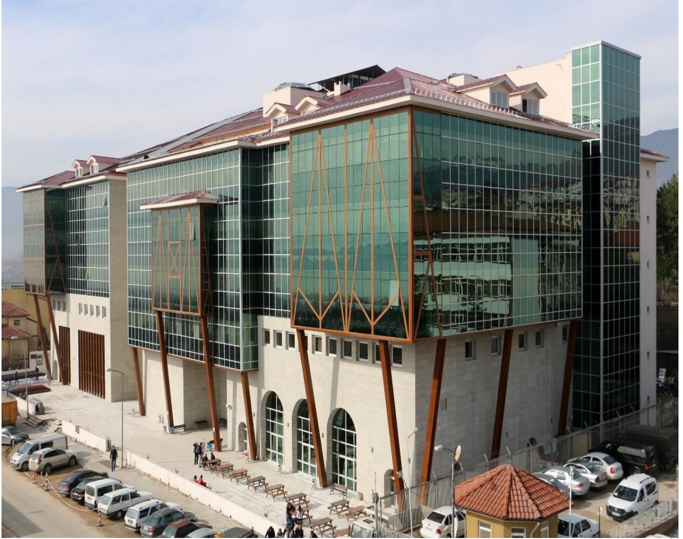
Resim 6. Safranbolu Fethi Toker Güzel Sanatlar ve Tasarım Fakültesi Binası
