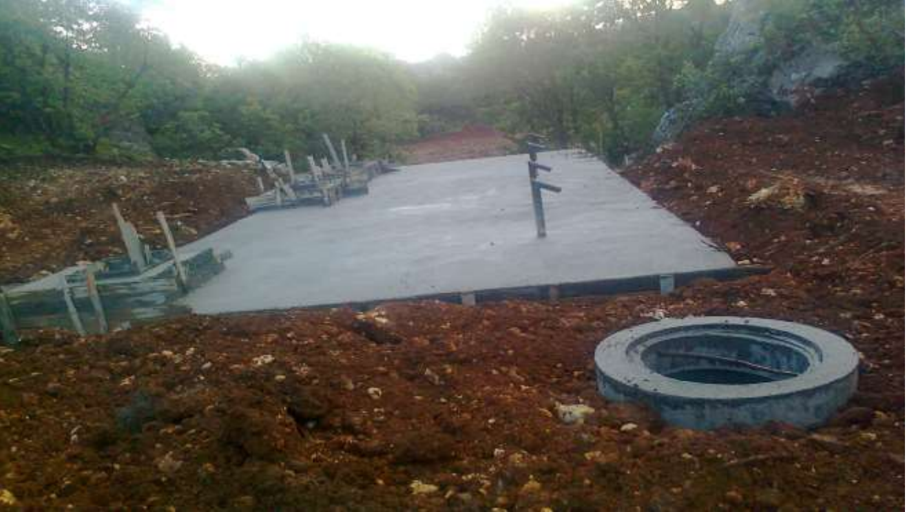
Merkez Taşoluk Köyü Kanalizasyon Tesisi Çalışması
