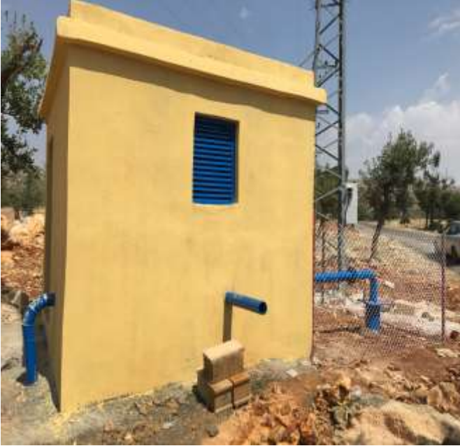
Gölbası İlçesi Yukarı Nasırlı Köyü İçme Suyu Deposu
