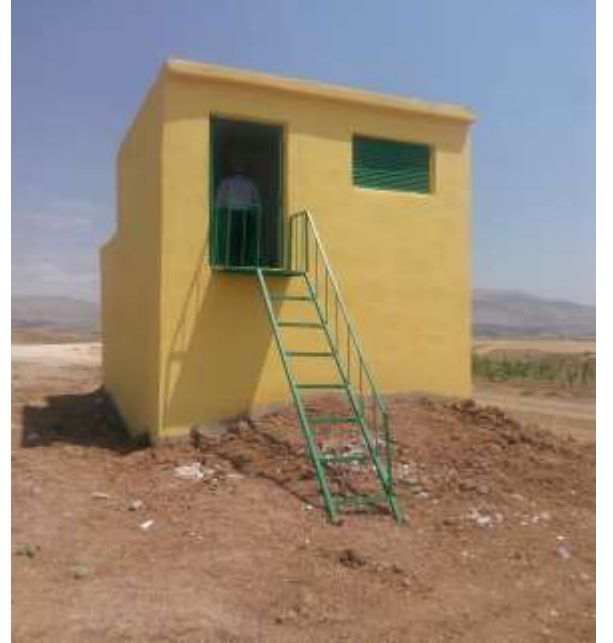
Kahta İlçesi Akkavak Köyü İçme Suyu Deposu
