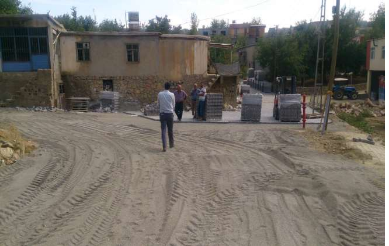
Köy İçi Kilitli Parke Taşı Döşeme Çalışması
