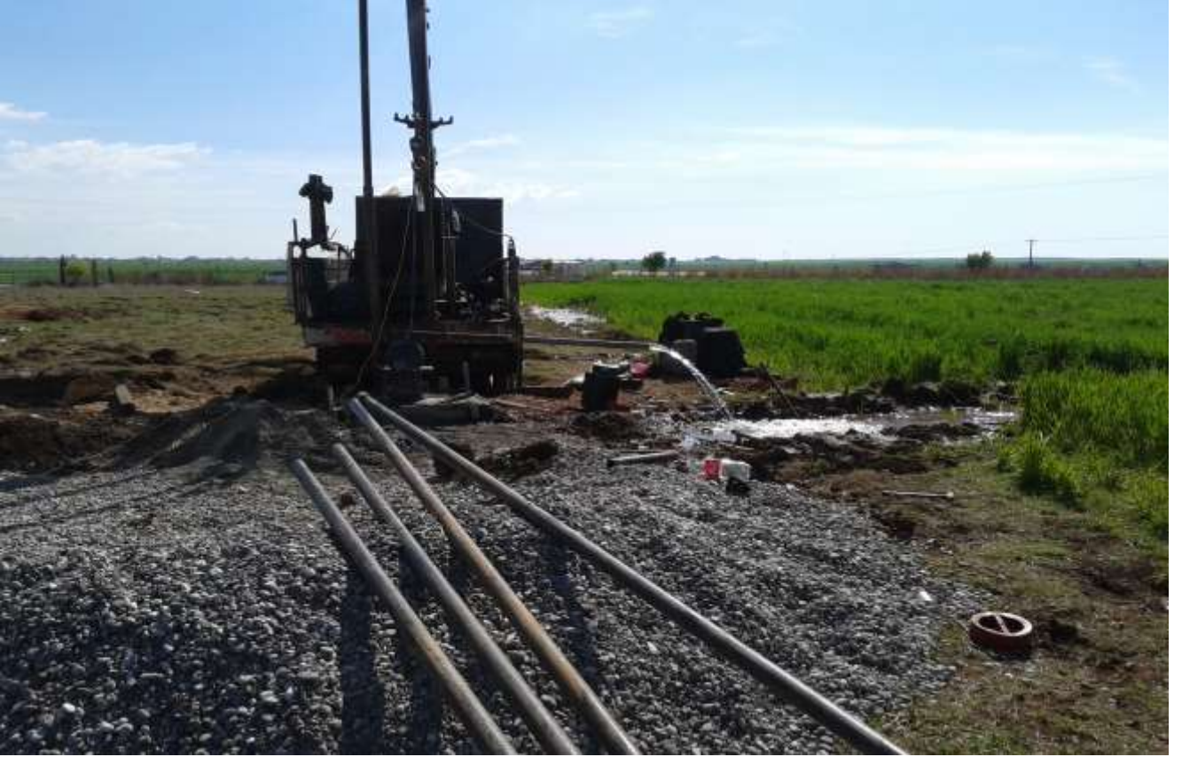
Kâhta İlçesi Ortanca Köyü Fen Lisesi Sondaj Çalışması
