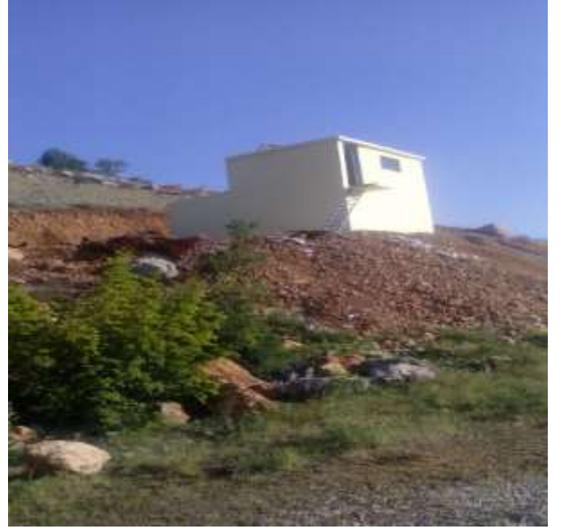
Sincik İlçesi Pınarbaşı Köyü İçme Suyu Deposu
