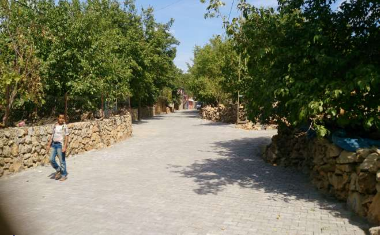
Köy İçi Kilitli Parke Taşı Döşeme Çalışması
