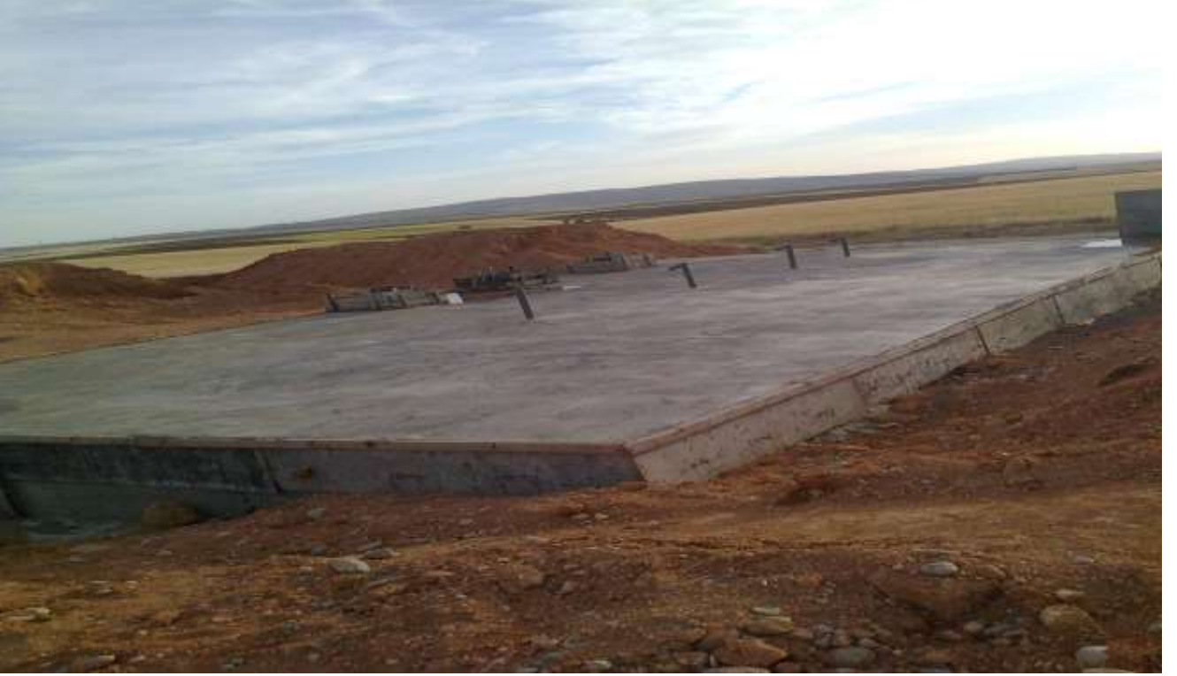
Merkez Durak Köyü Kanalizasyon Tesisi Çalışması
