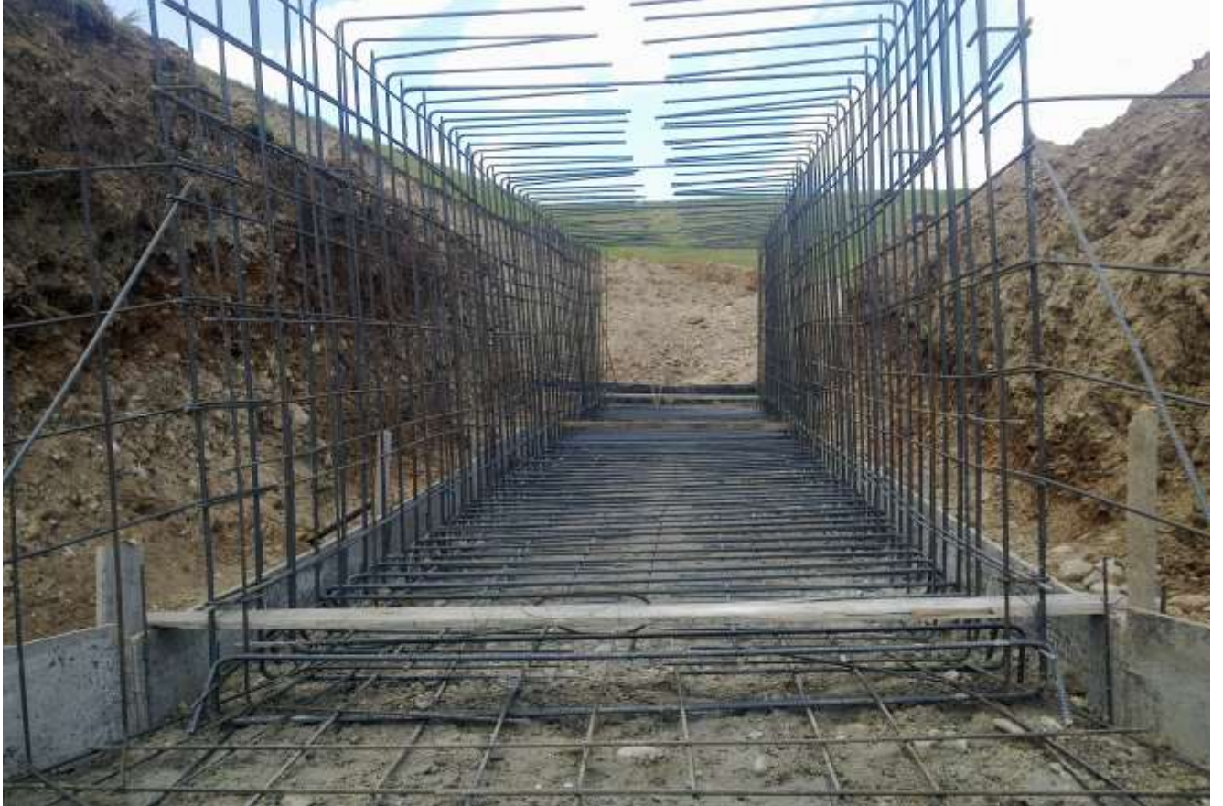
Menfez Yapımı Çalışması
