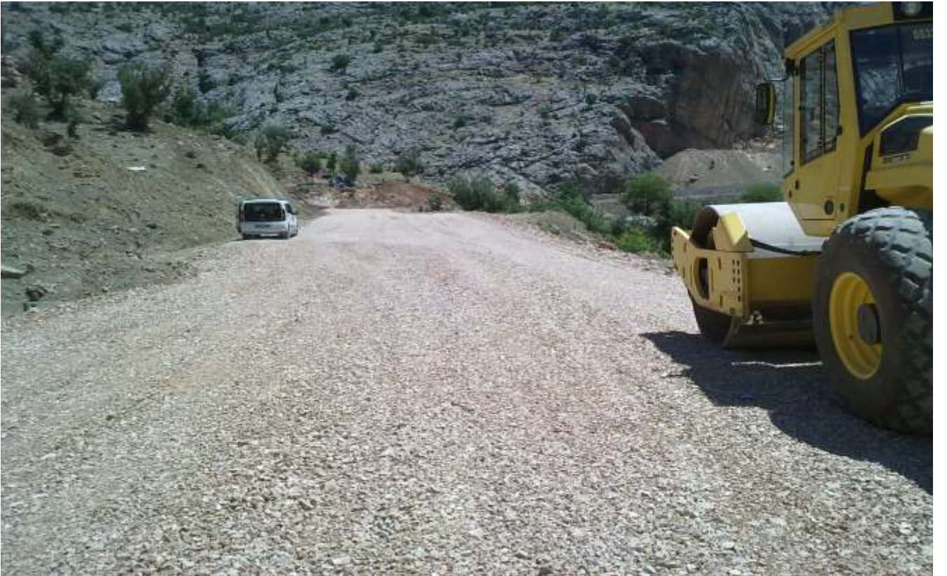
Köy Yolları Asfaltta Hazır Hale Getirme Çalışması
