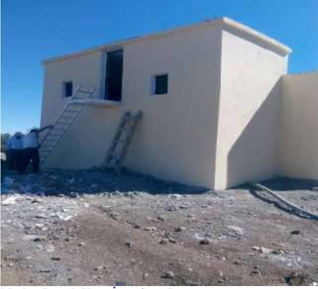
Merkez Boyatlı Köyü İçme Suyu Deposu
