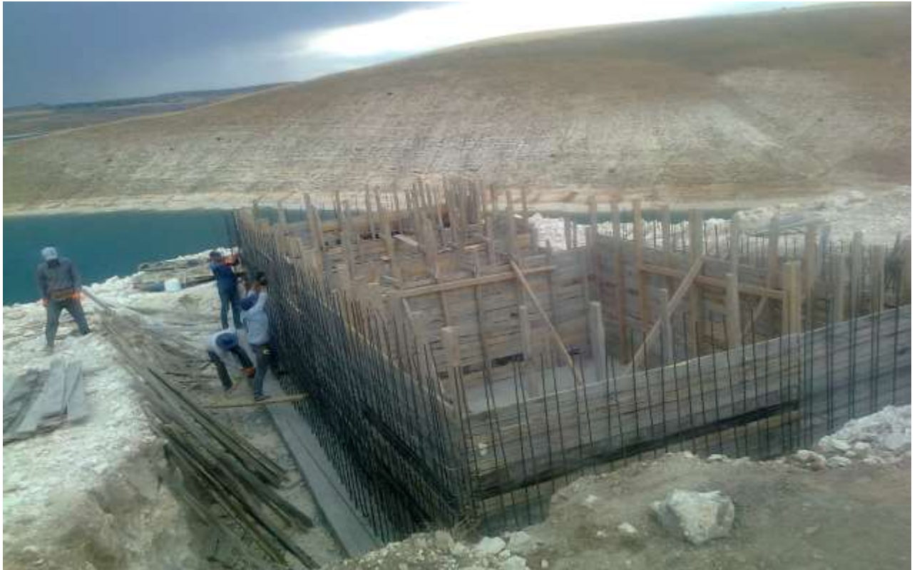
Kahta İlçesi Yeşilkaya Köyü Kanalizasyon Tesisi Çalışması
