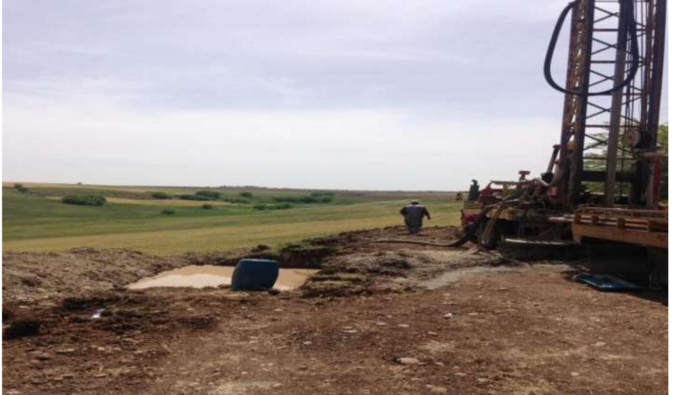
Merkez Küçük Hasancık Köyü Sondaj Çalışması
