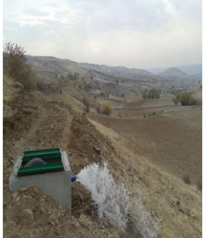
Kâhta Yeniköy Köyü Narlık Mezrası Tarımsal Sulama Tesisi
