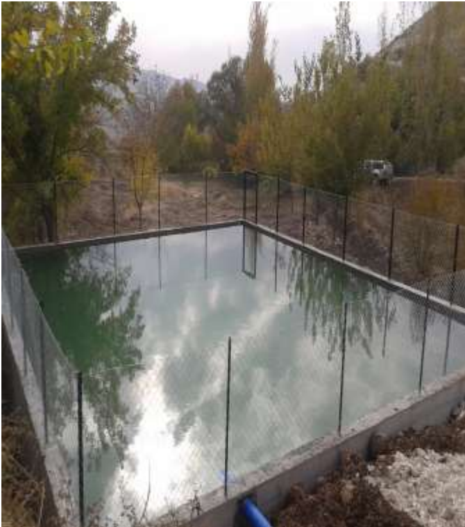
Kâhta Yeniköy Köyü Narlık Mezrası Tarımsal Sulama Tesisi
