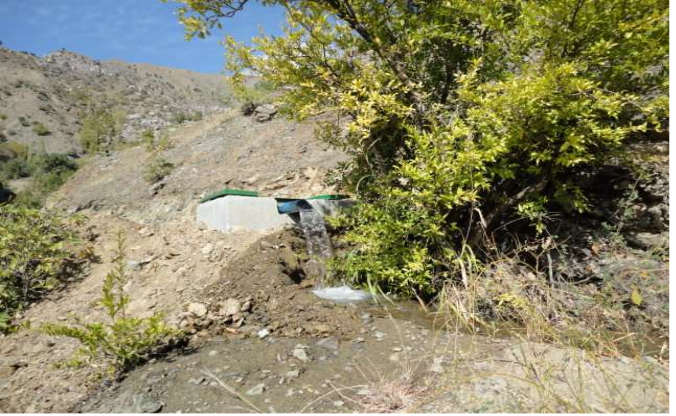
Sincik İlçesi Hüseyin Köyü Yüksekova Mezrası Tarımsal Sulama Tesisi
