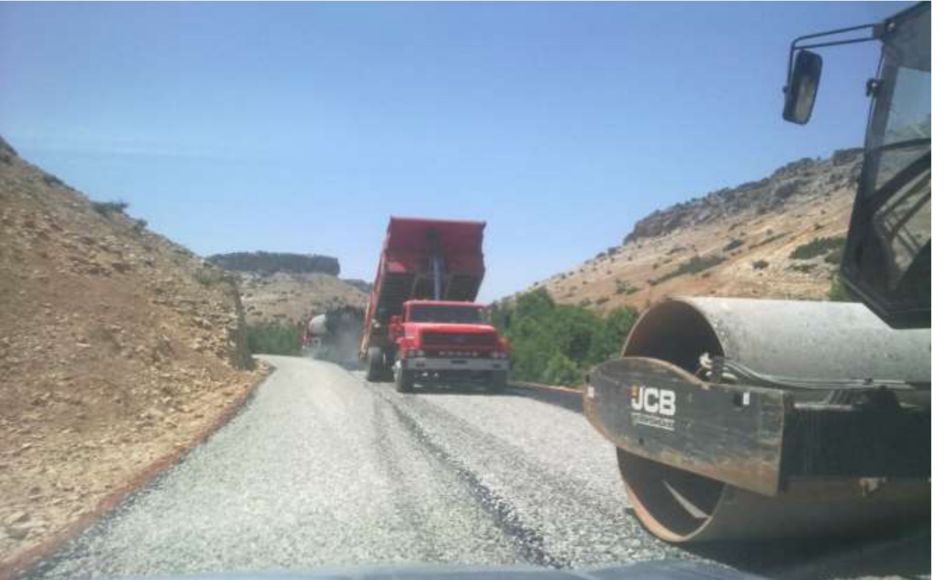
Köy Yolları Asfalt Çalışması
