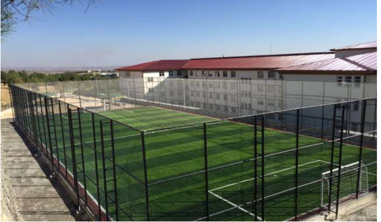
Merkez İndere Köyü 32 Derslikli İlköğretim Okulu
