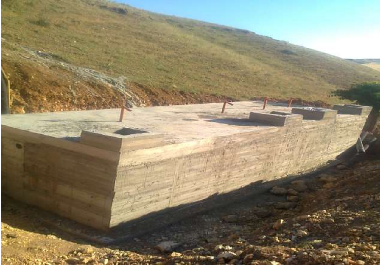
Kahta İlçesi Beşikli Köyü Kanalizasyon Tesisi Çalışması
