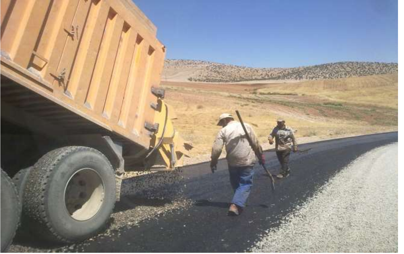
Köy Yolları Asfalt Çalışması
