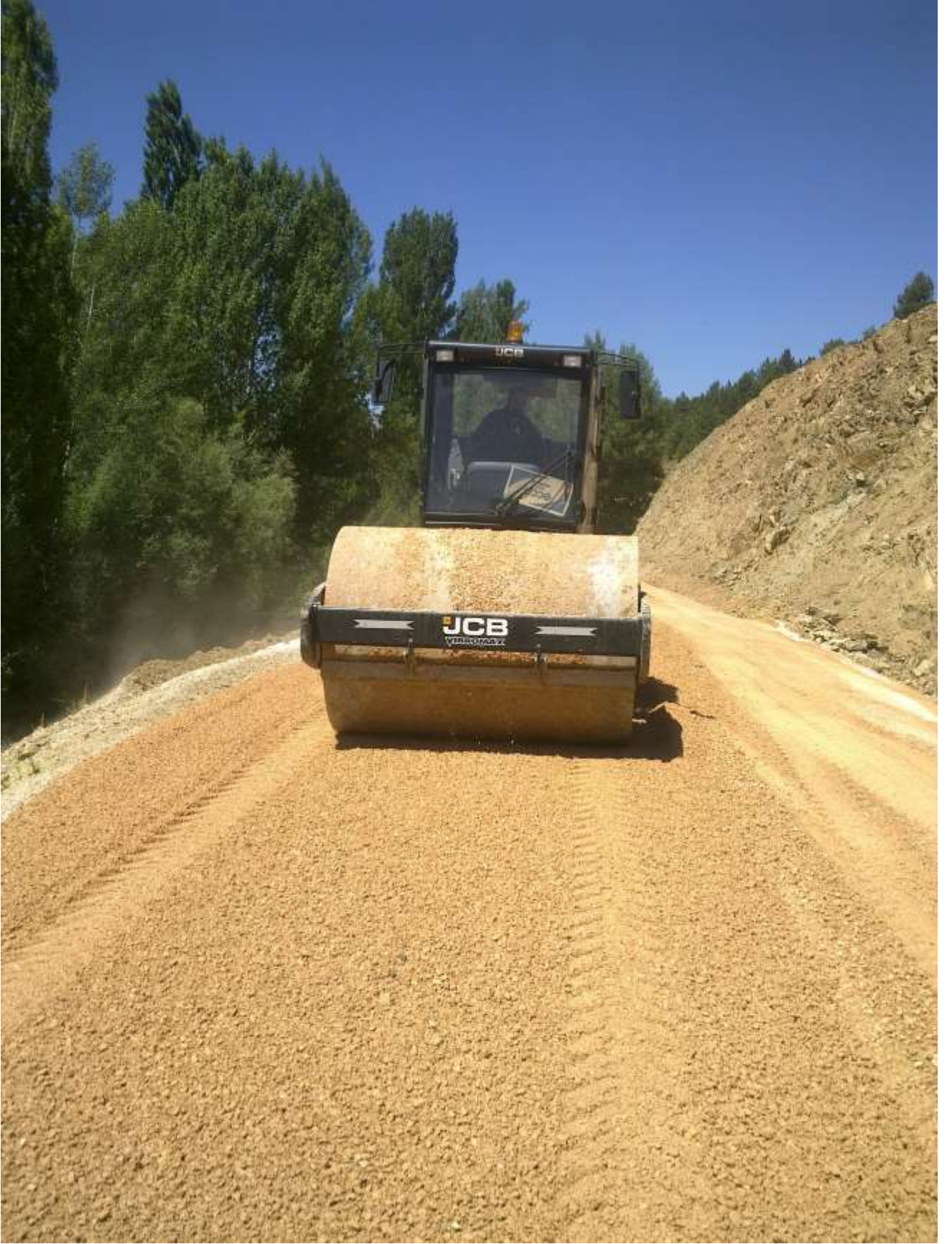
Köy Yolları Asfaltta Hazır Hale Getirme Çalışması
