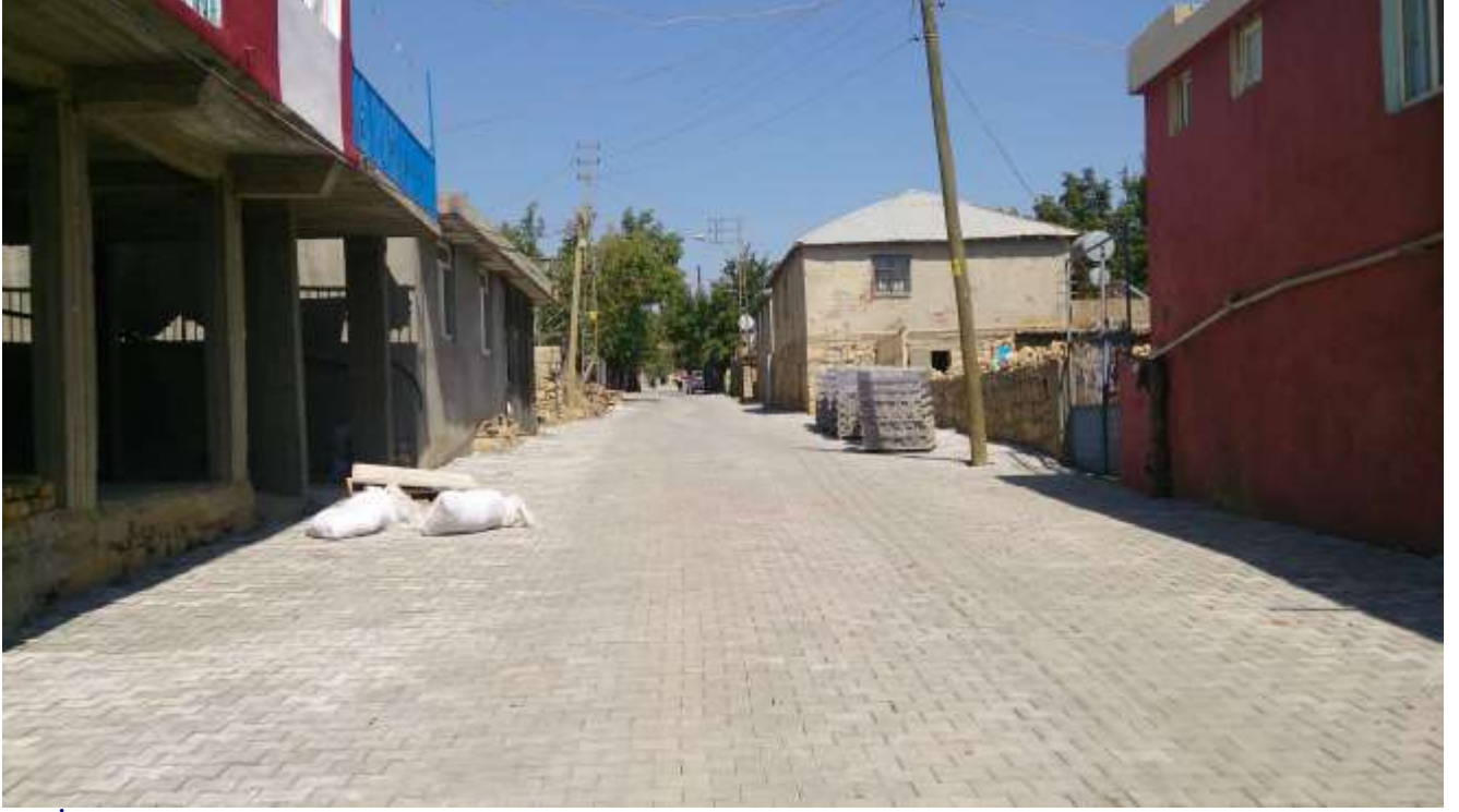
Köy İçi Kilitli Parke Taşı Döşeme Çalışması
