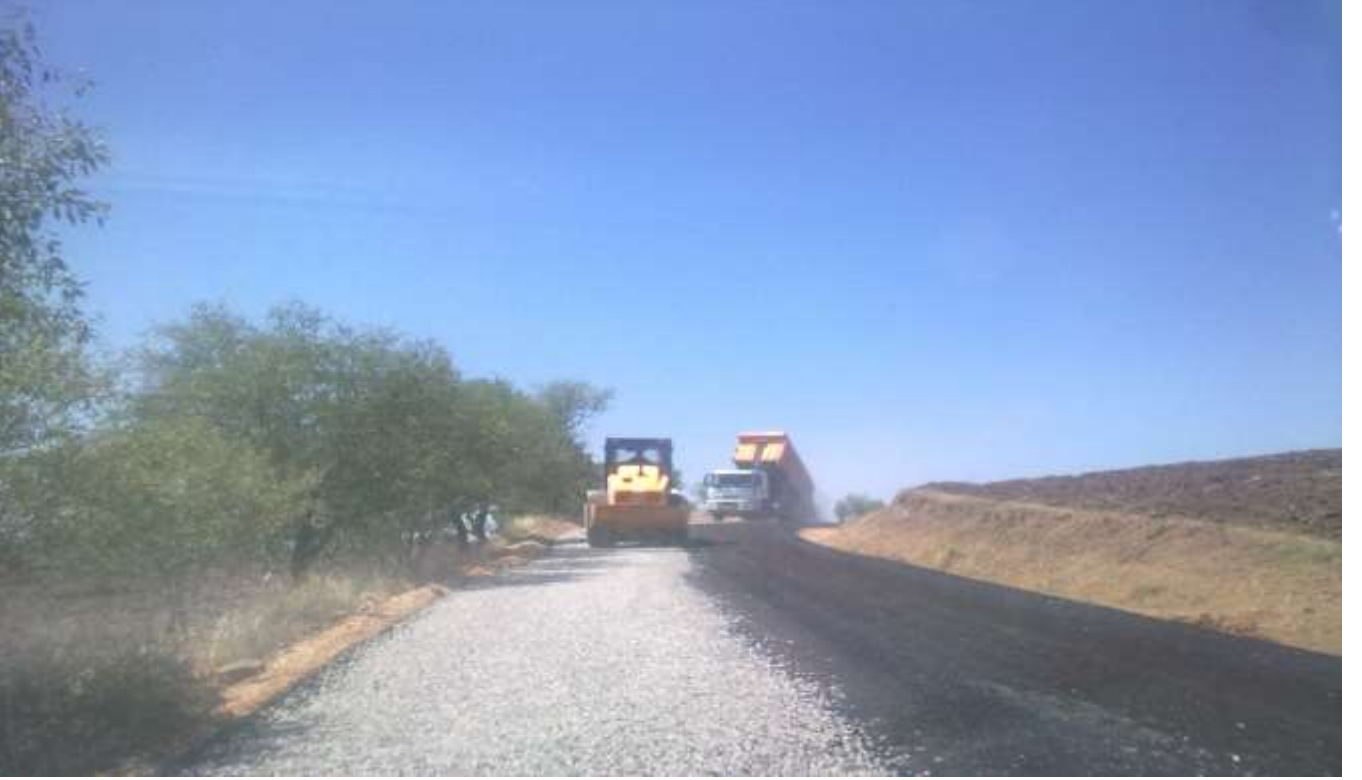
Köy Yolları Asfalt Çalışması
