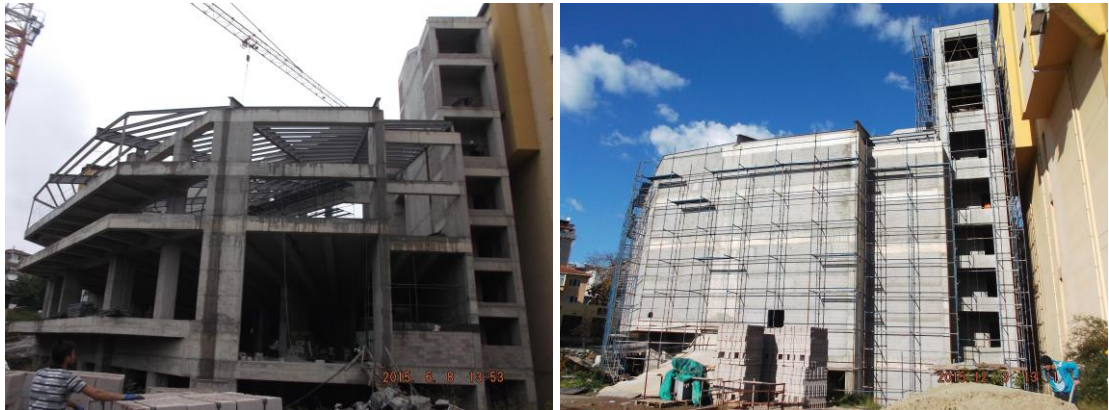
Bağlarbaşı Yerleşkesi Kültür Merkezi Yapım İşİ
