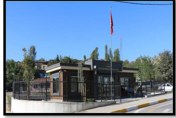
Yayalar Mahallesi Muhtarlık Binası
