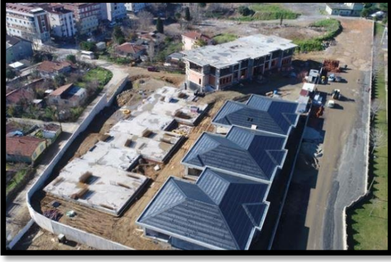
Fevzi Çakmak Mahallesi Engelsiz Yaşam Merkezi Binaları Yapımı
