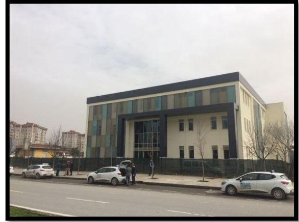
Çamlık Mahallesi Engelliler Eğitim ve Rehabilitasyon Merkezi Yapımı
