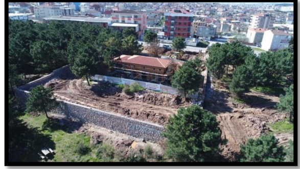
Yenişehir Mahallesi Mesire Alanı İçerisine Kır Kahvesi Yapımı
