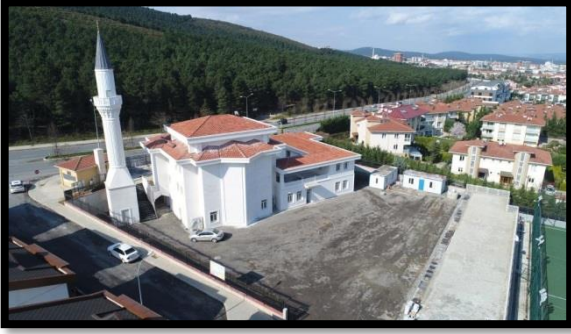
Hz. Adem Cami ve Park Yapımı
