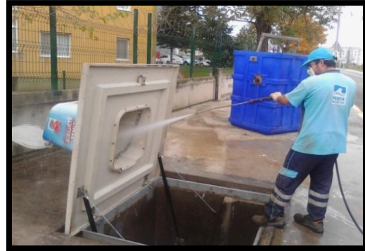
Yeraltı Çöp Konteyneri Yıkama İşlemi
