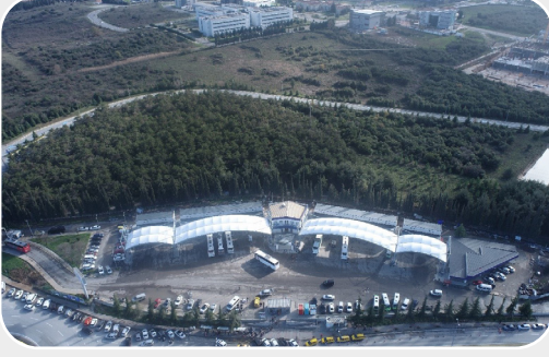
Gebze Şehirlerarası Terminal Tadilatı ve İlave İnşaat
