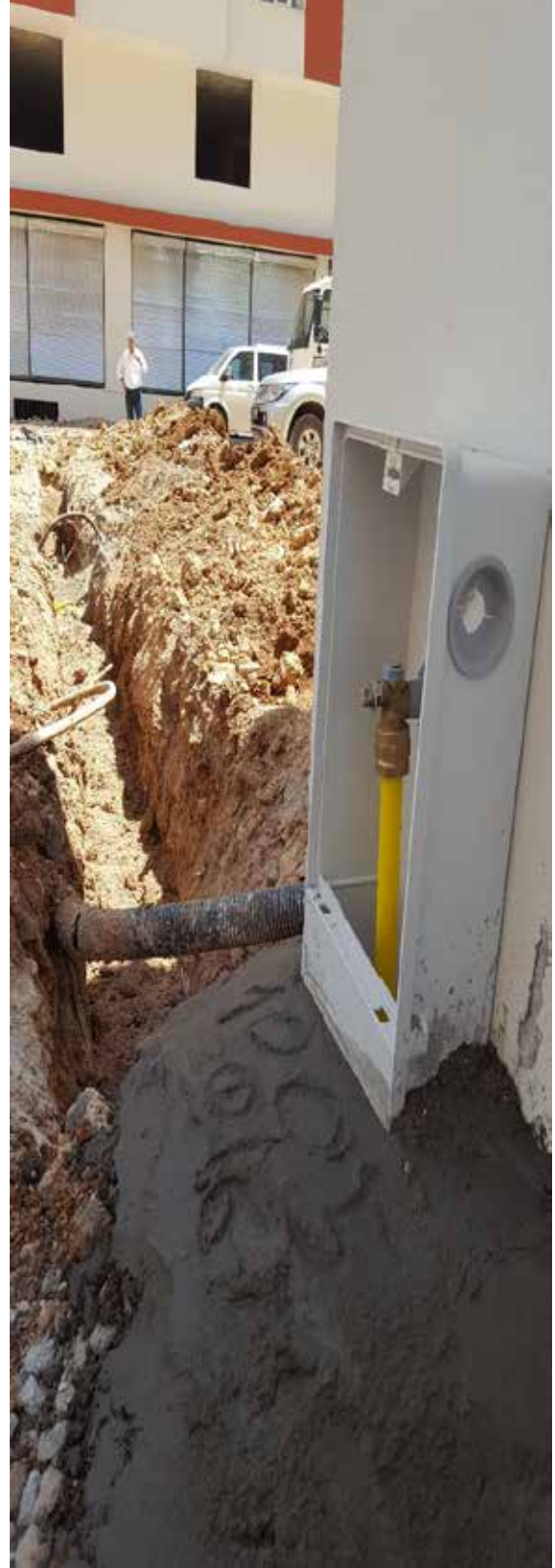
Mardin Kızıltepe İlçesi aşiti mahallesi doğalgaz polietilen boru ile bina bağlantısı çalışması.
