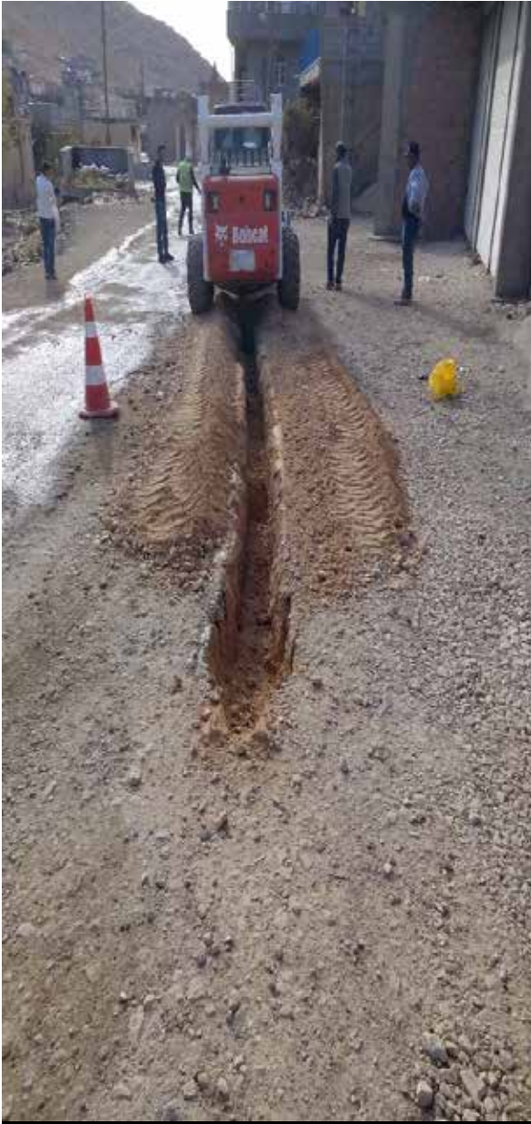
Mardin Kotek Mah.Superonline A.Ş.fiberoptik kablo döşeme bobcat çalışması.
