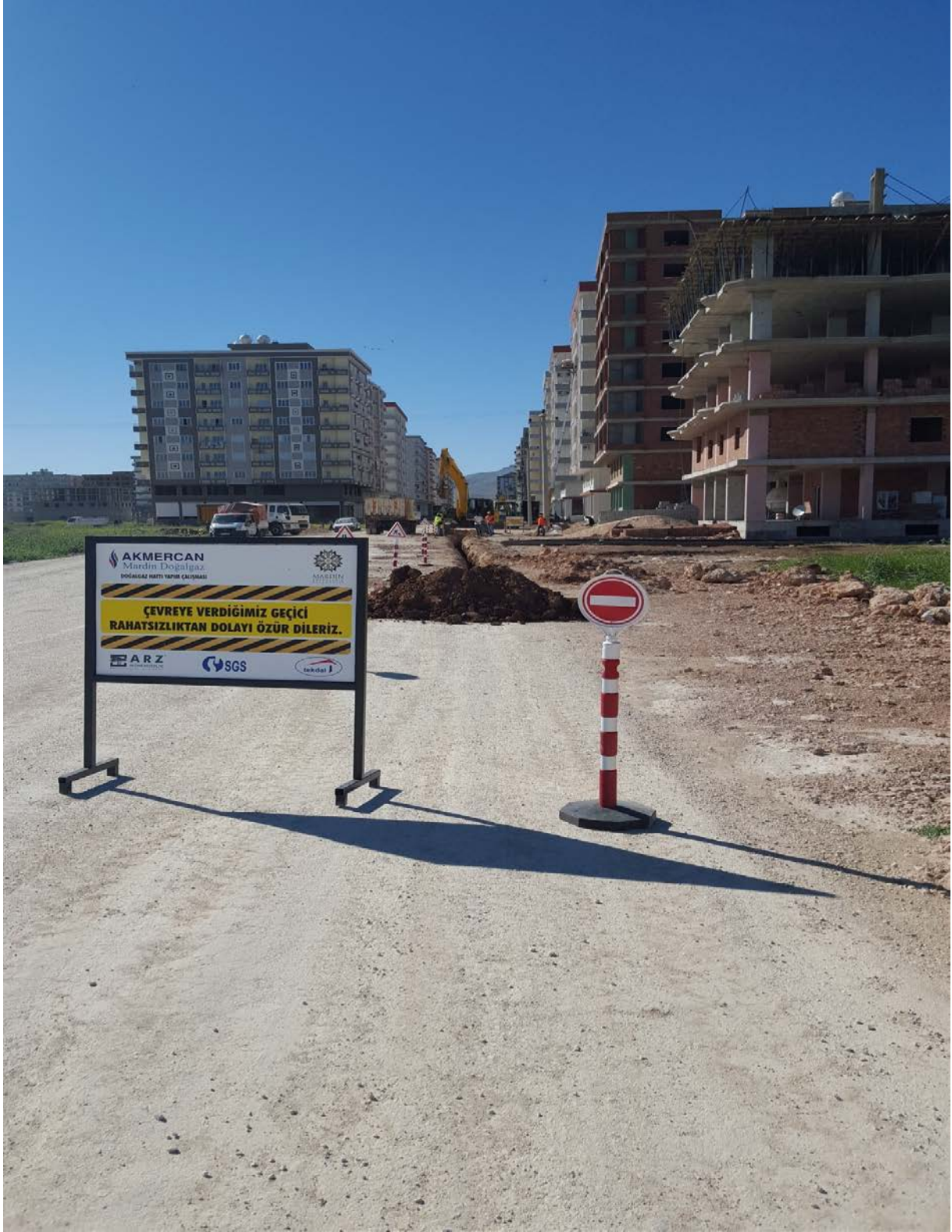
Mardin Kızıltepe İlçesi aşiti mahallesi Doğalgaz çalışması.
