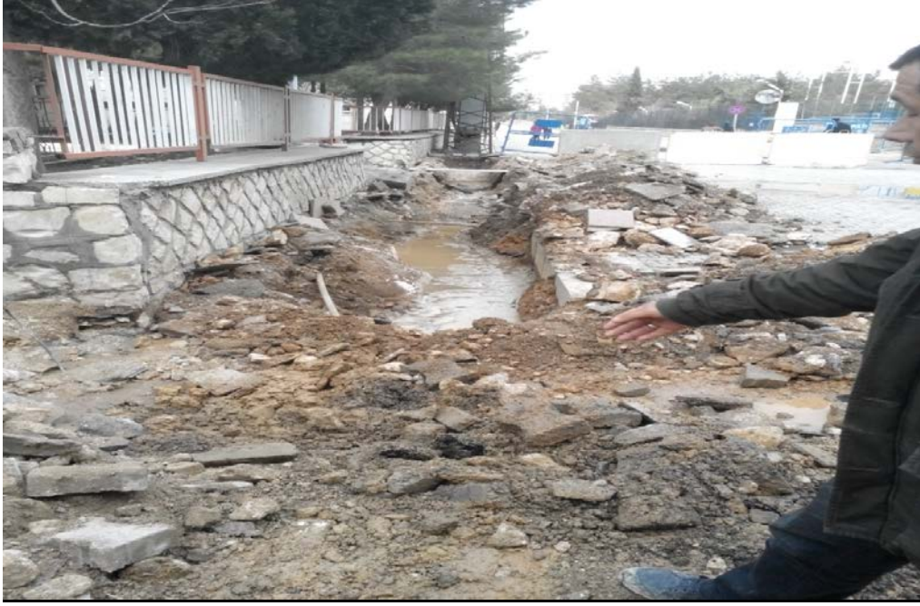
Mardin Artuklu İlçesi 13.mart mahallesi yeraltı enerji hattı döşemesi.
