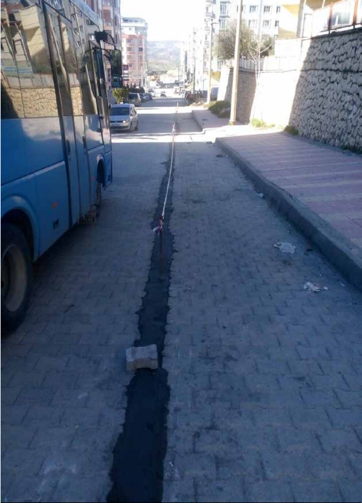
Mardin Superonline A.Ş. fiberoptik kablo döşeme sonrası betonlama işi.
