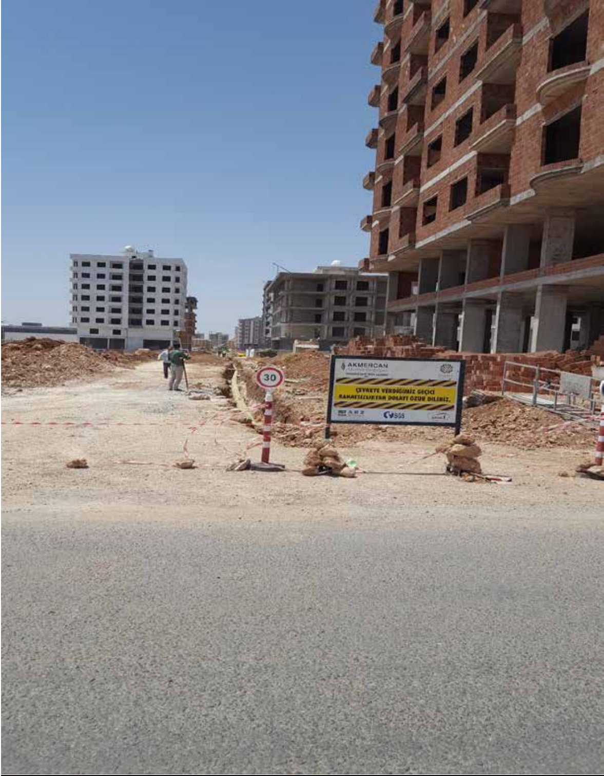
Mardin Kızıltepe İlçesi aşiti mahallesi Doğalgaz hattı döşemesi.
