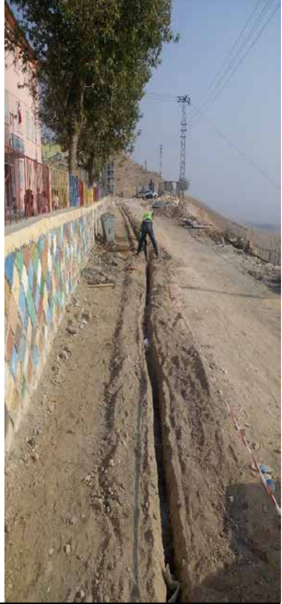
Mardin Kotek Mah.Superonline A.Ş.fiberoptik kablo döşeme bobcat çalışması.
