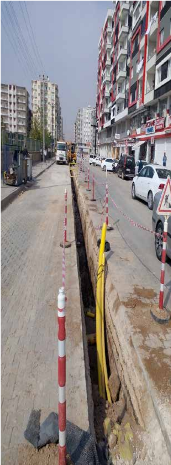
Mardin Kızıltepe İlçesi aşiti mahallesi doğalgaz polietilen boru ile bina bağlantısı çalışması.
