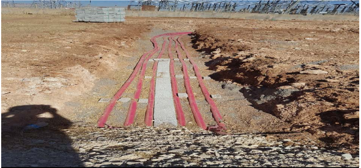
Mardin-Kızıltepe İlçesi Aşıti Mah. Dedaş yeraltı AG-OG ASOP yapım işi.
