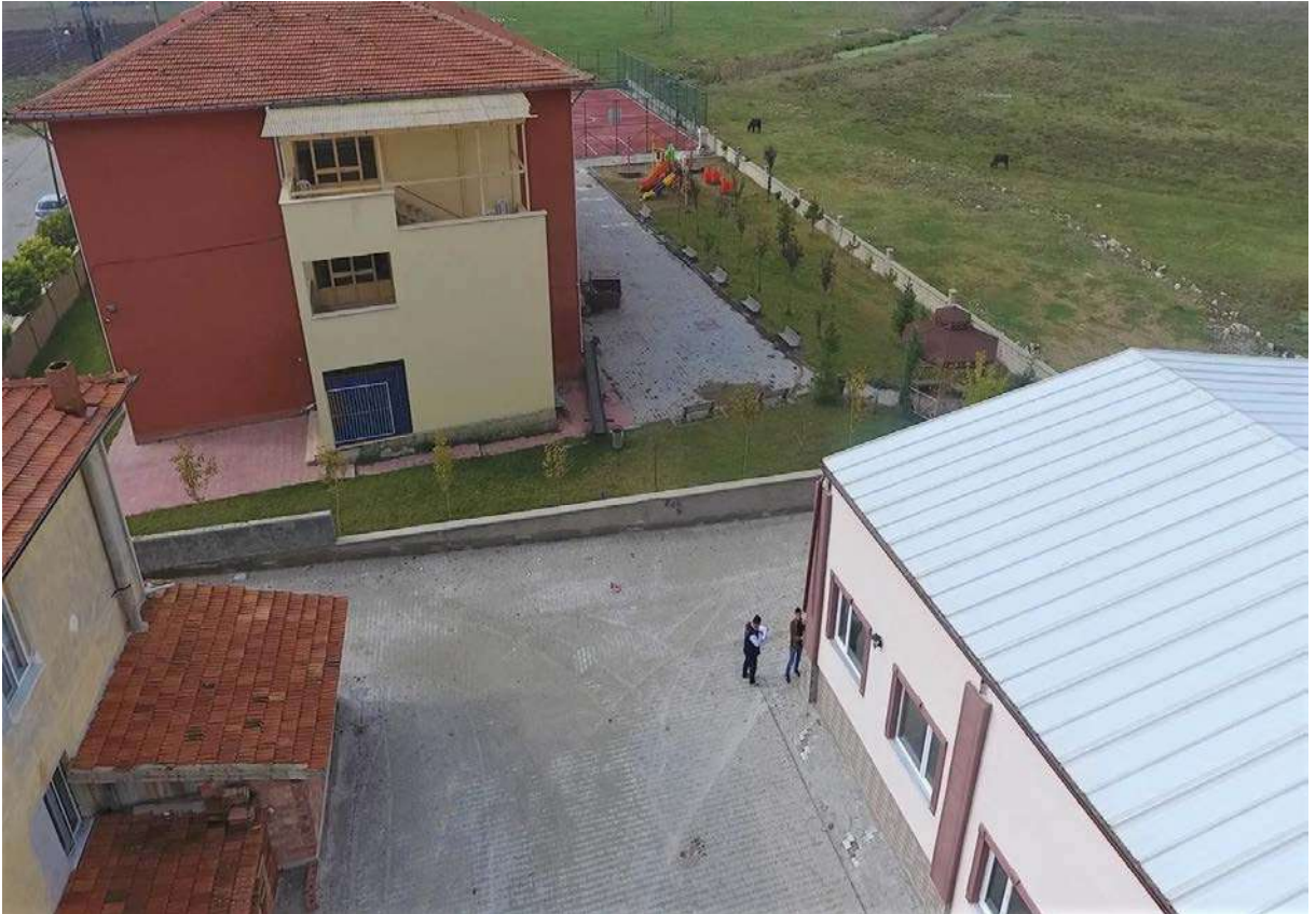
Çardaklı Mahallesi düğün salonu beton parke taş ölçümleri
