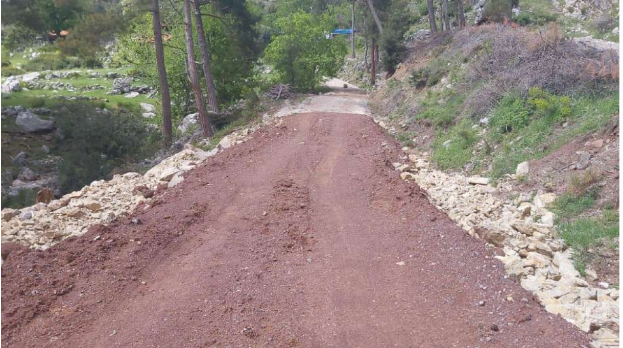
İlgi Fotoğraf: Demirciler Mahallesinde heyelan olan yolun onarım çalışması yapıldıktan sonraki hali.
