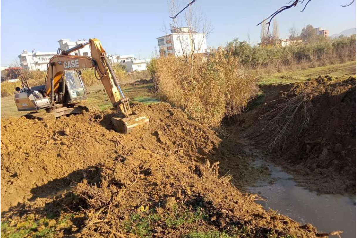
İlgi Fotoğraf: Kökez Mahallesi dere temizlik çalışması yapılmıştır.
