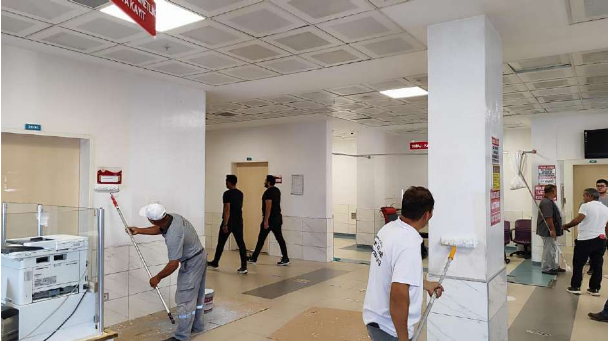
İlgi Fotoğraf: Merkez Mahallesi Devlet Hastanesi iç cephe duvar boyama çalışması yapılmıştır.
