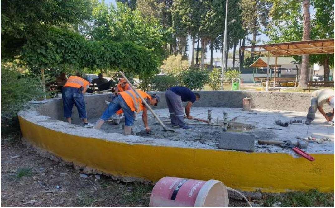
İlgi Fotoğraf: İlçemiz genelinde havuz temizliği, yenilemesi ve bakım çalışmaları yapılmıştır.
