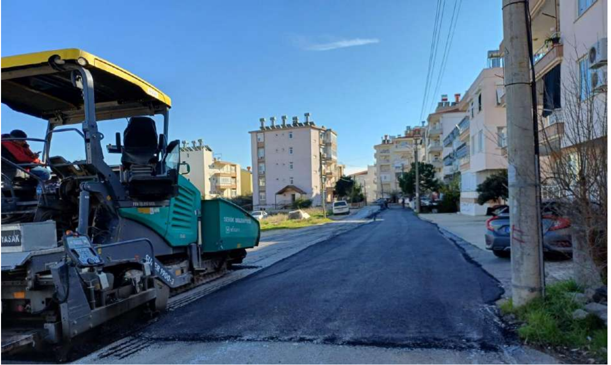
İlgi Fotoğraf: Akçaalan Mahallesi 4201 Sokak sıcak asfalt serim çalışması yapılmıştır.
