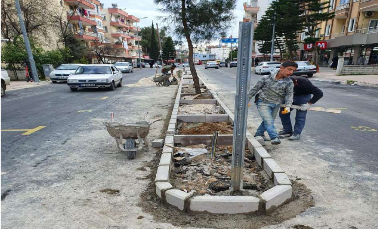
İlgi Fotoğraf: Merkez Mahallesi Azmi Akman Caddesi refüj çalışması yapılmıştır.
