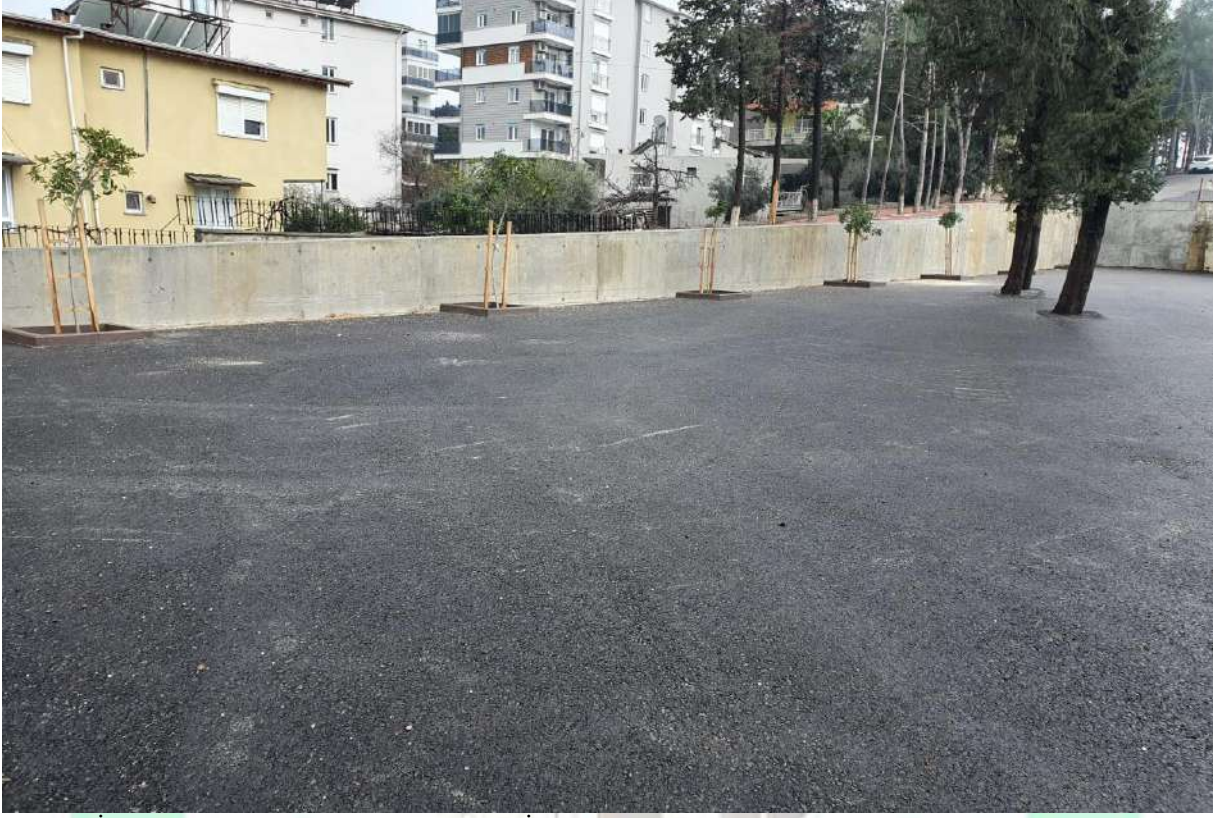
İlgi Fotoğraf: Merkez Mahallesi 9 Mart İlkokulu bahçesi sıcak asfalt serim çalışması yapılmıştır.
