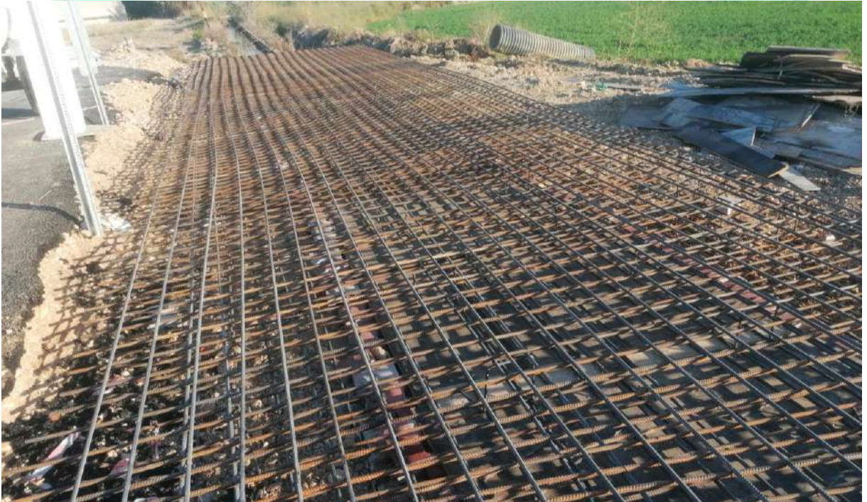
İlgi Fotoğraf: Gedik Mahallesi Akasya Caddesi köprü yapım çalışması yapılmıştır.
