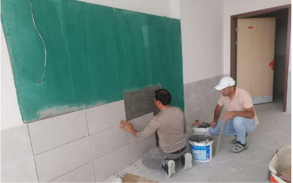
İlgi Fotoğraf: Gedik Mahallesi Gedik Ortaokulu fayans kaplama ve akıllı tahta boyama çalışması yapılmıştır.
