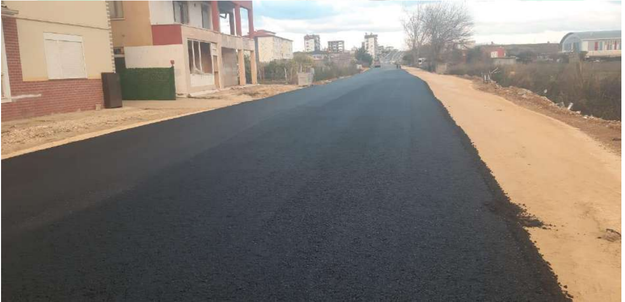
İlgi Fotoğraf: Gedik Mahallesi Akasya Caddesi sıcak asfalt serim çalışması yapılmıştır.
