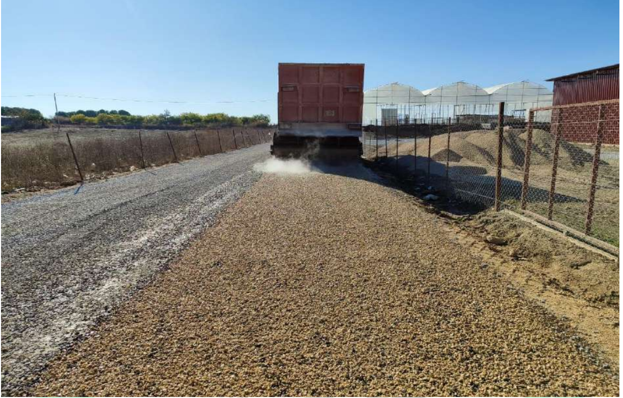
İlgi Fotoğraf: Eminceler Mahallesi sathi asfalt serim çalışması yapılmıştır.
