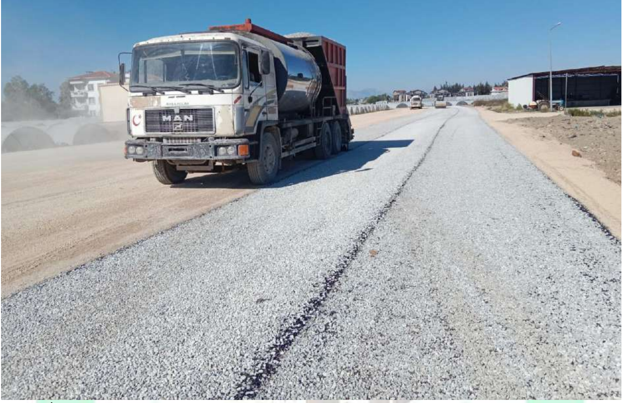
İlgi Fotoğraf: Kadriye Mahallesi 35 Sokak sathi asfalt serim çalışması yapılmıştır.
