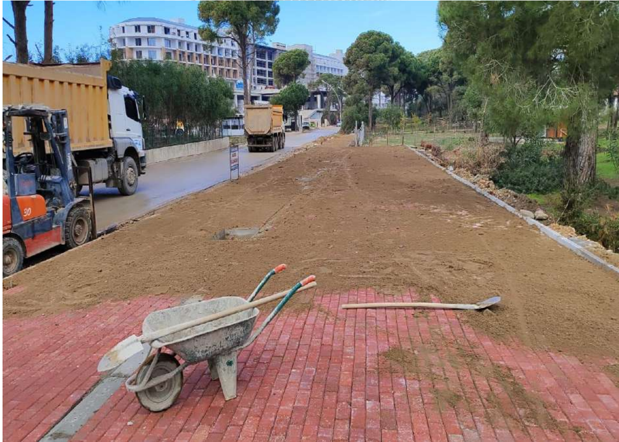
İlgi Fotoğraf: İlçemiz genelinde kaldırım yapım çalışmaları yapılmıştır.
