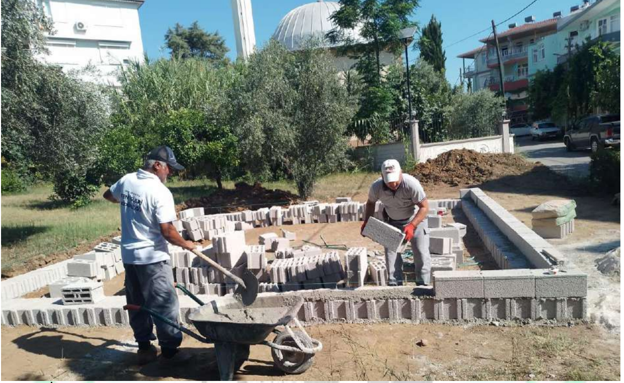
İlgi Fotoğraf: Akçaalan Mahallesi muhtarlık hizmet binası yapım çalışması yapılmıştır.
