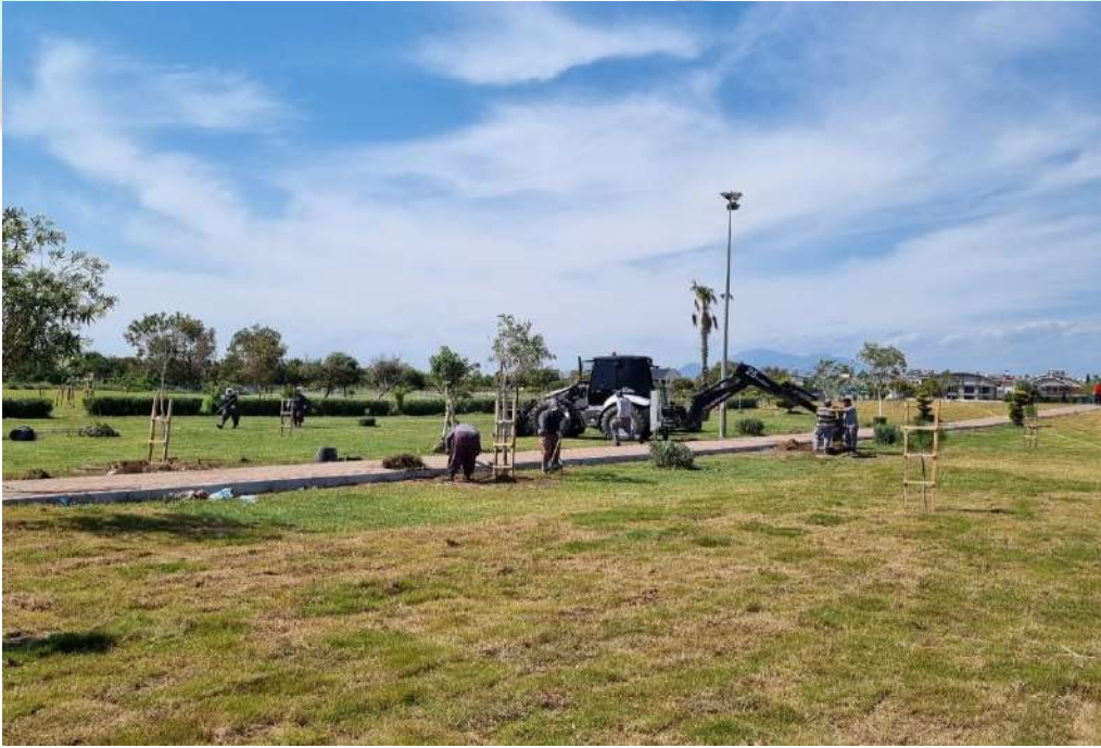
İlgi Fotoğraf: Boğazkent Mahallesi Denizyıldızı restoran çevresi düzenlemesi, elektrik ve sulama hattı çalışmaları, çim serimi, dikim ve peyzaj çalışması yapılmıştır.
