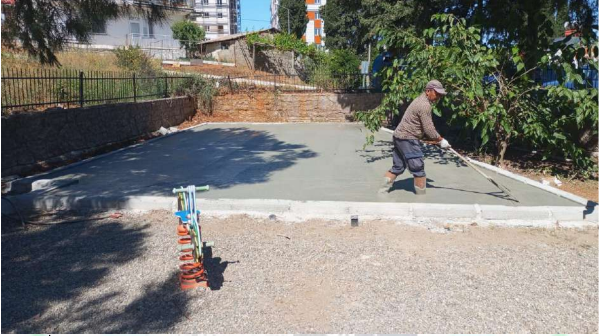
İlgi Fotoğraf: Orta Mahalle Kazım Karabekir Anaokulu Bahçesi oyun alını yapım çalışması yapılmıştır.
