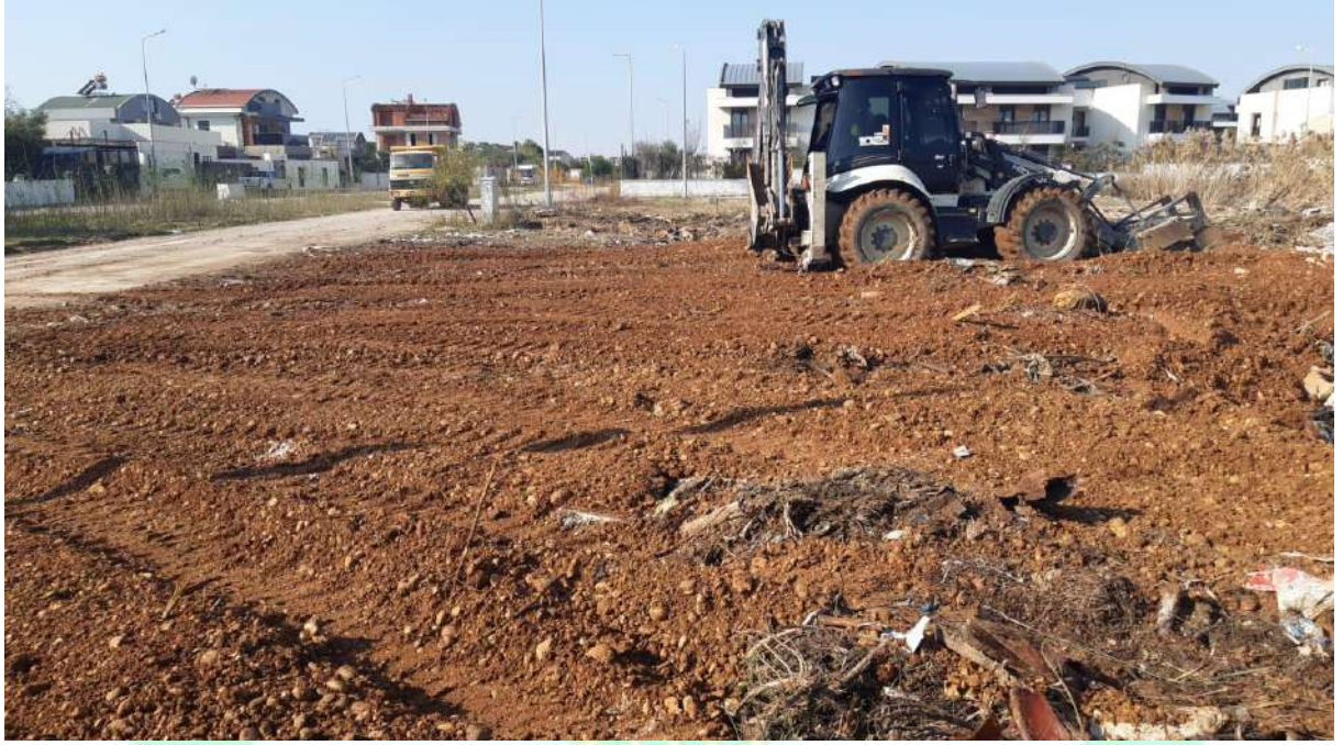
İlgi Fotoğraf: Boş arsa ve arazi temizliği yapılmıştır.
