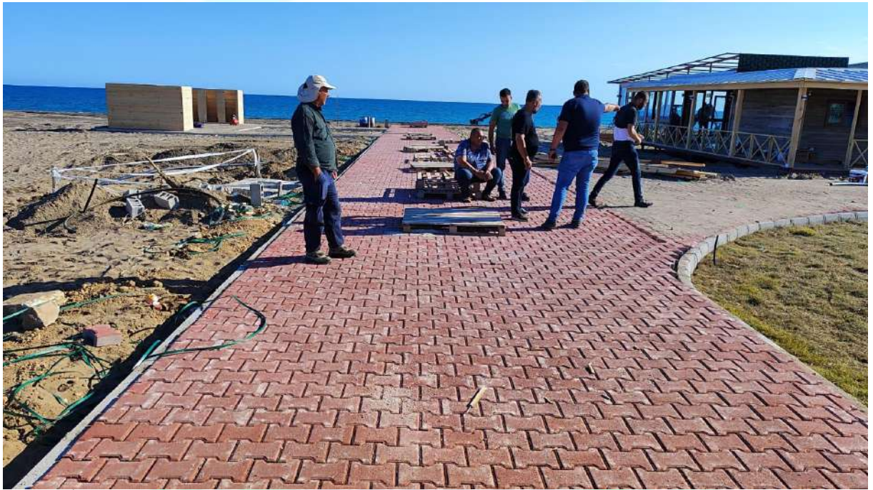
İlgi Fotoğraf: Boğazkent Mahallesi halk plajı kilitli parke taşı döşeme çalışması yapılmıştır.
