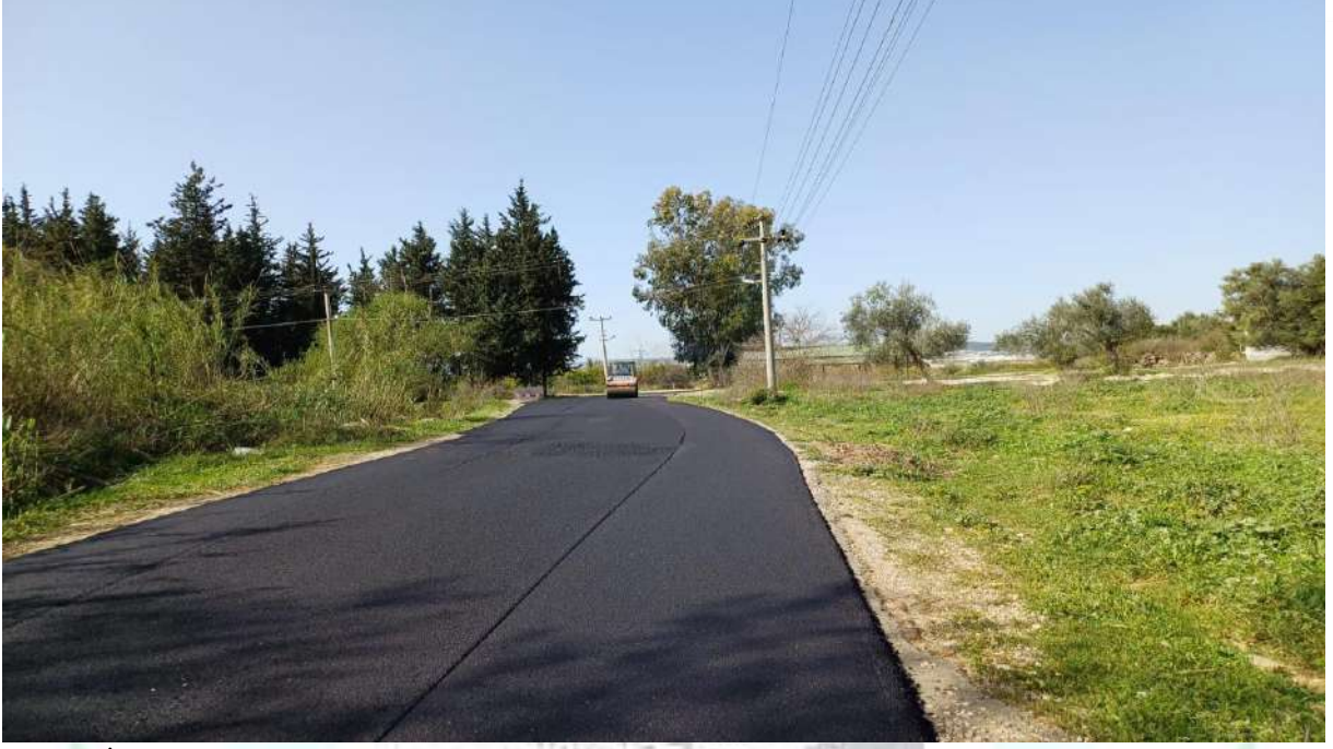
İlgi Fotoğraf: Aşağıoba Mahallesi sıcak asfalt serim çalışması yapılmıştır.
