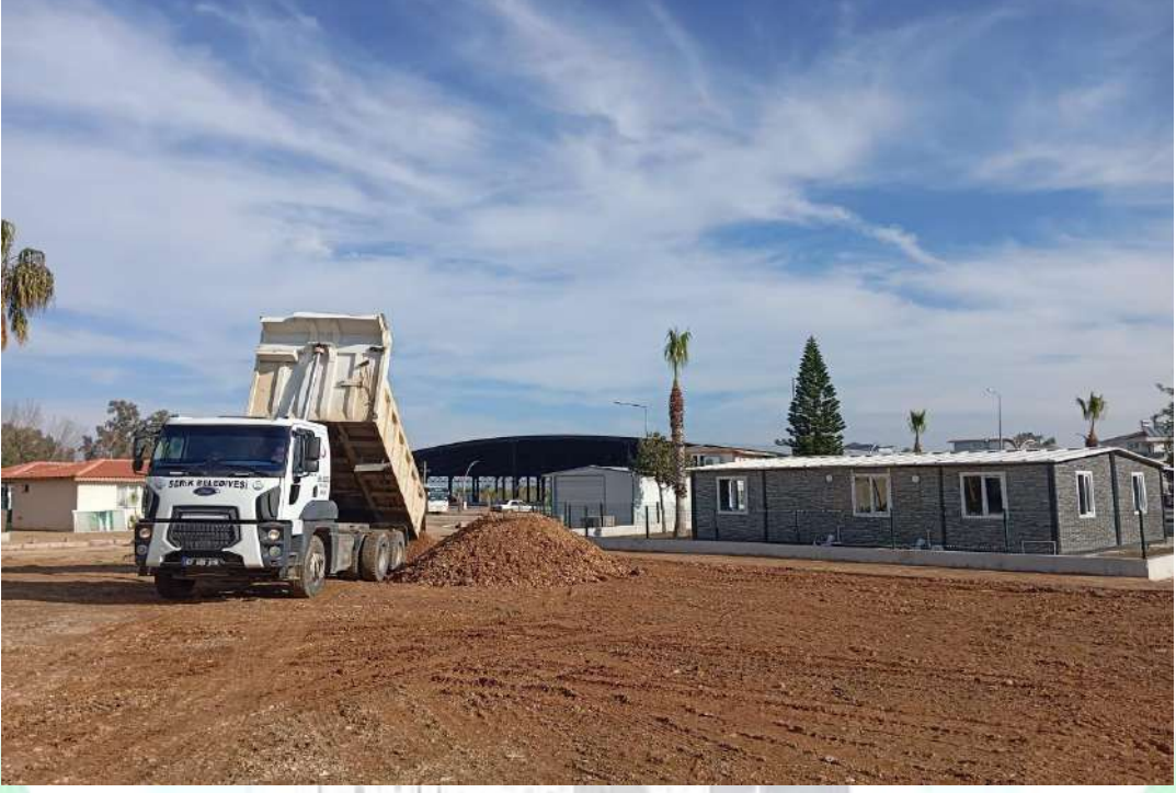
İlgi Fotoğraf: Belek Mahallesi Atatürk Caddesinde bulunan parkta Kuran Kursu tamamlanmış, peyzaj çalışması yapılmıştır.
