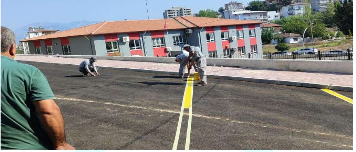
İlgi Fotoğraf: Okul bölgesi çalışmaları.
