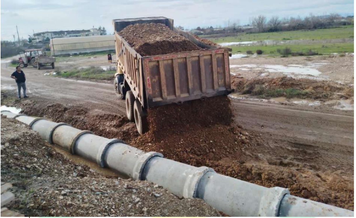
İlgi Fotoğraf: Merkez Mahallesi büz uygulama çalışması yapılmıştır.
