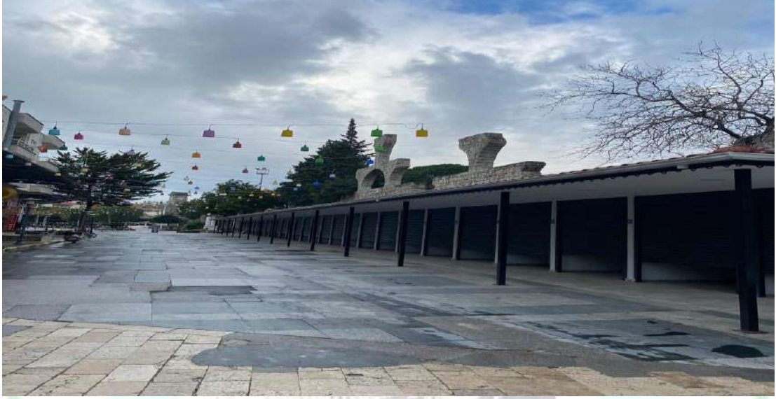
İlgi Fotoğraf: Belek El İş Pazarı yapım aşaması tamamlanmıştır.
