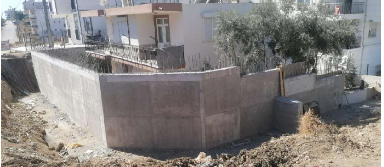
İlgi Fotoğraf: Merkez Mahallesi 2044 Sokak istinat duvarı yapım çalışması yapılmıştır.
