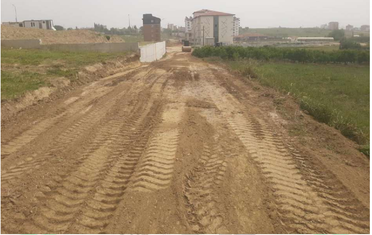
İlgi Fotoğraf: Gedik Mahallesi imar yolu açma çalışması yapılmıştır.
