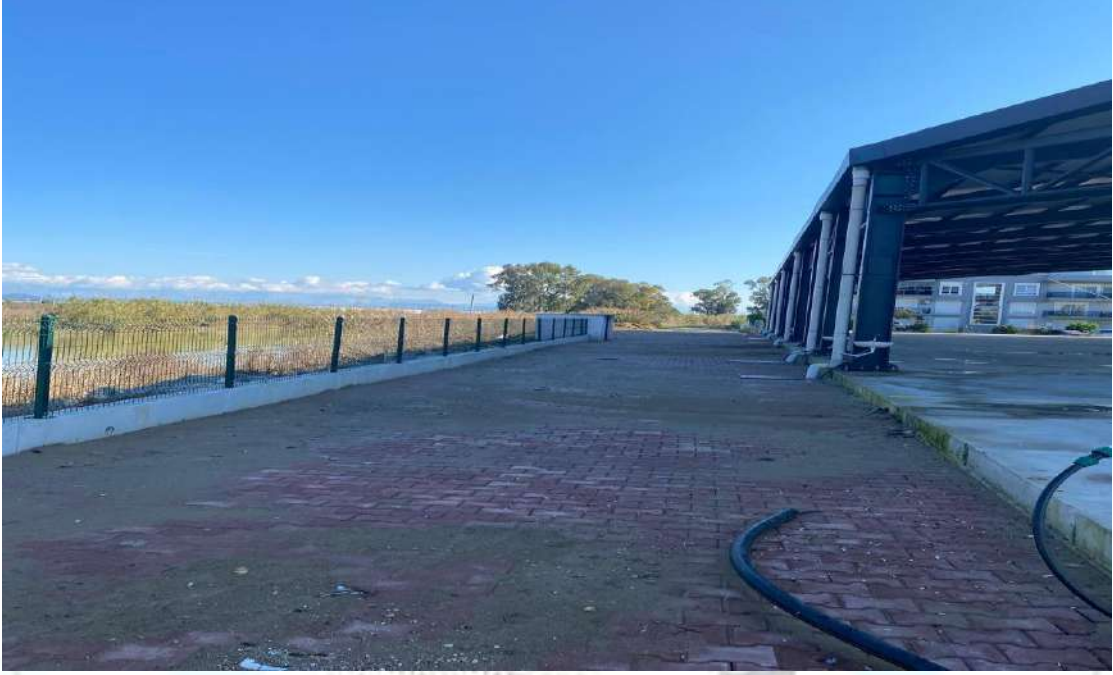
İlgi Fotoğraf: Belek Mahallesi Kapalı Pazar Acısı kenarına duvar, zeminde kilitli parke taş ve duvar üstü panel tel montaj çalışmaları yapılmıştır.
