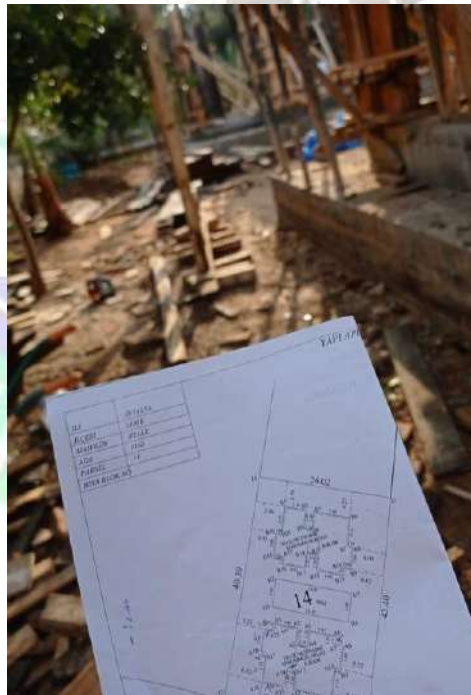
Şekil 10 : Belek Mahallesi Arazi Kontrolü
