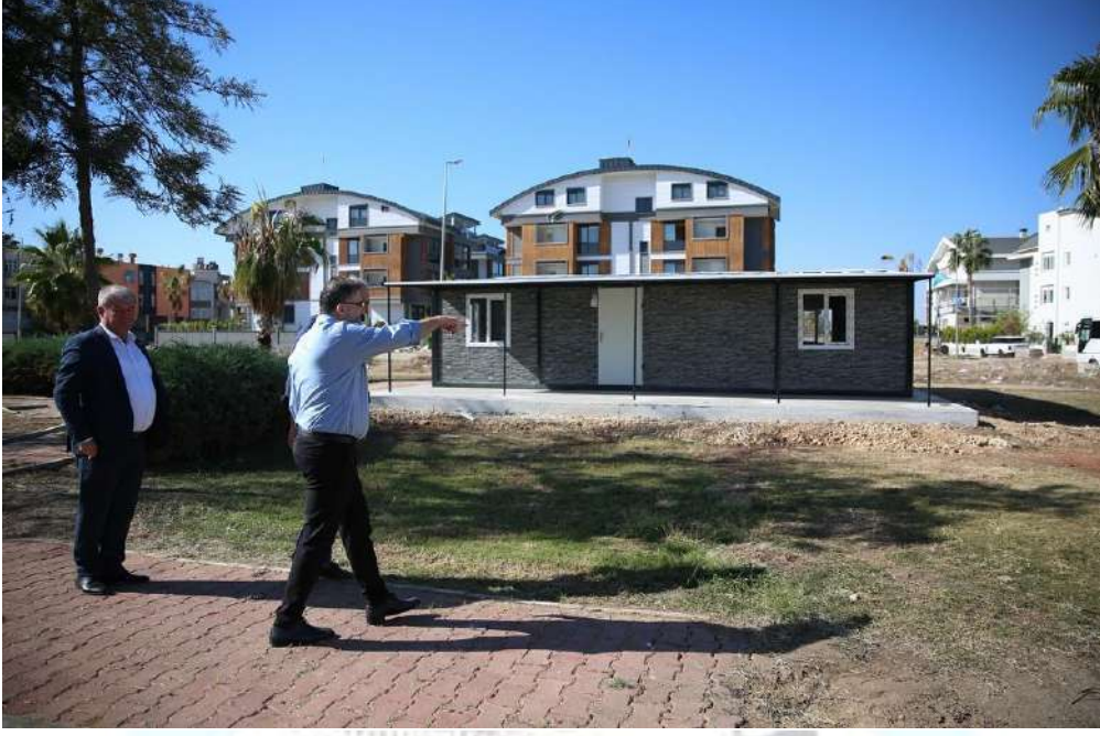
İlgi Fotoğraf: 6 Kasım 2024, Belek Mahallemizde yapımı devam eden Kur'an Kursumuzu yerinde inceledik.
