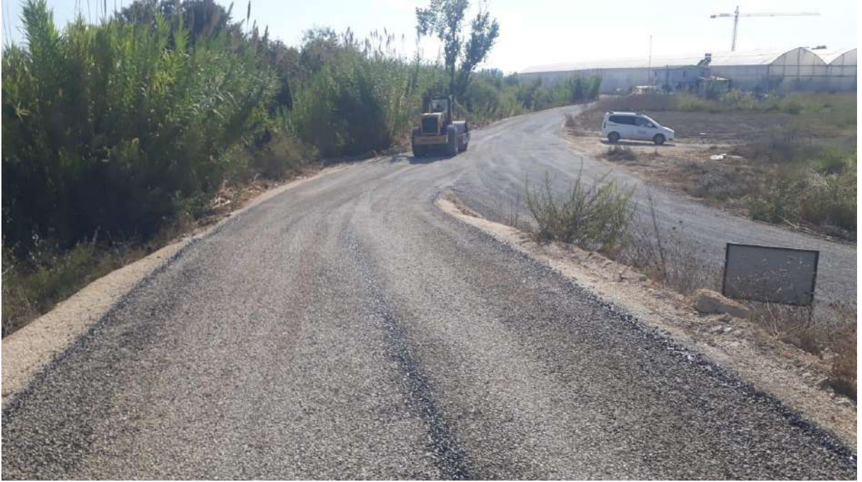
İlgi Fotoğraf: Çandır Mahallesi sathi asfalt serim çalışması yapılmıştır.
