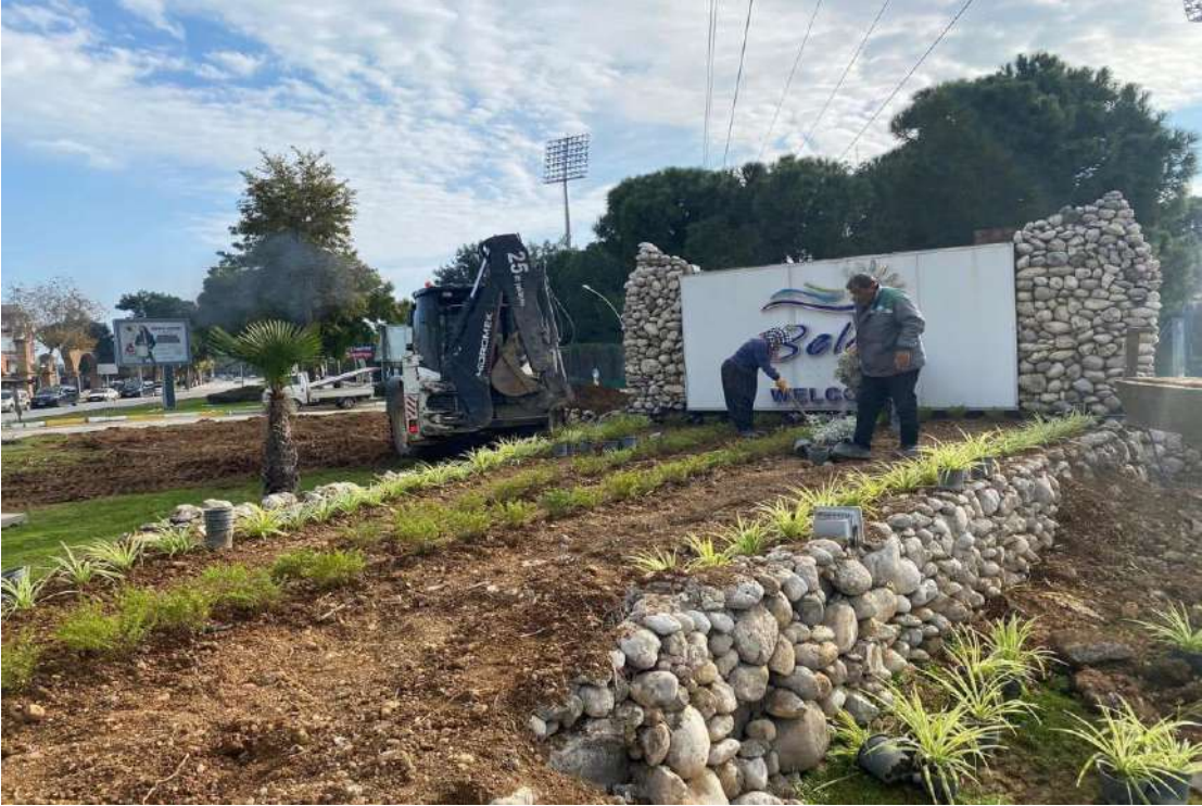
İlgi Fotoğraf: Belek Kavşağı yenileme çalışmaları yapılmıştır.
