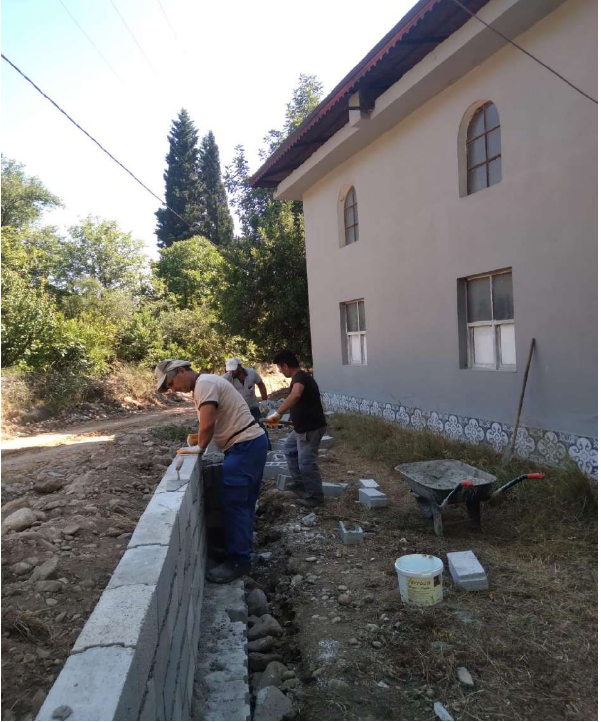
İlgi Fotoğraf: Gebiz Mahallesi Gökveliler Camii bahçe duvarı örüm çalışması yapılmıştır.
