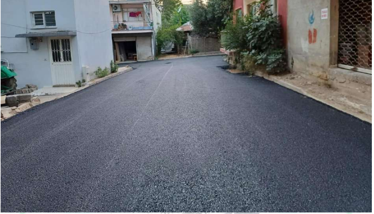
İlgi Fotoğraf: Merkez Mahallesi 2152 Sokak sıcak asfalt serim çalışması yapılmıştır.
