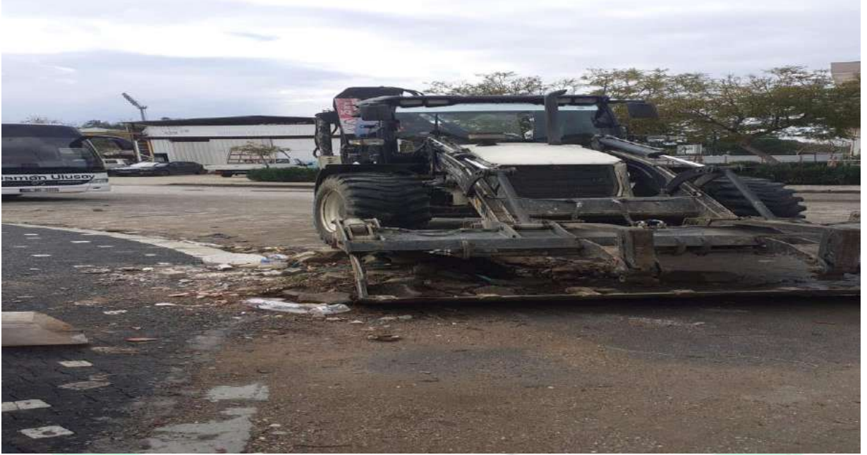
İlgi Fotoğraf: Hafriyat atıkları kaldırma hizmetleri yapılmaktadır.
