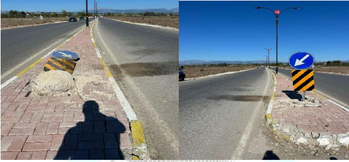
İlgi Fotoğraf: Yıkılmış olan uyarıcı ve yönlendirici trafik levhaları yenilenmiştir.
