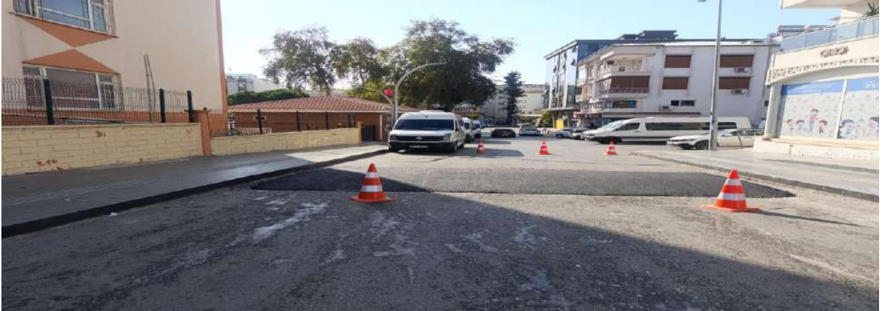
İlgi Fotoğraf: Kasis çalışmaları kontrolleri yapılmıştır.
