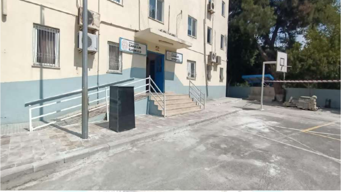
İlgi Fotoğraf: Kadriye Çakallık Ortaokulu giriş zemin tadilatı ve çeşme kaplama işlemi yapılmıştır.
