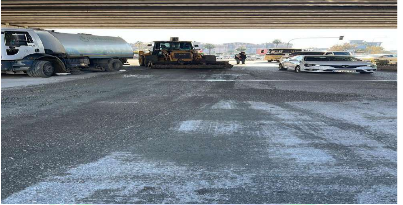
İlgi Fotoğraf: Temizlik ve asfalt çalışmalarında yol güvenlik önlemleri alınması.
