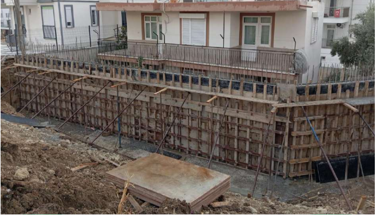
İlgi Fotoğraf: Merkez Mahallesi 2044 Sokak istinat duvarı yapım çalışması yapılmıştır.
