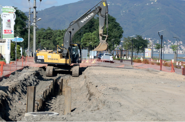
İçme suyu Hattı Yapım Çalışması
