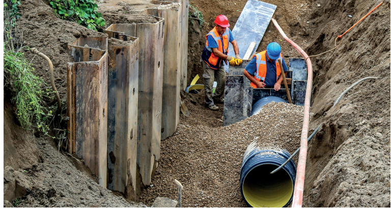
Akyazı Mahallesi Kanalizasyon Hattı Yapım Çalışması
