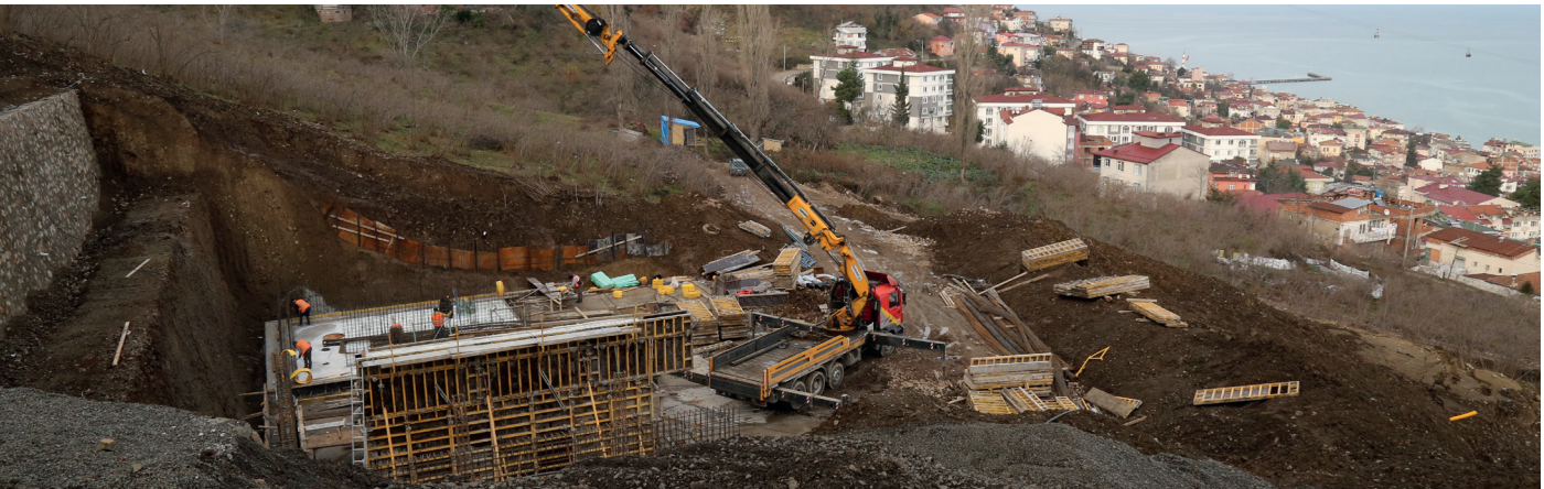
Selimiye Mah. - 2500M3' lük DY7 Depo İnşaatı
