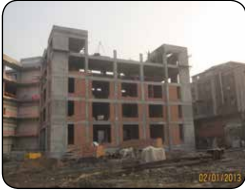
Kağıthane Hizmet Binası İnşaatı
