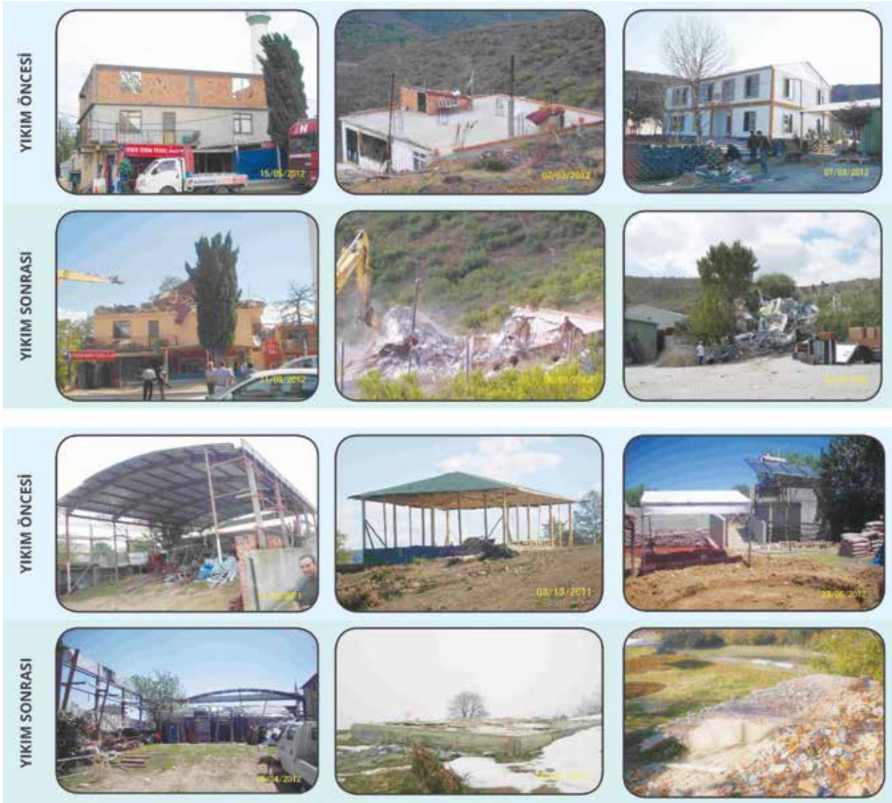
2012 Yılında Yapılan Yıkımlardan Örnekler
