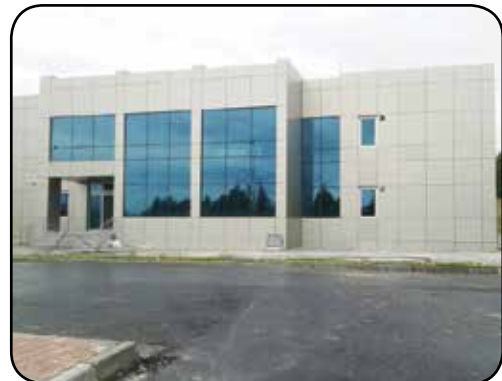
Büyükçekmece Arıtma Tesisi İdari Binası
