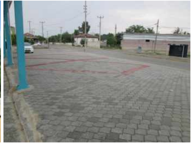
Aşağısamlı Mahallesi Kaldırım Çalışması
