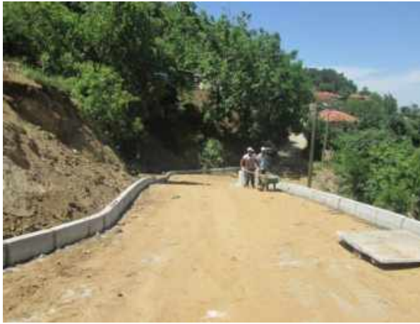
Altındere Mahallesi Kaldırım Çalışması
