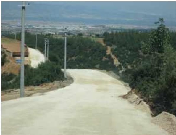
Yeşilyayla Mahallesi Yol Açma Çalışması
