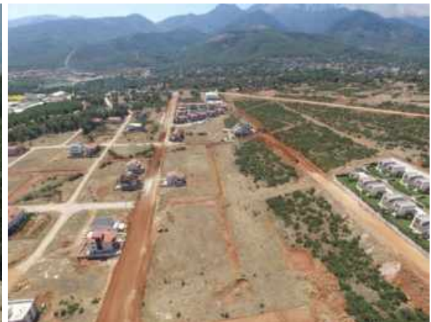
Bahçelievler Mahallesi Yol Açma Çalışması
