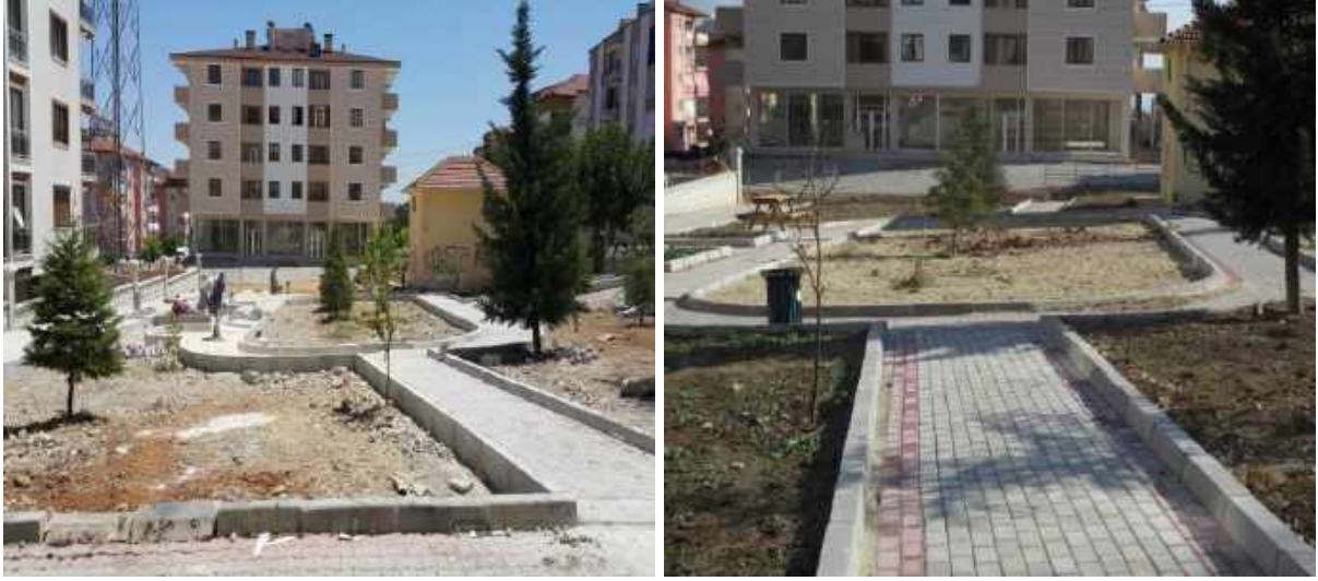
Adalet Mahallesi 10144 Sokak Park Yapımı
