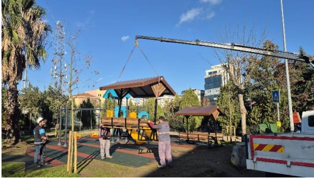
Resim 52 Ahşap Zemin Yenileme ve Boya Çalışması
