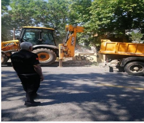
Resim 2 Metruk Yapı Yıkımı
