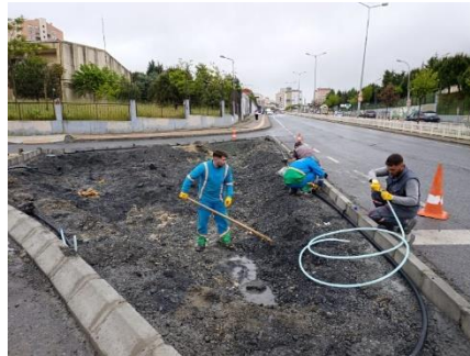
Resim 48 Kayaşehir Rabia Caddesi otomatik sulama sistemi
