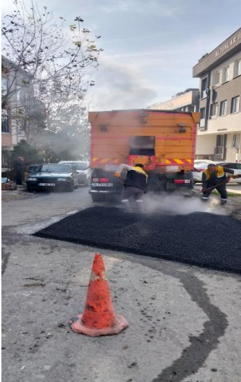
Resim 62 Asfalt Yama Çalışmaları
