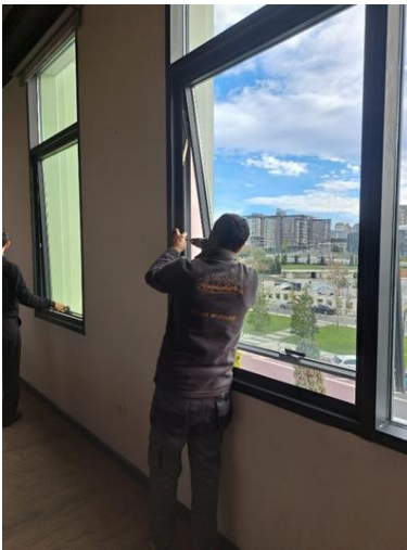
Resim 61 İnşaat Bakım Onarım İşleri
