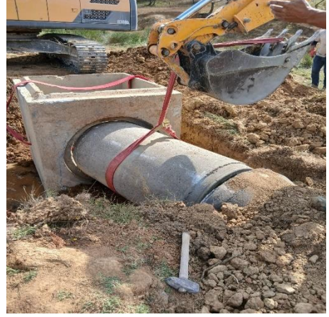
Resim 63 Yağmur Suyu Kanal İmalatı ve
