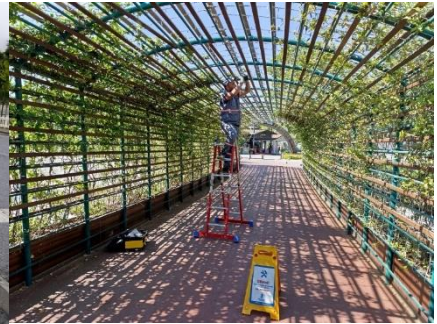
Resim 49 Enerji Besleme Kablosu Onarım çalışması
