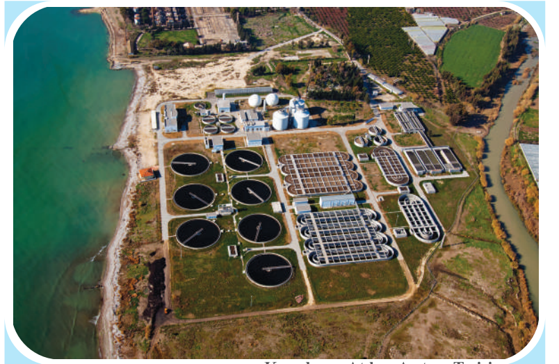
Karaduvar Atıksu Arıtma Tesisi
