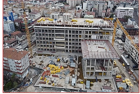
Belediye Ana Hizmet Binası
