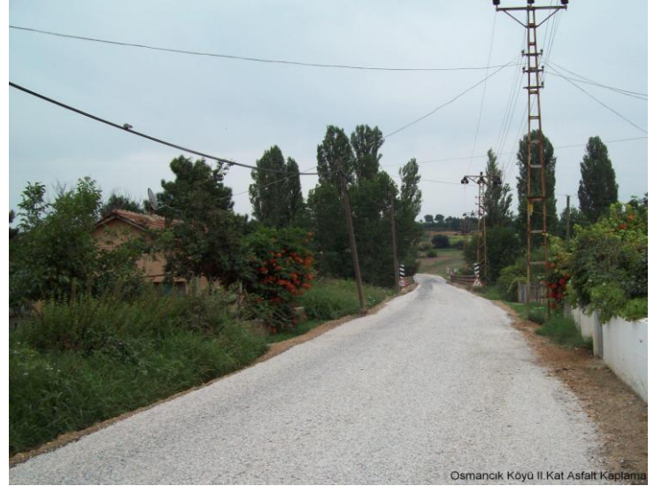
Osmancık Köyü II.Kat Asfalt Kaplama
