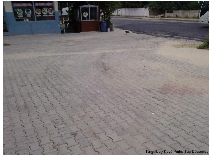
Turgutbey Köyü Parke Taş Döşemesi
