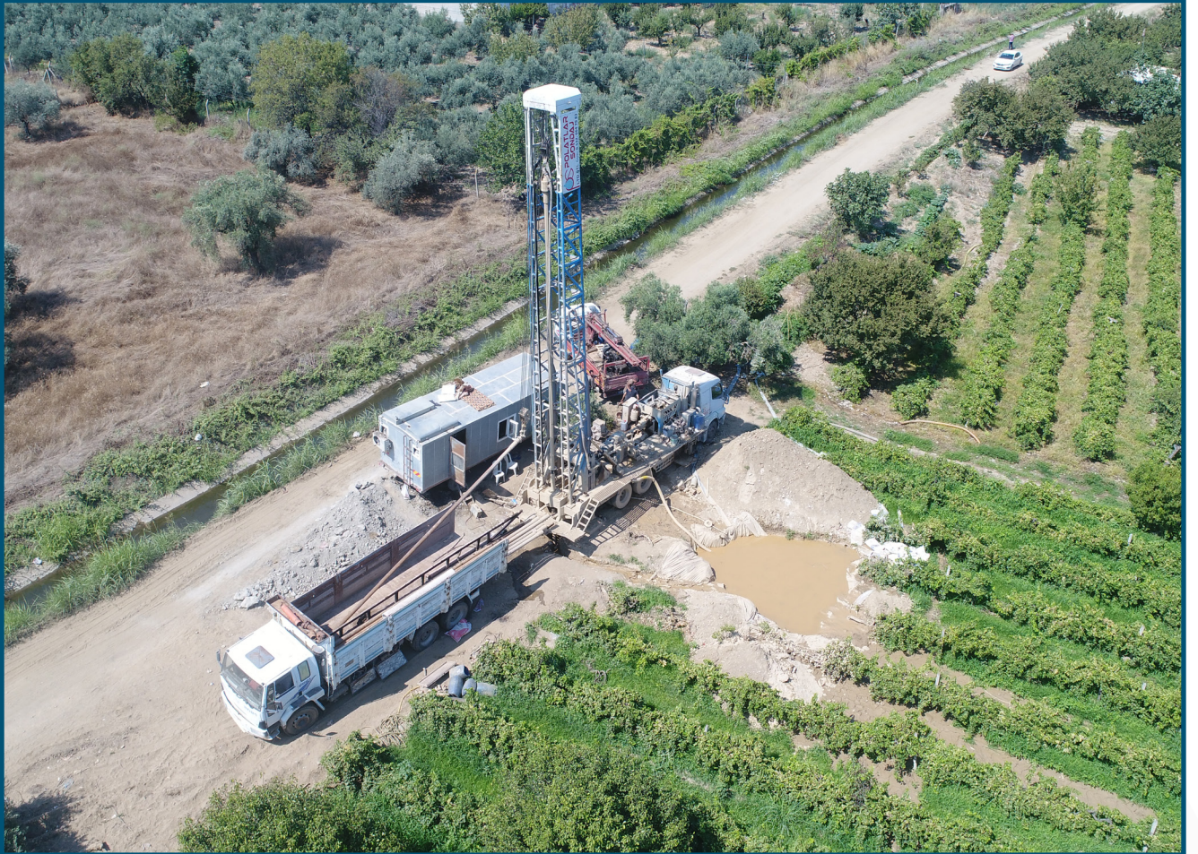
Turgutlu Avşar Mahallesi İçme Suyu Sondajı
