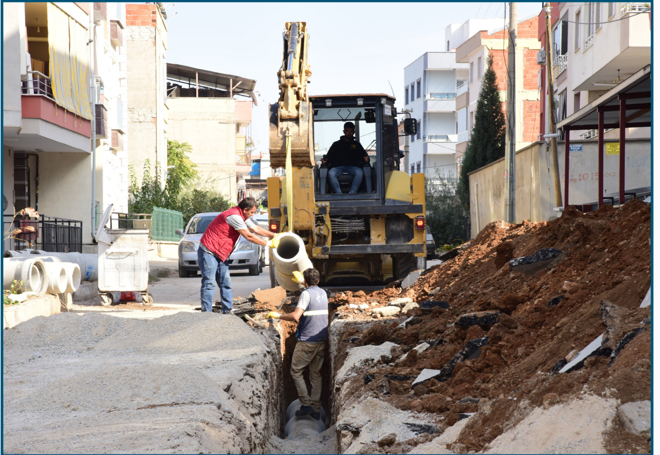
Turgutlu Selviliçe Mahallesi Yağmur Suyu Hattı
