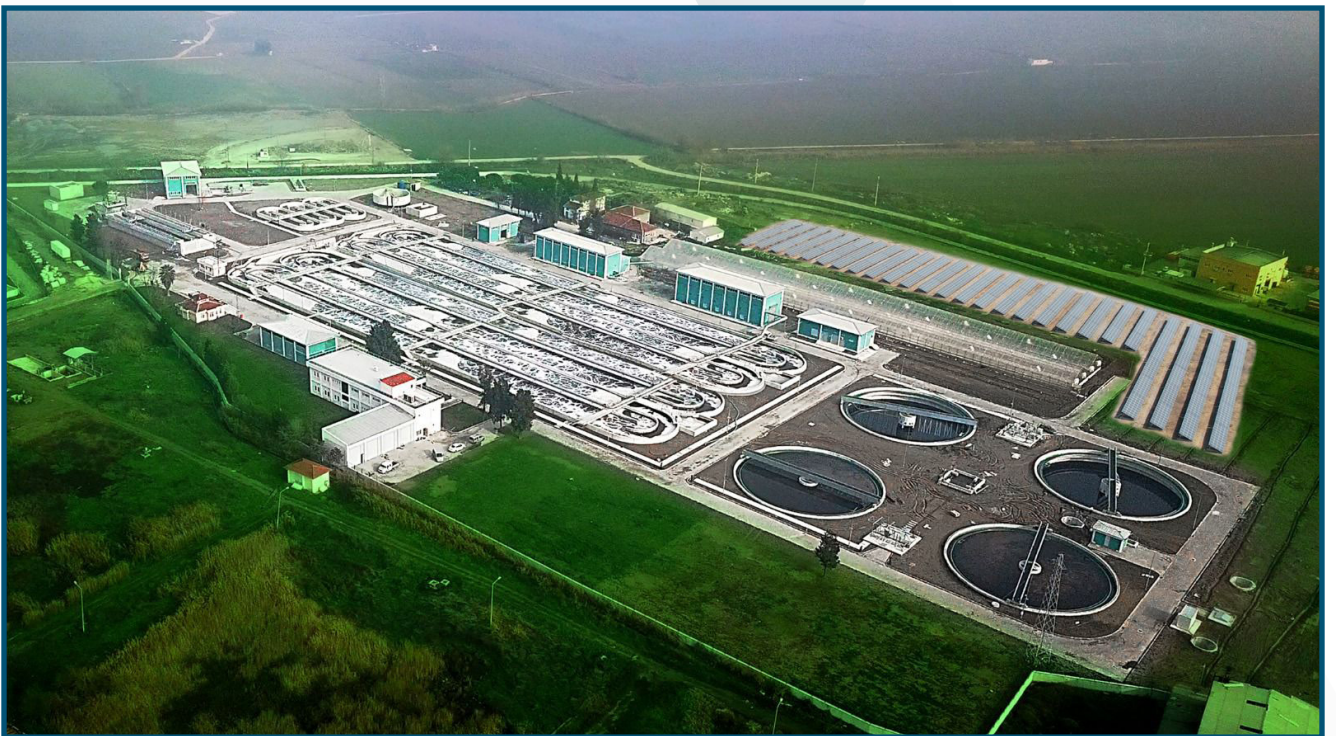
Manisa Merkez Atıksu Arıtma Tesisi ve Güneş Enerji Santrali
