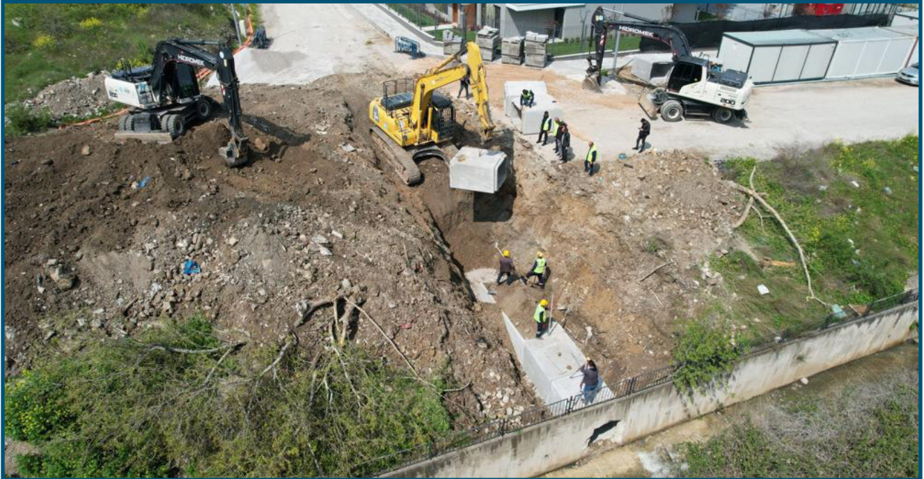
Yunusemre Uncubozköy Mahallesi Menfez İmalatı
