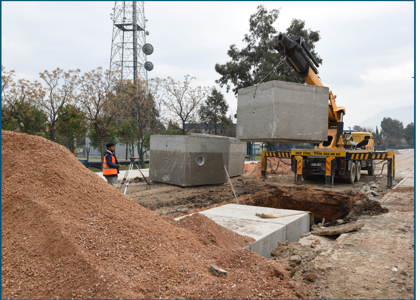
Yunusemre Kayapınar Mahallesi Yağmur Suyu Hattı
