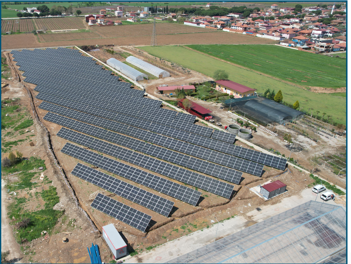
Alaşehir Atıksu Arıtma Tesisi ve Güneş Enerji Santrali
