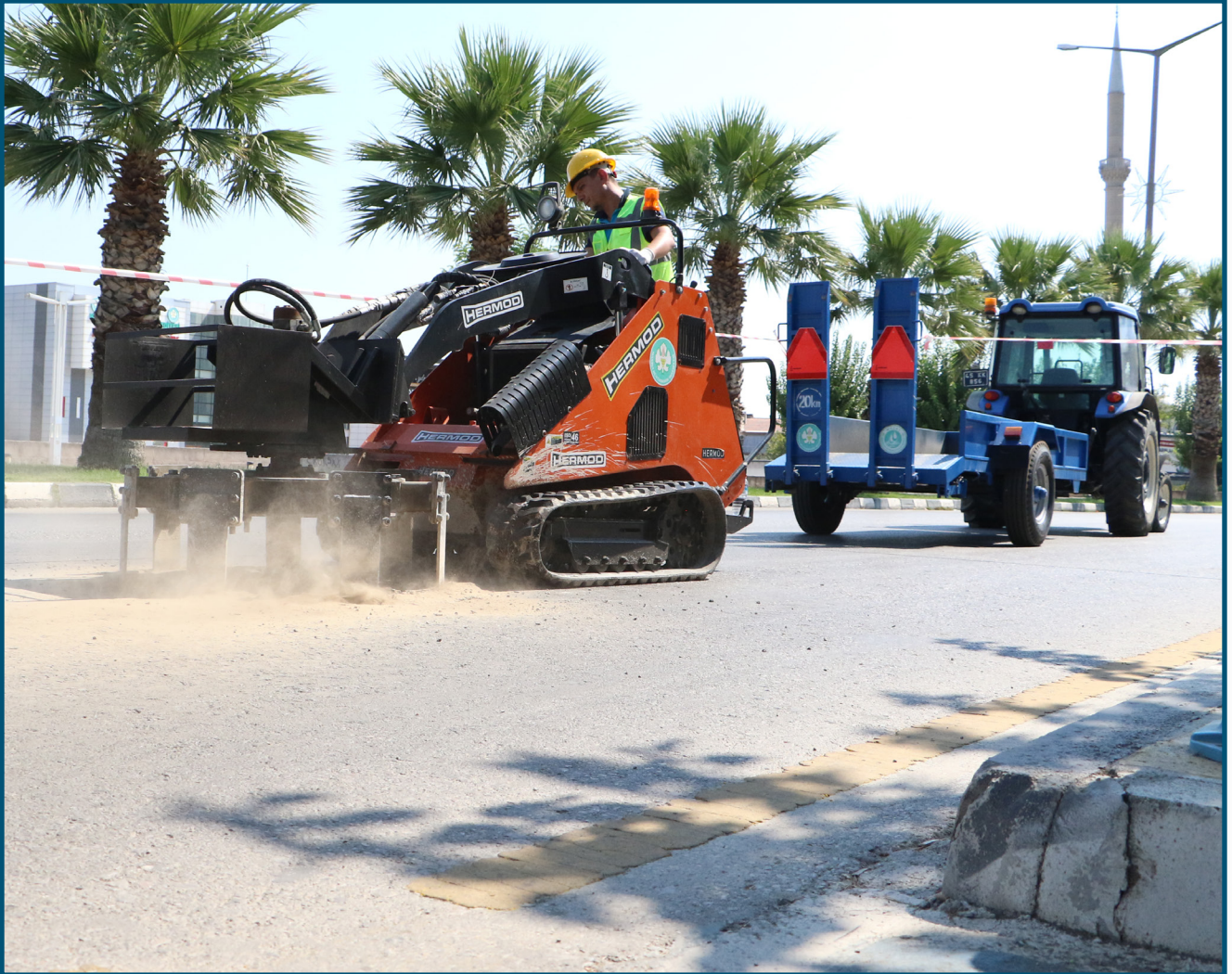
Yunusemre Laleli Mahallesi Punch Makinesi ile Muayene Bacası Yükseltme
