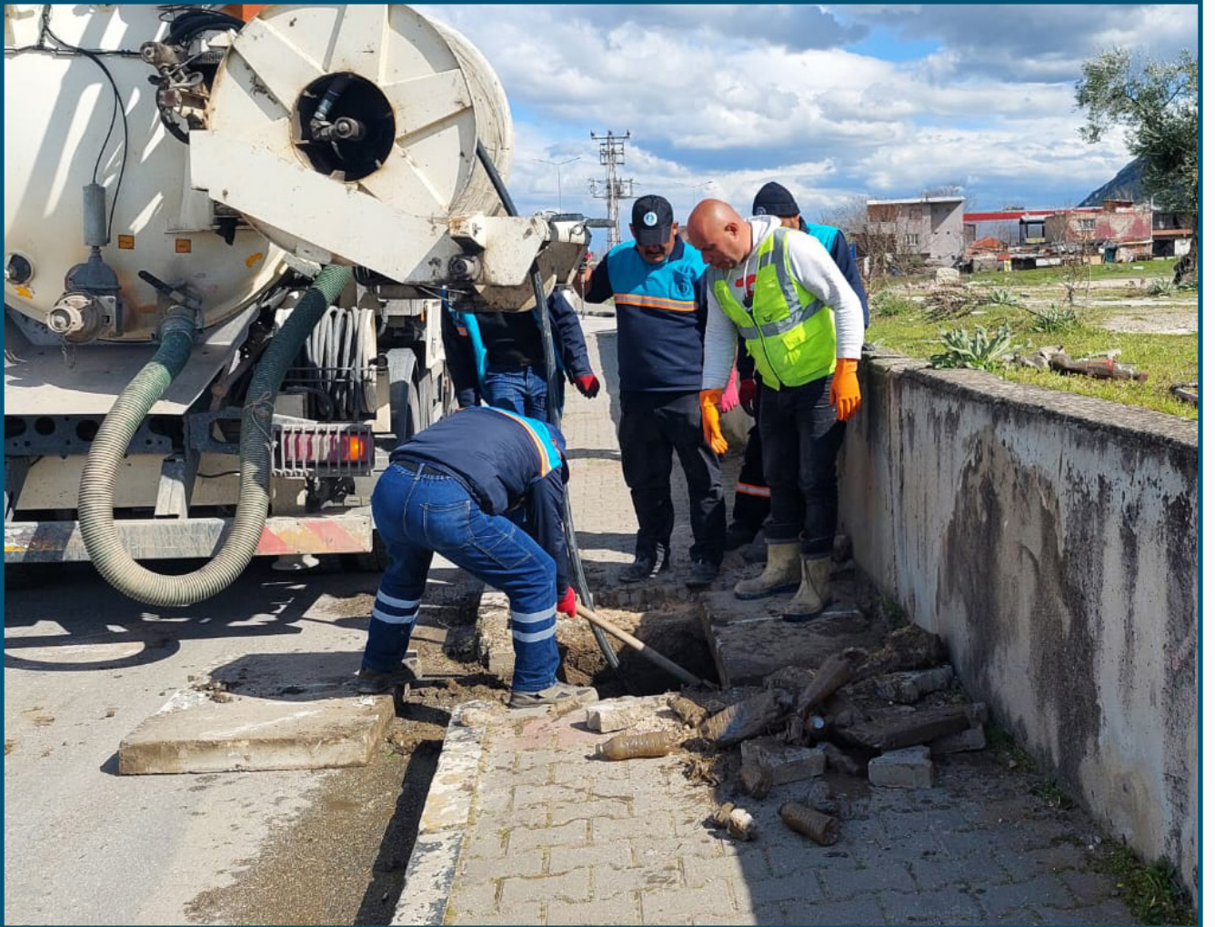
Şehzadeler Turgut Özal Mahallesi Kanalizasyon Hattı Temizliği
