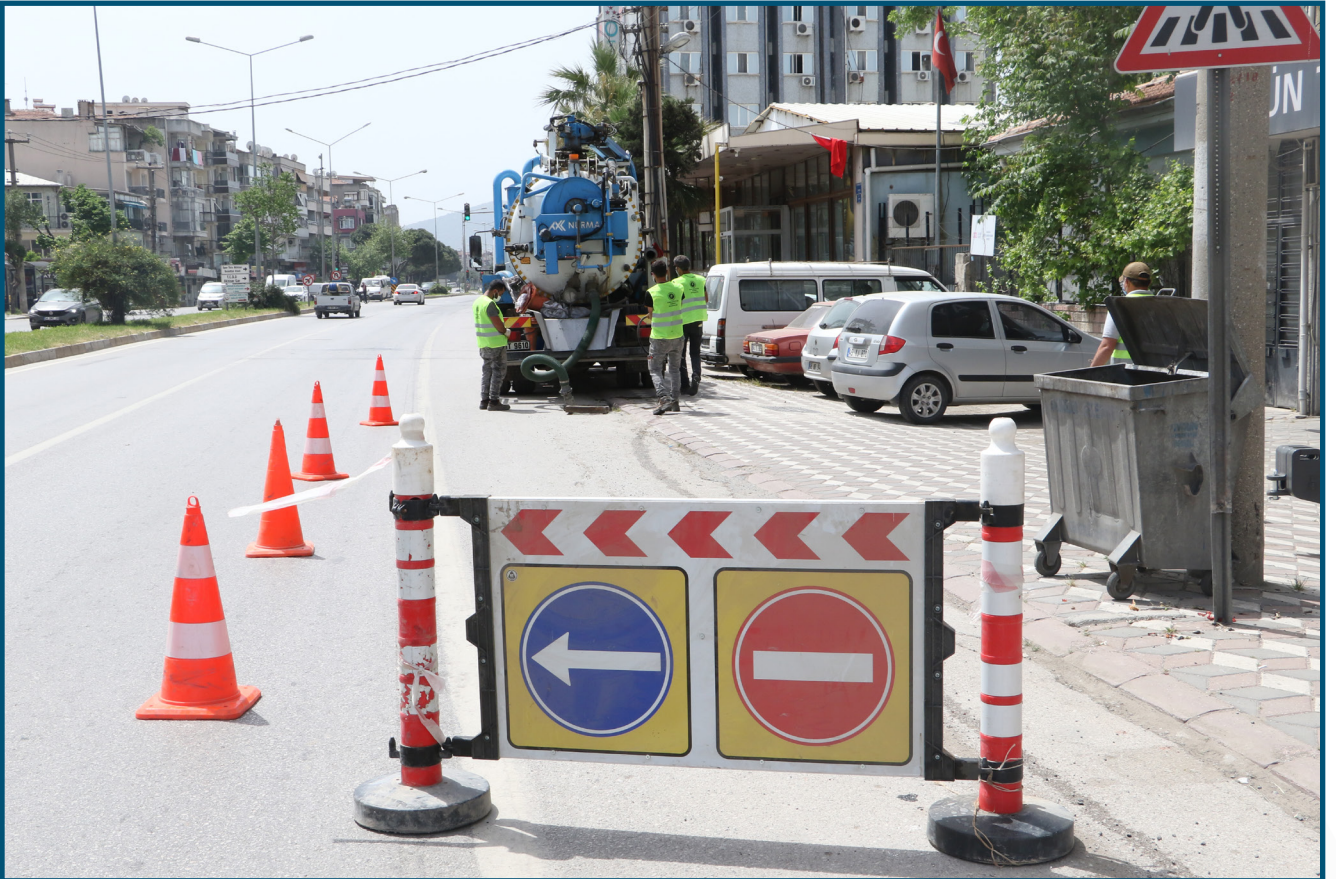
Akhisar Merkez Kanalizasyon Hattı Temizliği
