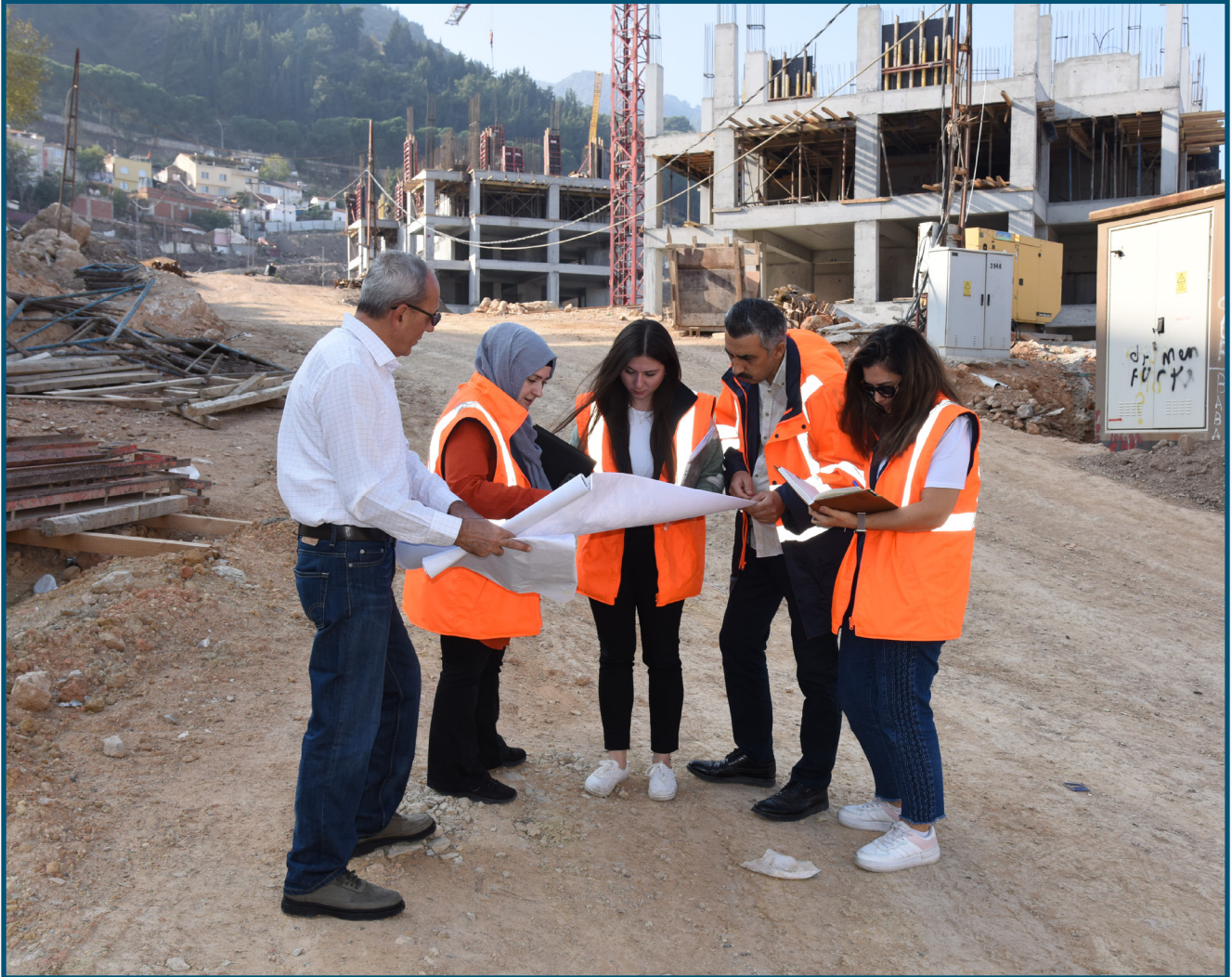
Şehzadeler Yeni TOKİ Konutları Altyapı Projeleri
