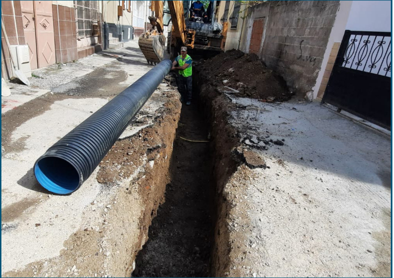
Akhisar Şeyhisa Mahallesi
