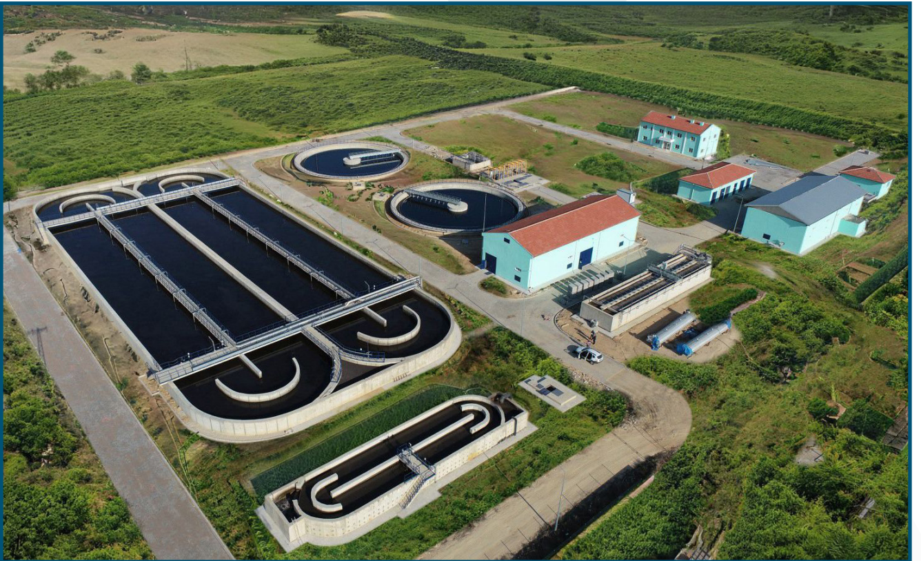
Alaşehir Atıksu Arıtma Tesisi ve Güneş Enerji Santrali
