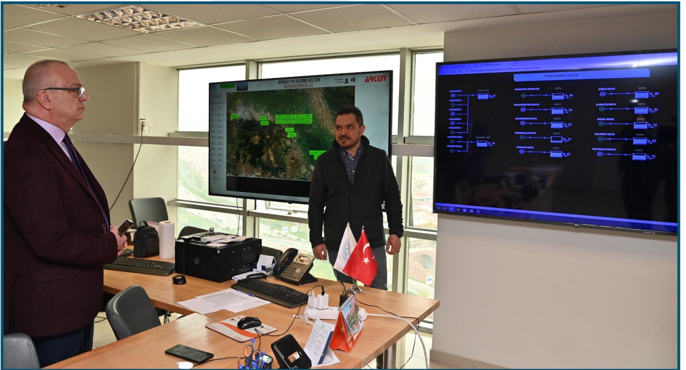
MASKİ SCADA Komuta Merkezi
