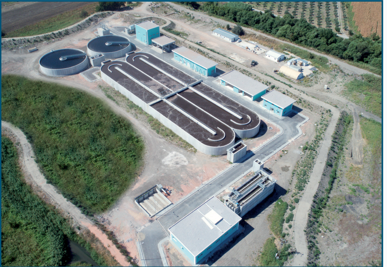
Soma Atıksu Arıtma Tesis
