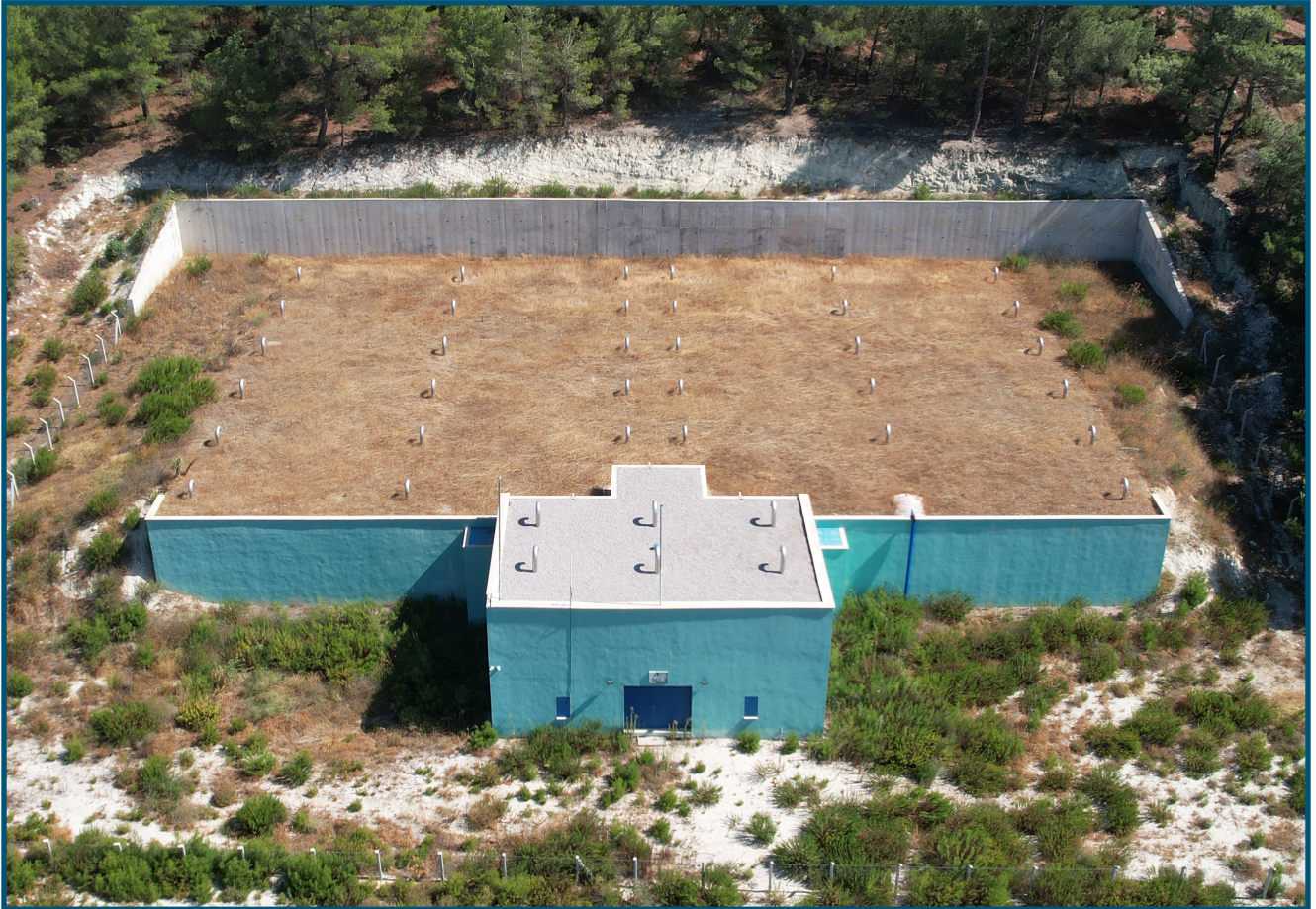
Soma Merkez İçme Suyu Deposu
