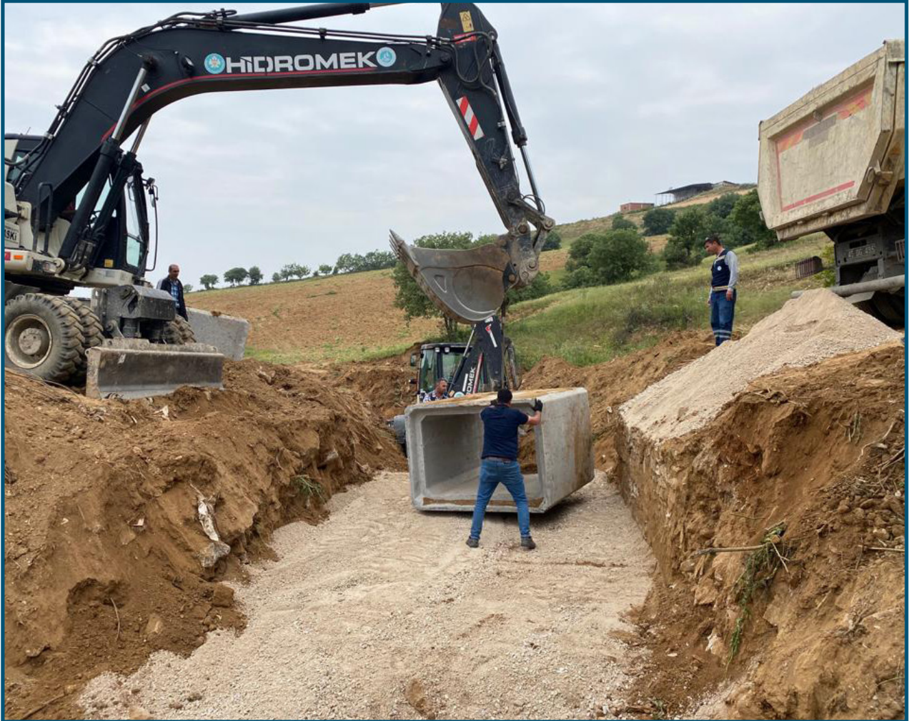
Salihli Mersinli Mahallesi Menfez İmalatı
