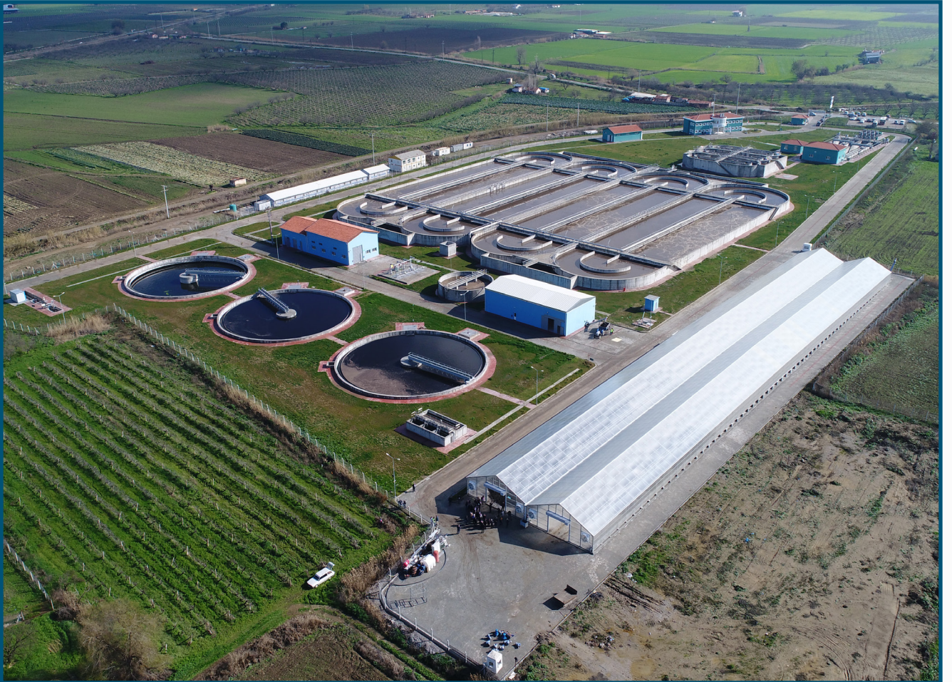
Turgutlu Atıksu Arıtma Tesisi
