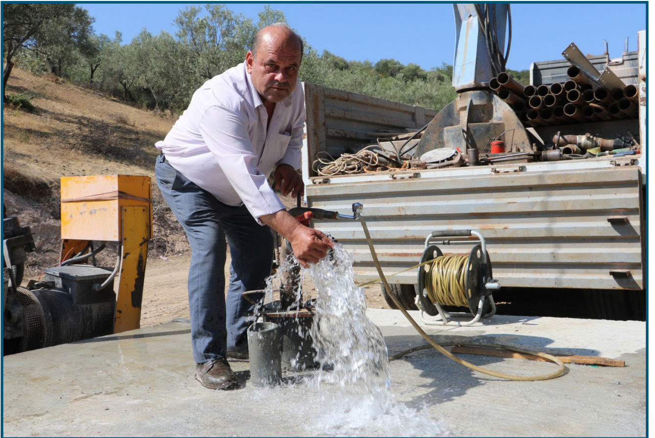
Saruhanlı Alibeyli Mahallesi Sondaj
