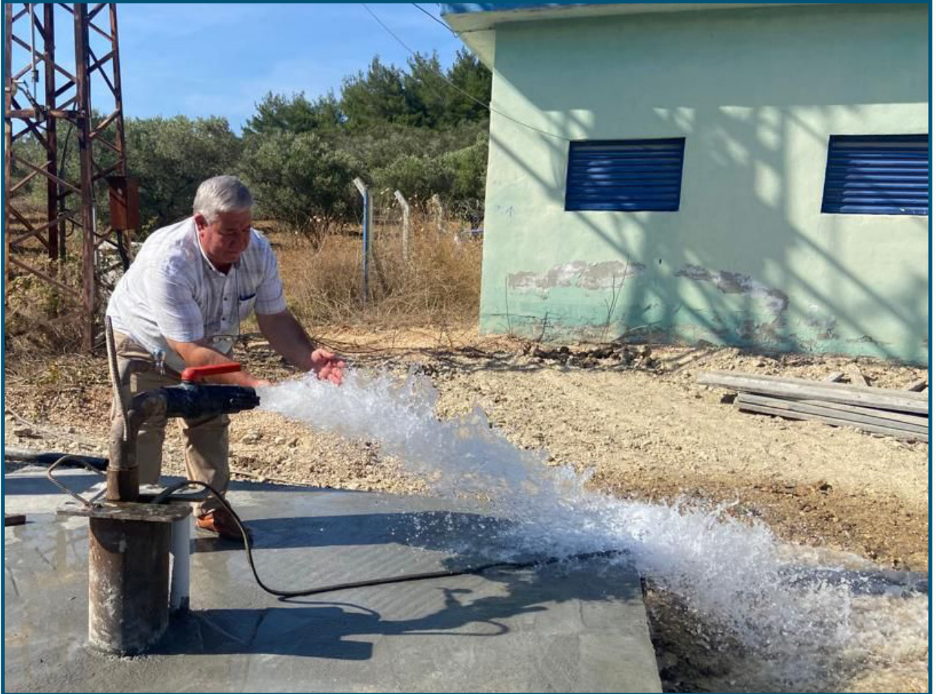
Kırkağaç Karakurt Mahallesi Sondaj
