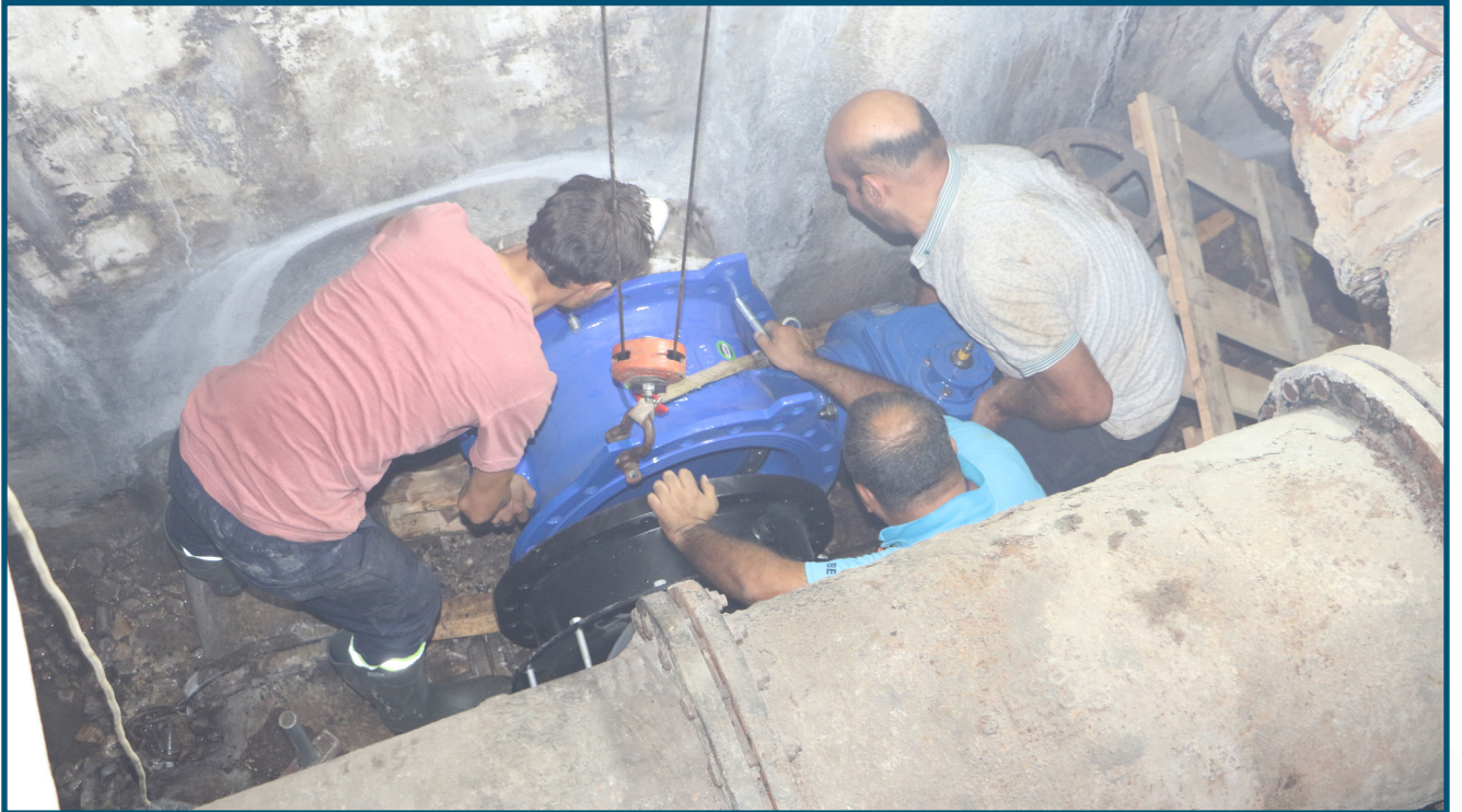
Şehzadeler Taşocağı İçme Suyu Deposu Vana Değişimi
