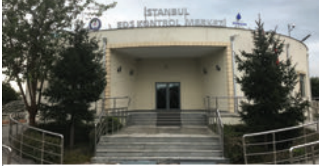
Elektronik Denetleme Sistemi Kontrol Merkezi, Küçükçekmece
