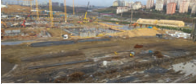
Şehir Hastanesi İstasyonu, Başakşehir - Kayaşehir Metro Hattı
