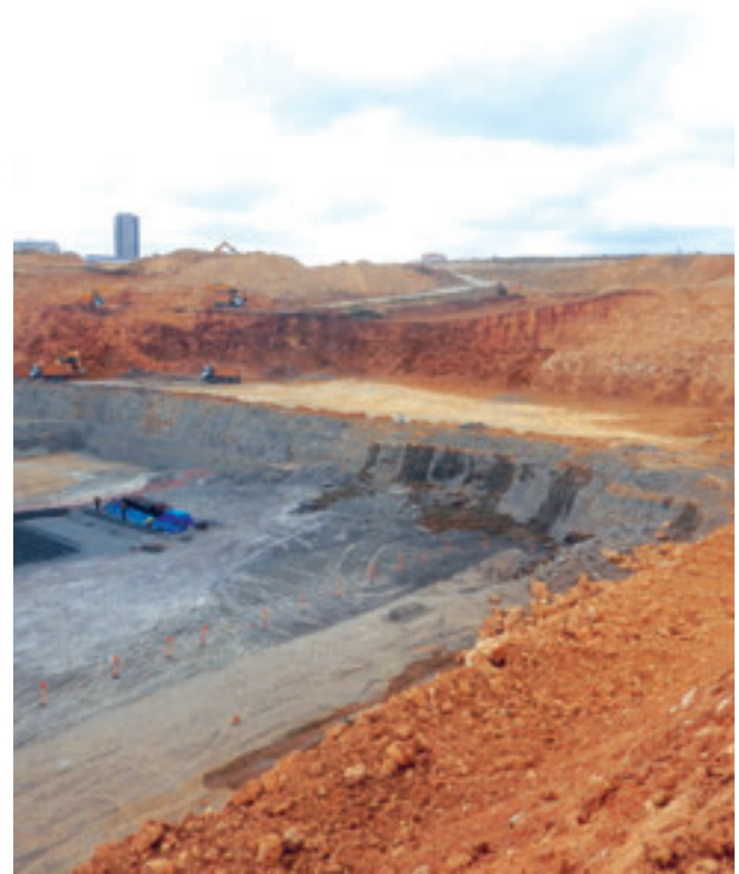
Şehir Hastanesi Temel Kazısı - Koyunbaba Formasyonu ve üzerine gelen Soğucak Kireçtaşı Formasyonu, Başakşehir
