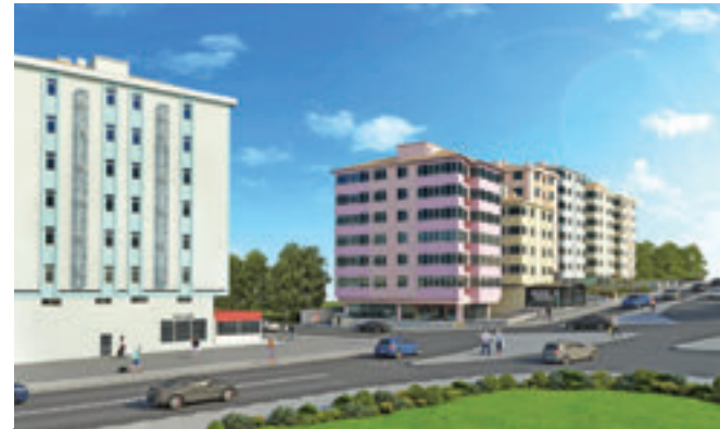
D-100 Karayolu Güzargahı İsfalt Köprülü Kavşağı-İcadiye Yolu Ayrımı Arası Cephe Rehabilitasyonu
