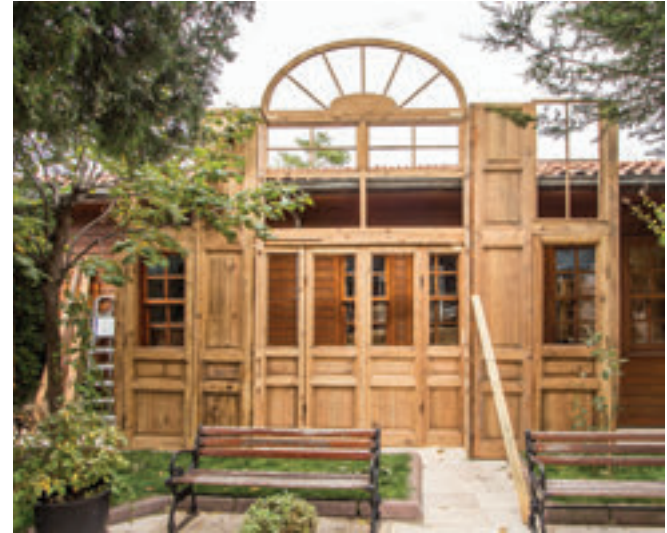
Bulgar Kilisesi Ahşap Kapı Onarımı, Fatih
