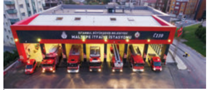
Maltepe İtfaiye İstasyonu, Maltepe
