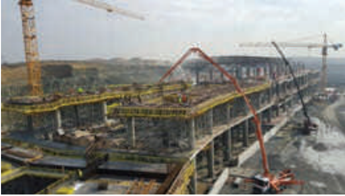
Bölge: Pb1 Genel Görünüm Terminal İskele Blokları
