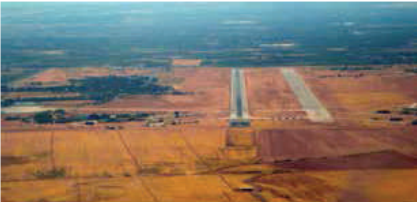
Malatya Havalimanı PAT Sahaları Onarımı ve Çevre Tel Örgüsü Yapılması
