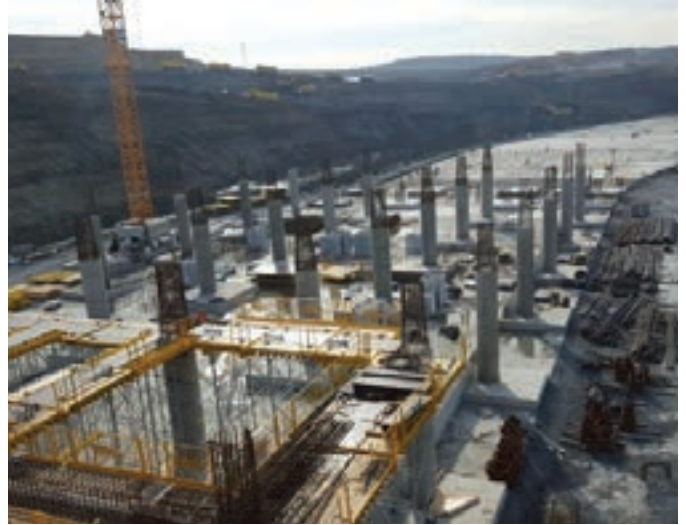
Bölge: Pb2 Genel Görünüm Terminal İskele Blokları
