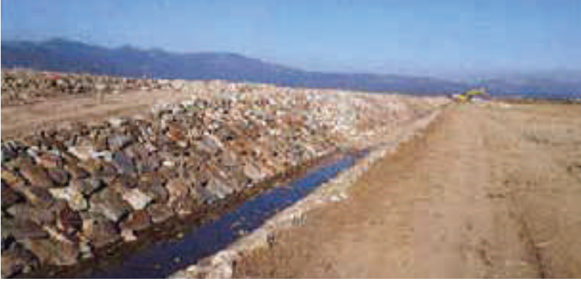
Balıkesir Koca Seyit Havalimanı Drenaj Kanallarının Rehabilitasyonu ile Resa ve Şerit Sahalarının Tanzimi
