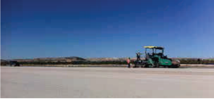
Gaziantep Havalimanı Pist Rehabilitasyonu İkmal İnşaatı
