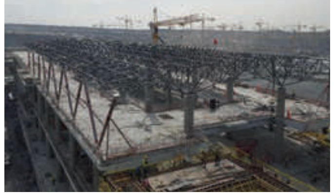
Bölge: Pb1-3 Uzay Çatı Terminal İskele Blokları
