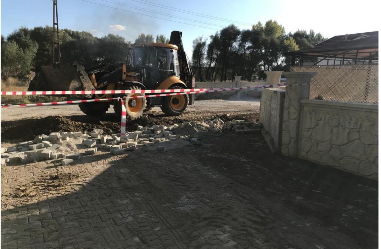
8 Bahçelievler mh. Hürriyet meydanı Q200 Kanalizasyon Hattı 72
