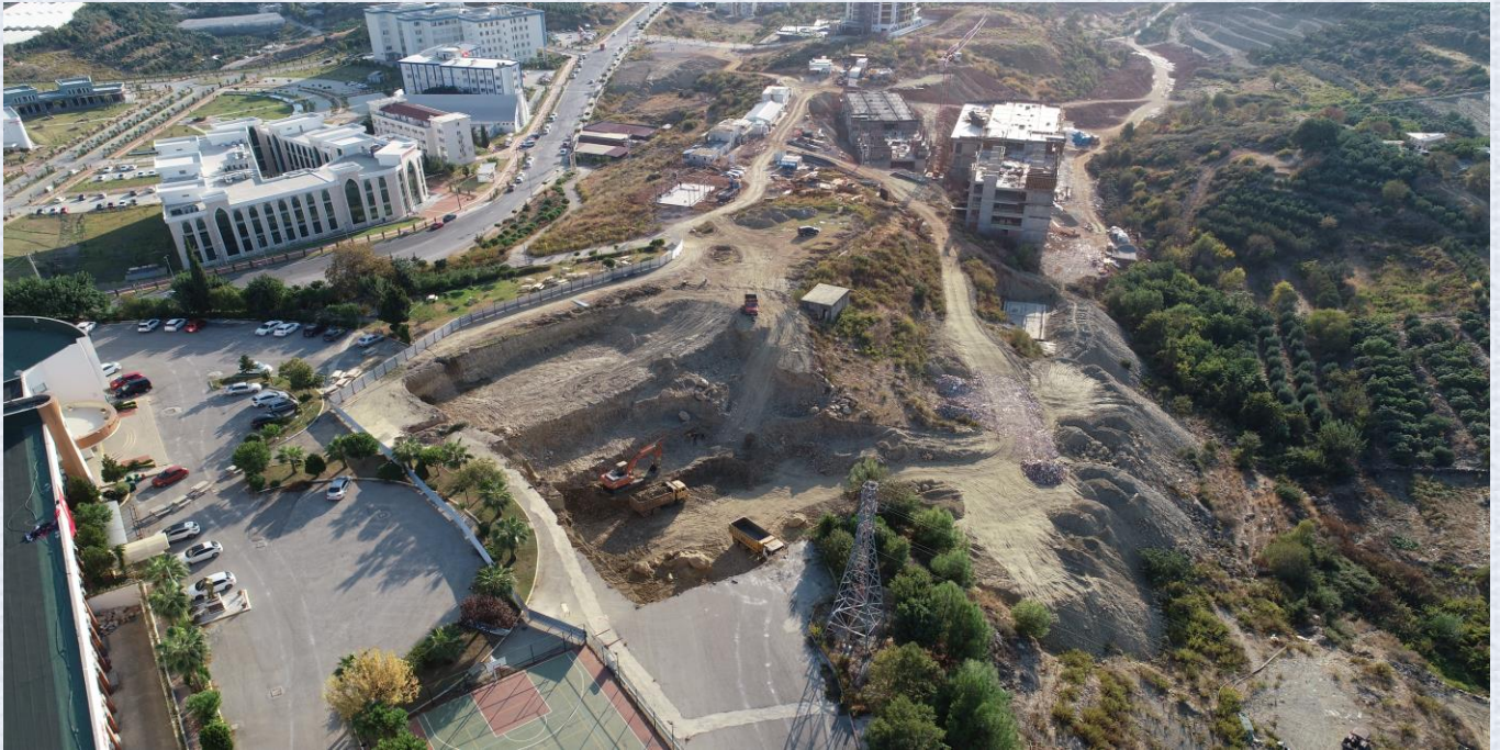
Yeni Merkezi Derslik İnşaatı
