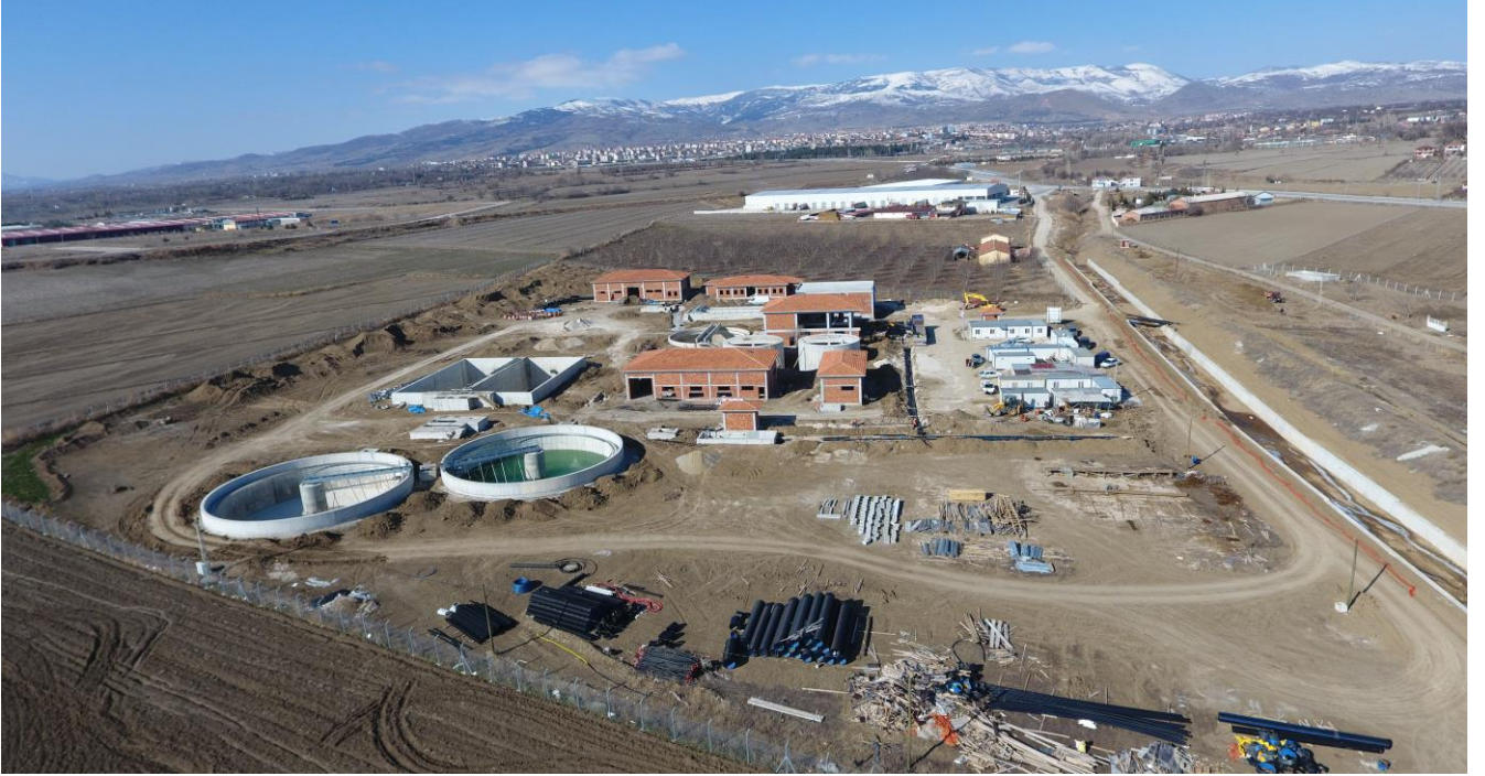
( Atıksu Arıtma Tesisi Eski Hali )
