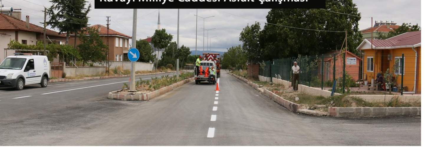
Kuvayi Milliye Caddesi Asfalt Çalışması
