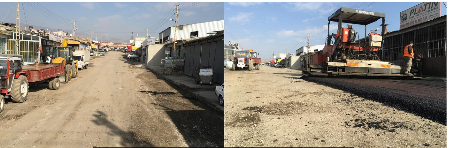
100. Yıl Sanayi Sitesi 3. Blok Asfalt Çalışması
