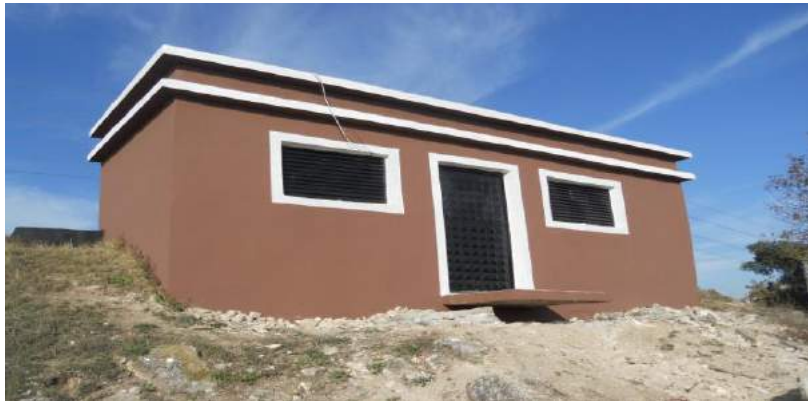
Pazarlı İçme Suyu Gömme Depo Bakım Onarımı
