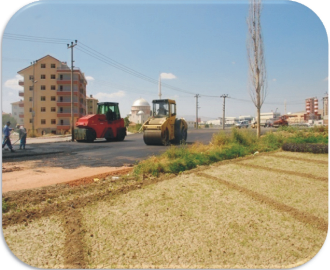
2009 yılında yapılan yol ve asfalt çalışmalarından görüntüler
