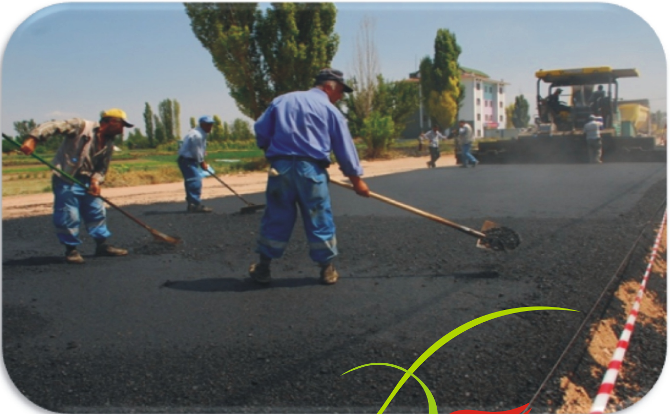
2009 yılında yapılan yol ve asfalt çalışmalarından görüntüler
