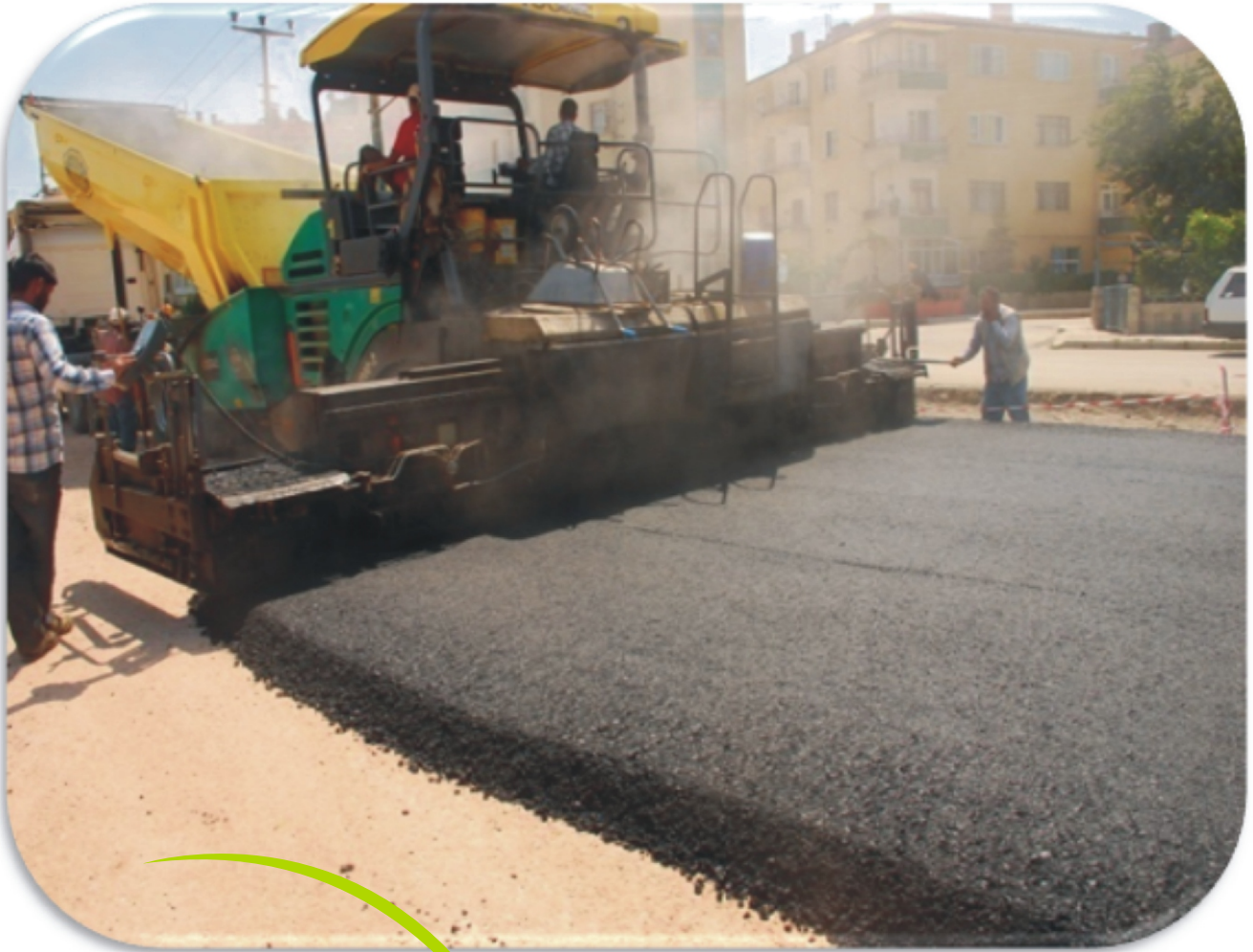
2009 yılında yapılan yol ve asfalt çalışmalarından görüntüler
