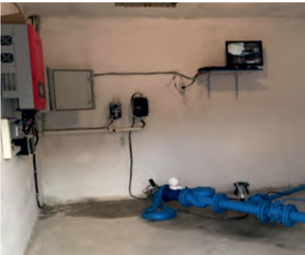
Terfi binası ENH pompa çalışması
