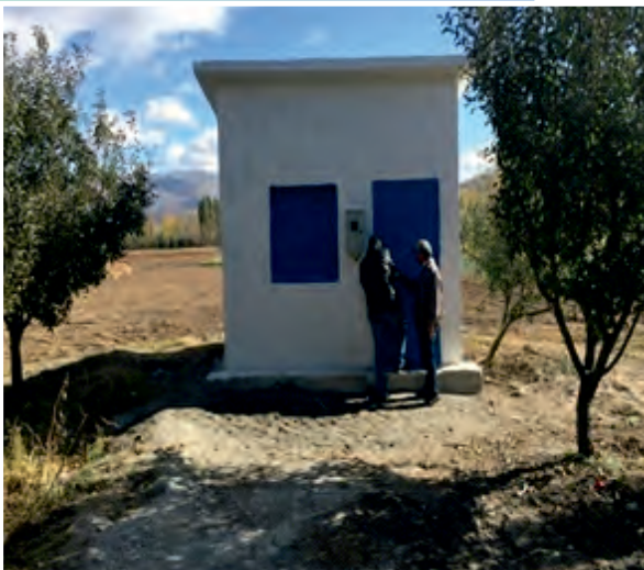
Döllük köyü terfi binası
