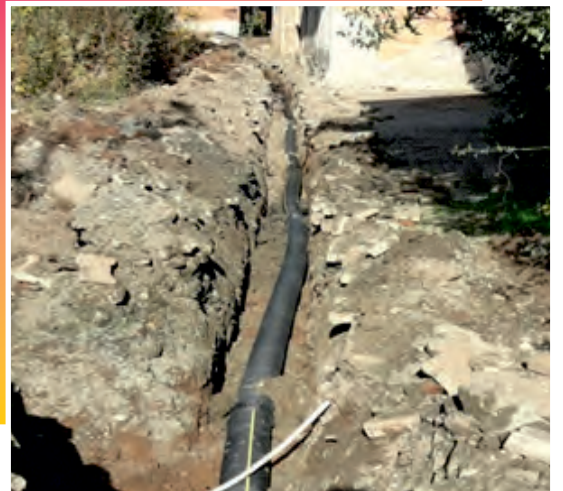
Kanalizasyon hat çalışması
