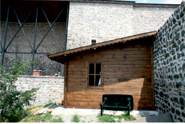
Niksar Kalesi Mutfak Projesi denetimi
