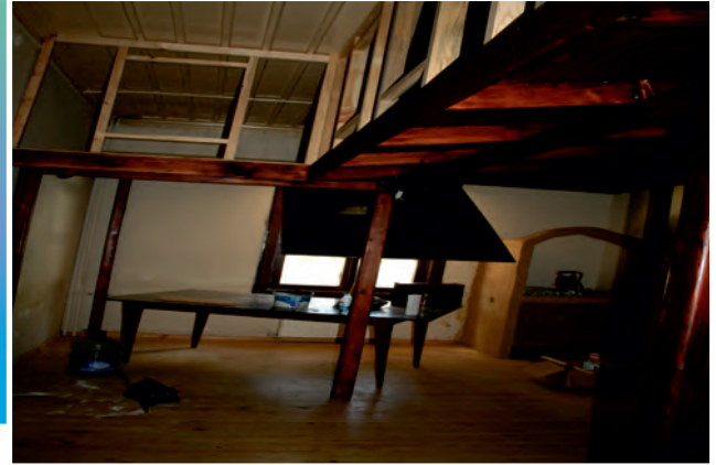
Erbaa Eski Hükümet Konağı Restorasyon denetimi
