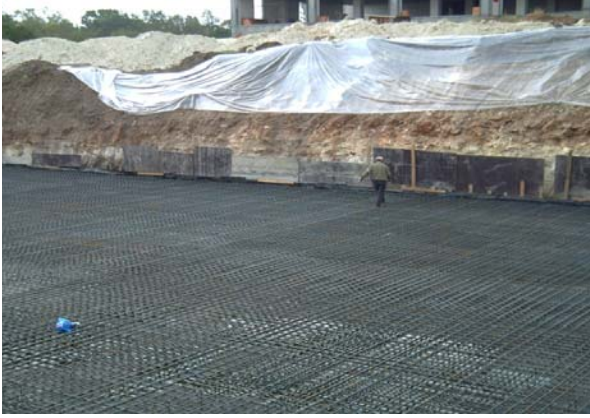
Su deposu inşaatı
