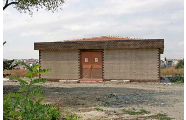
Büyük Trafo Binası
