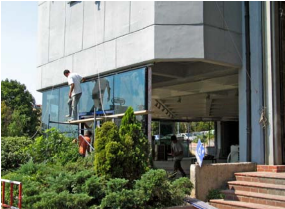
2007 yılı oditoryum binası tadilatı
