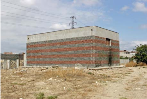
Küçük Trafo binası
