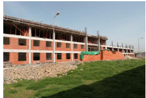
Ek Bina İnşaatının 2007 yılı görüntüsü
