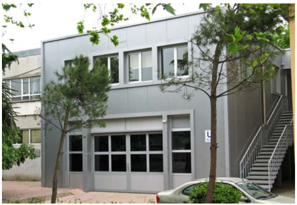
2007 yılı Makine Fakültesi Laboratuvar binası
