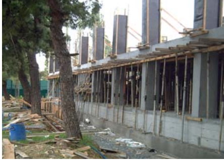
Binanın 2006 yılı inşaatı
