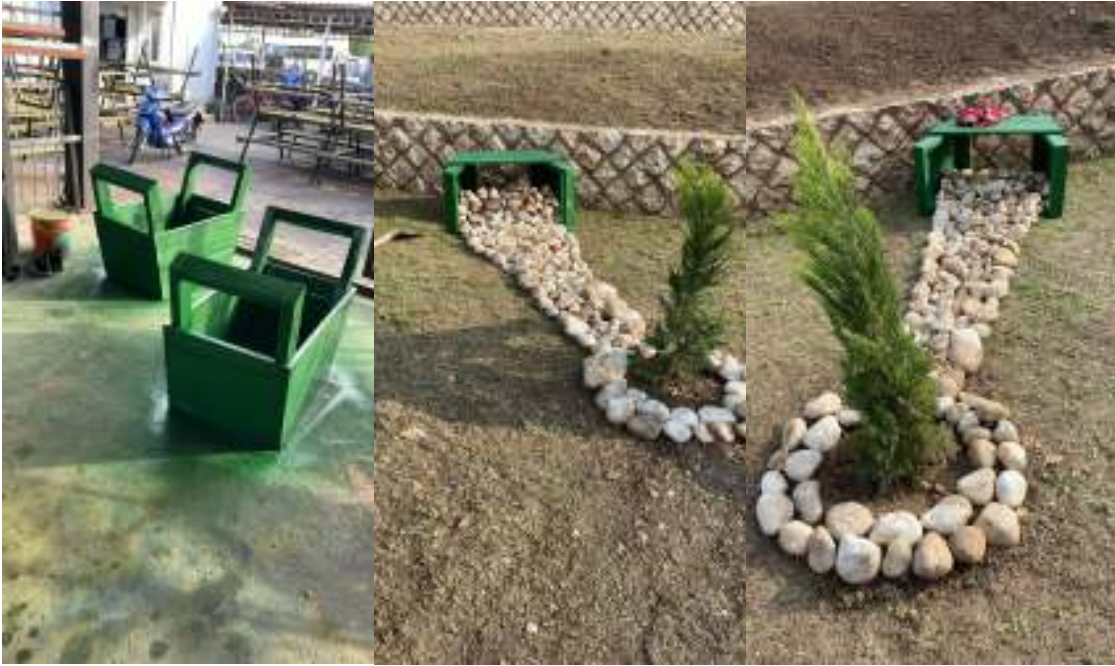
16. Adliye Sarayının önüne 2 adet Bank montajı yapıldı.
