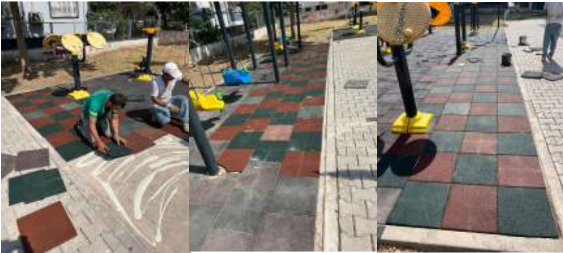
23. Ulus Mahallesinde bulunan Mehmet Can Öztürk Park' ının Oyun Grupları altındaki eksik Kauçukları tamamlandı.
