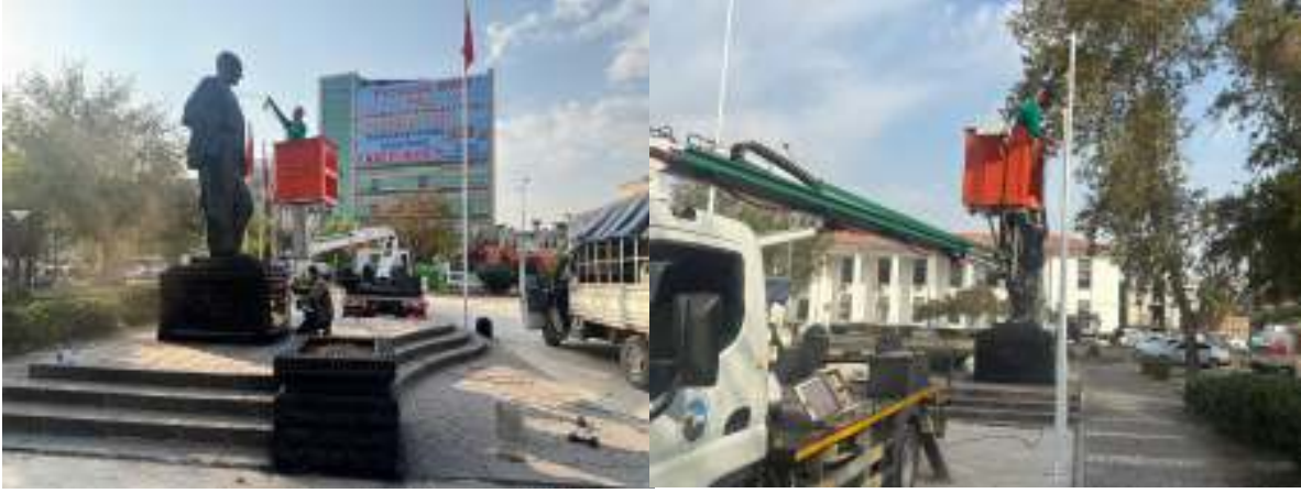
19. İstiklal Mahallesiindeki parkta bulunan Çocuk oyun grupları, zıp-zıplar söküldü. Alana malzeme dökülerek, kepçe ile düzlendi.
