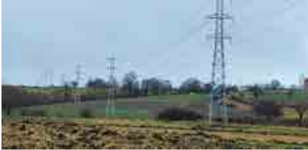
Ladik Güneş Enerji Santrali Projesine Ait Görseller
