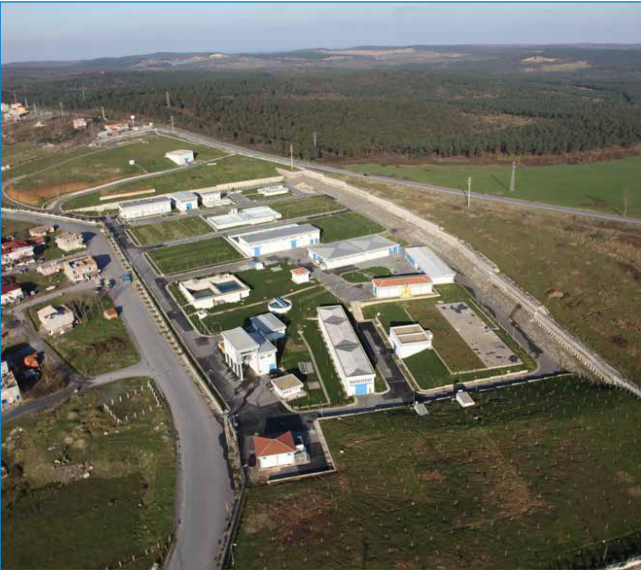
Taşoluk İçme Suyu Arıtma Tesisi
