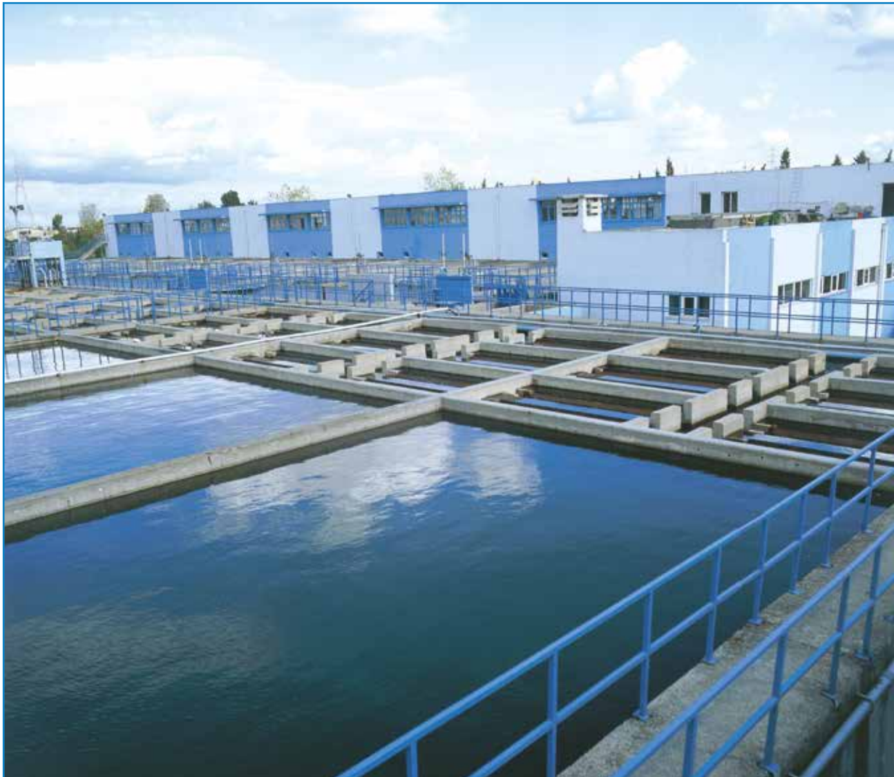
Kağıthane İçme Suyu Arıtma Tesisi
