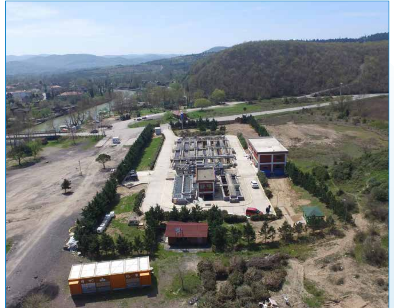
Ağva Membran Atık Su Arıtma Tesisi
