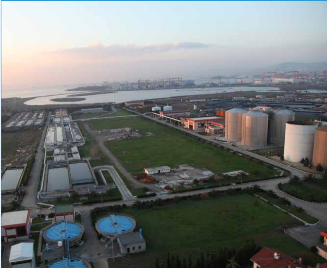
Tuzla İleri Biyolojik Atık Su Arıtma Tesisi
