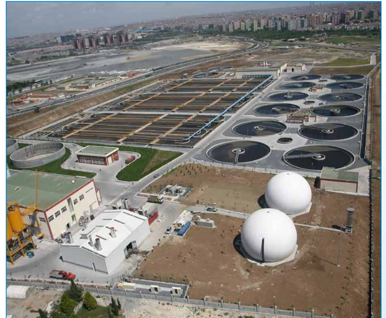
Ataköy İleri Biyolojik Atık Su Arıtma Tesisi
