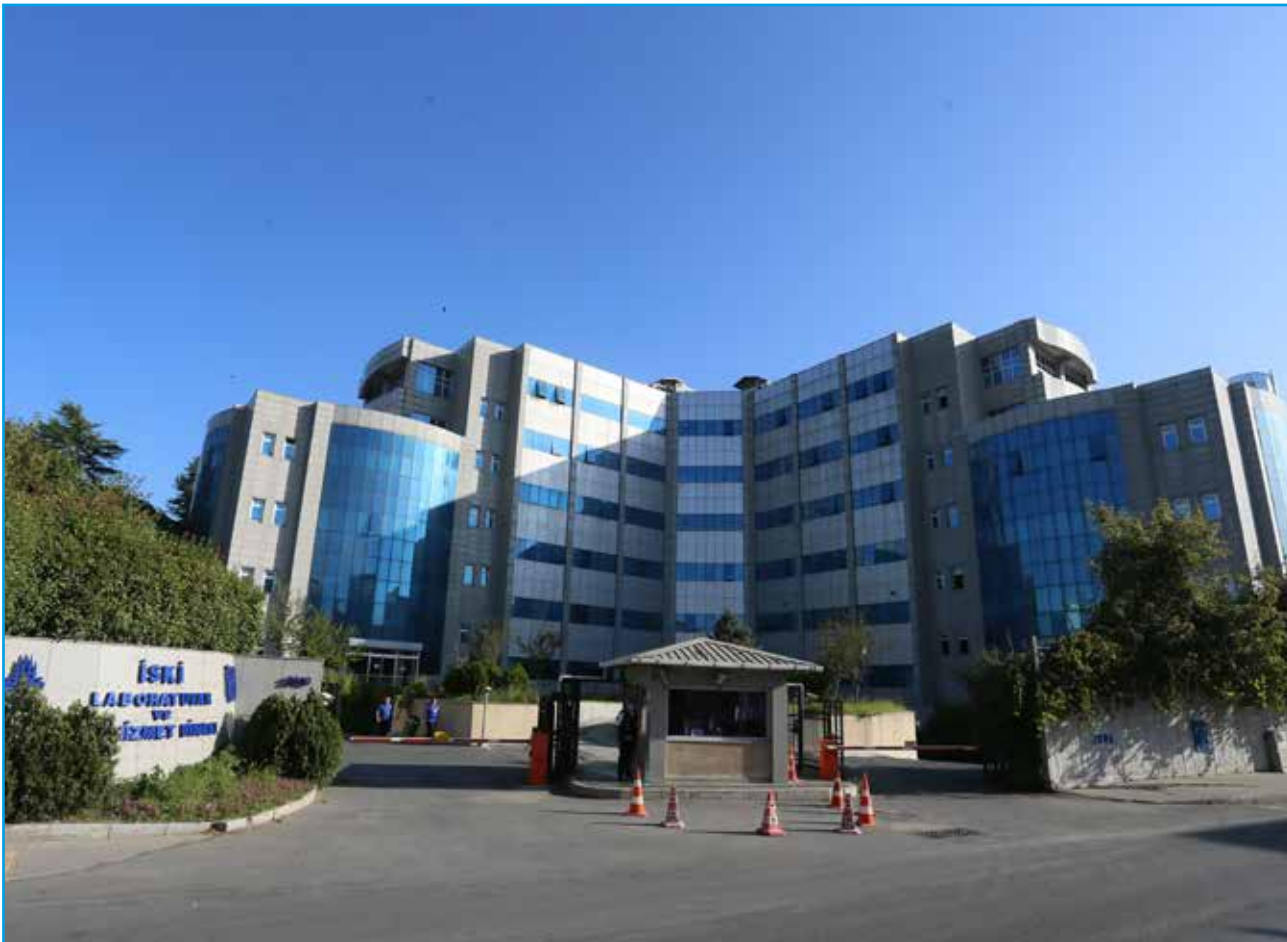
İSKİ Laboratuvar Binası
