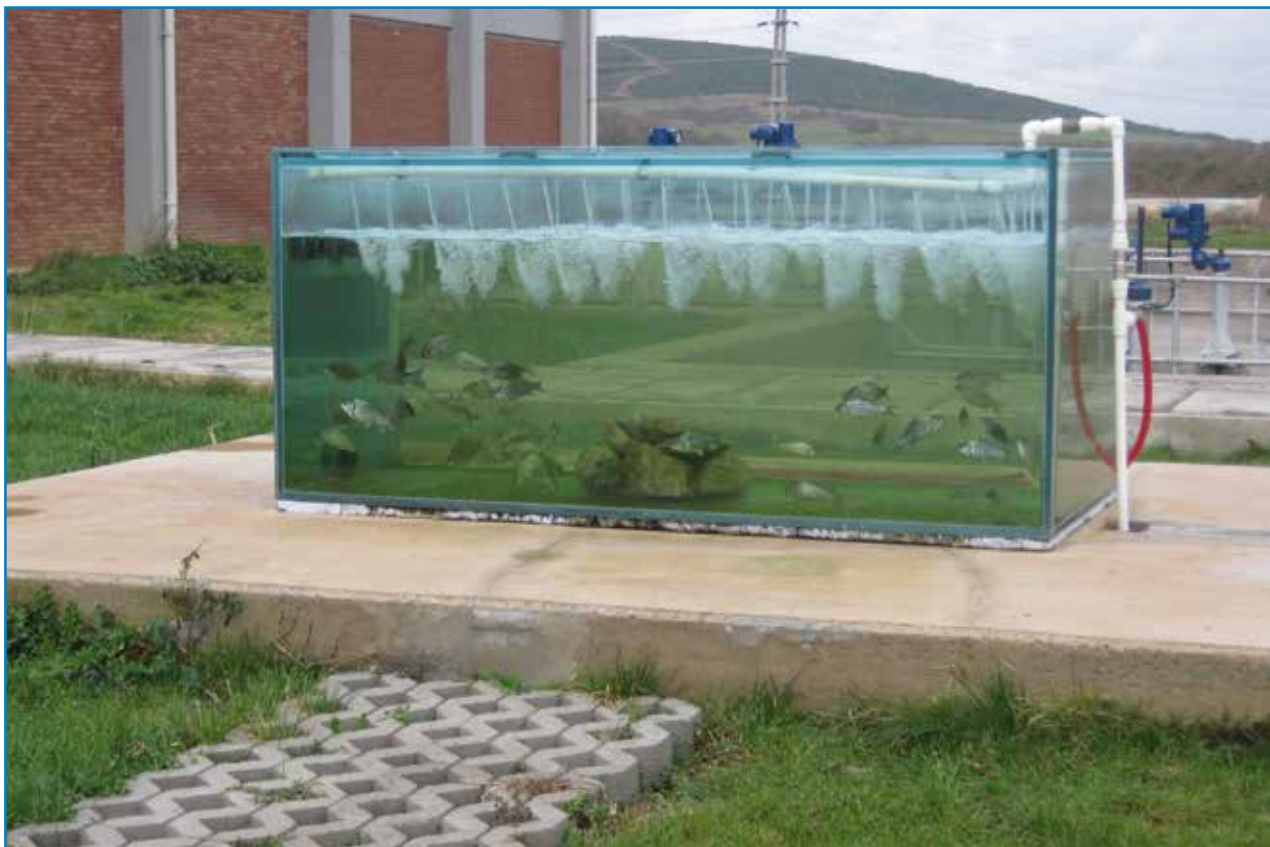
Paşaköy İleri Biyolojik Atık Su Arıtma Tesisi - Geri Dönüşüm Suyu
