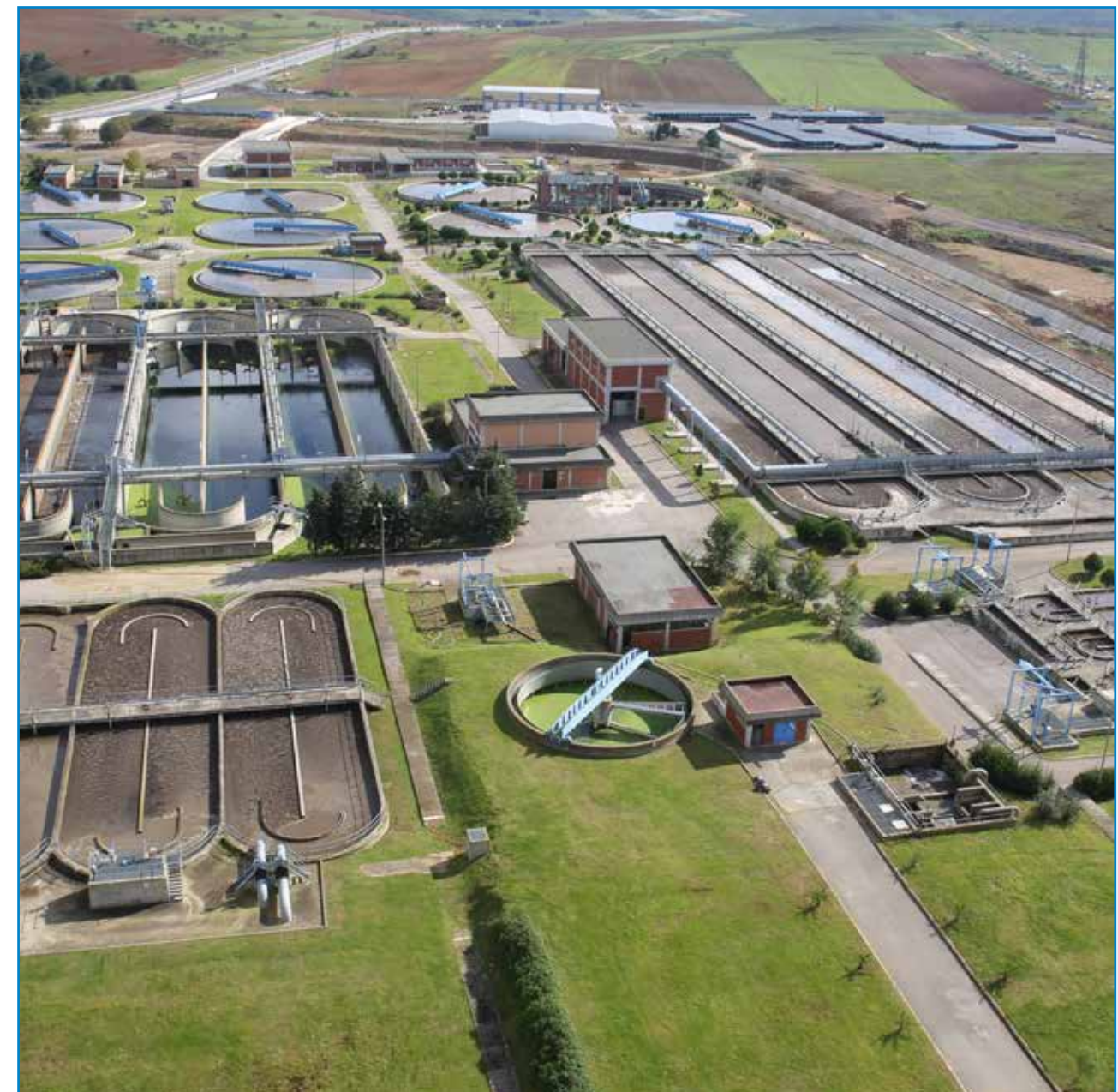
Paşaköy İleri Biyolojik Atık Su Arıtma Tesisi
