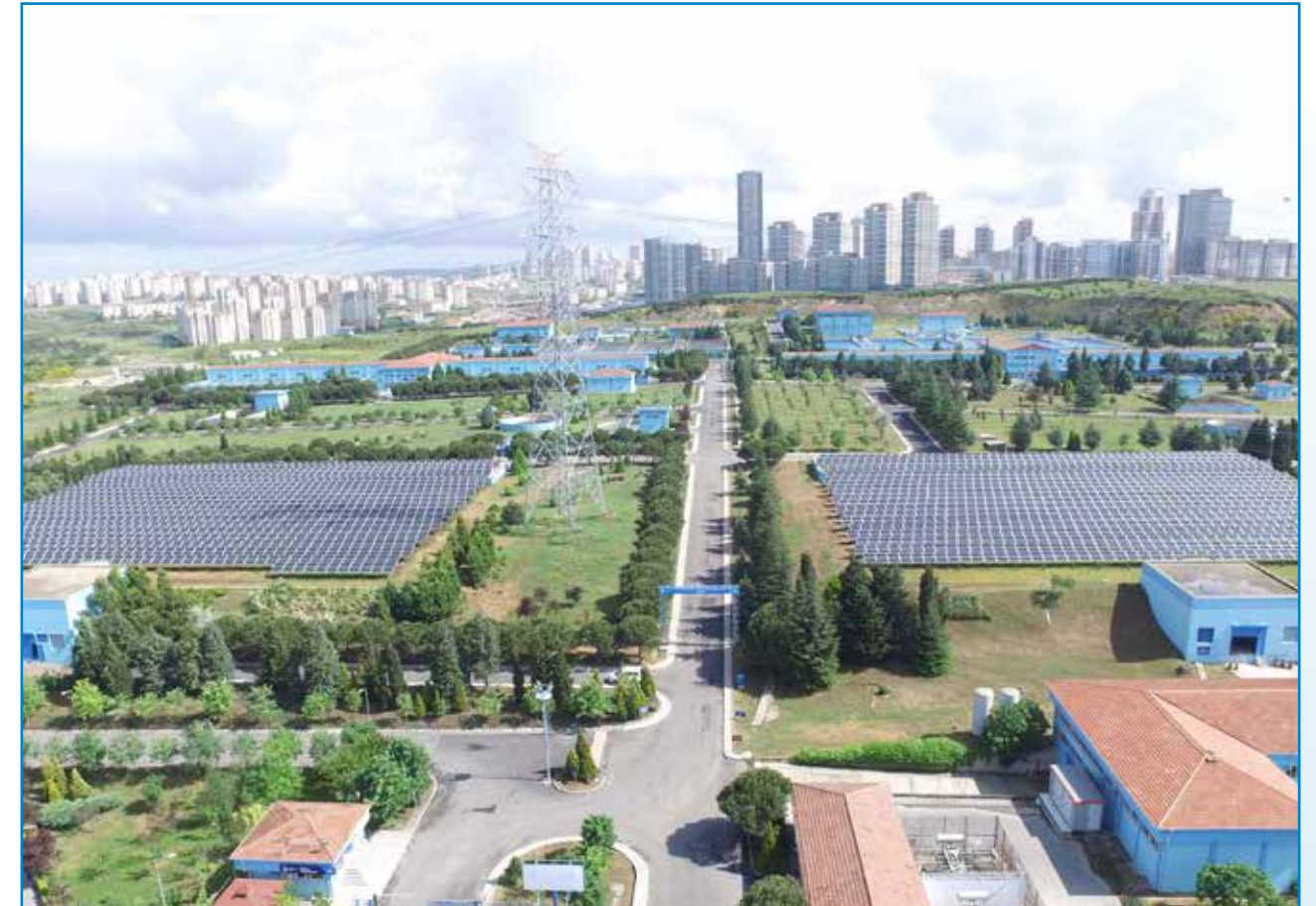
İkitelli İçme Suyu Arıtma Tesisi - Güneş Enerjisi Santrali
