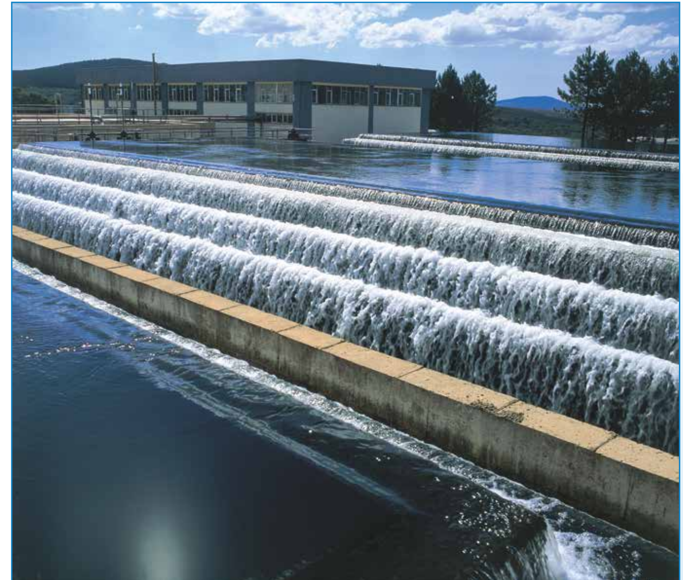
Ömerli İçme Suyu Arıtma Tesisi
