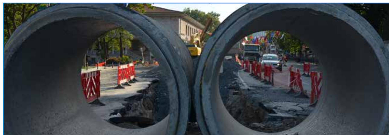
Beşiktaş Kolektör Çalışması
