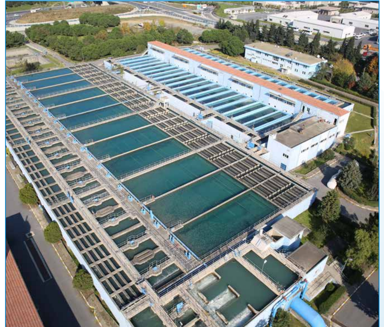
Kağıthane İçme Suyu Arıtma Tesisi
