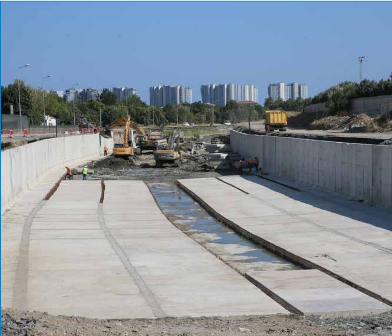
Ayamama Dere Islah İnşaatı
