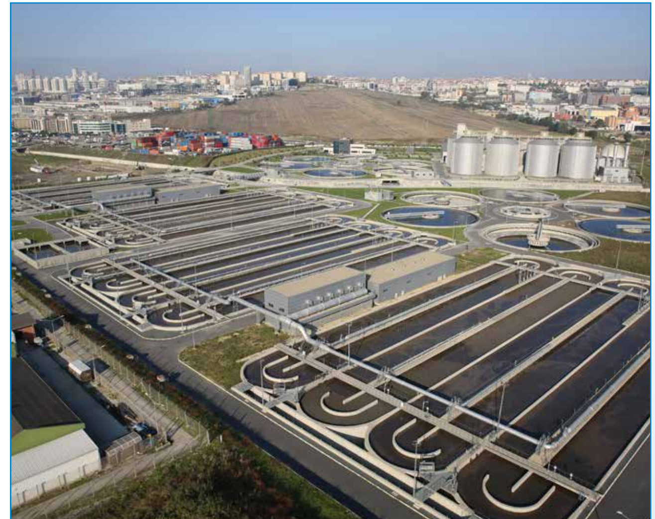
Ambarlı İleri Biyolojik Atık Su Arıtma Tesisi
