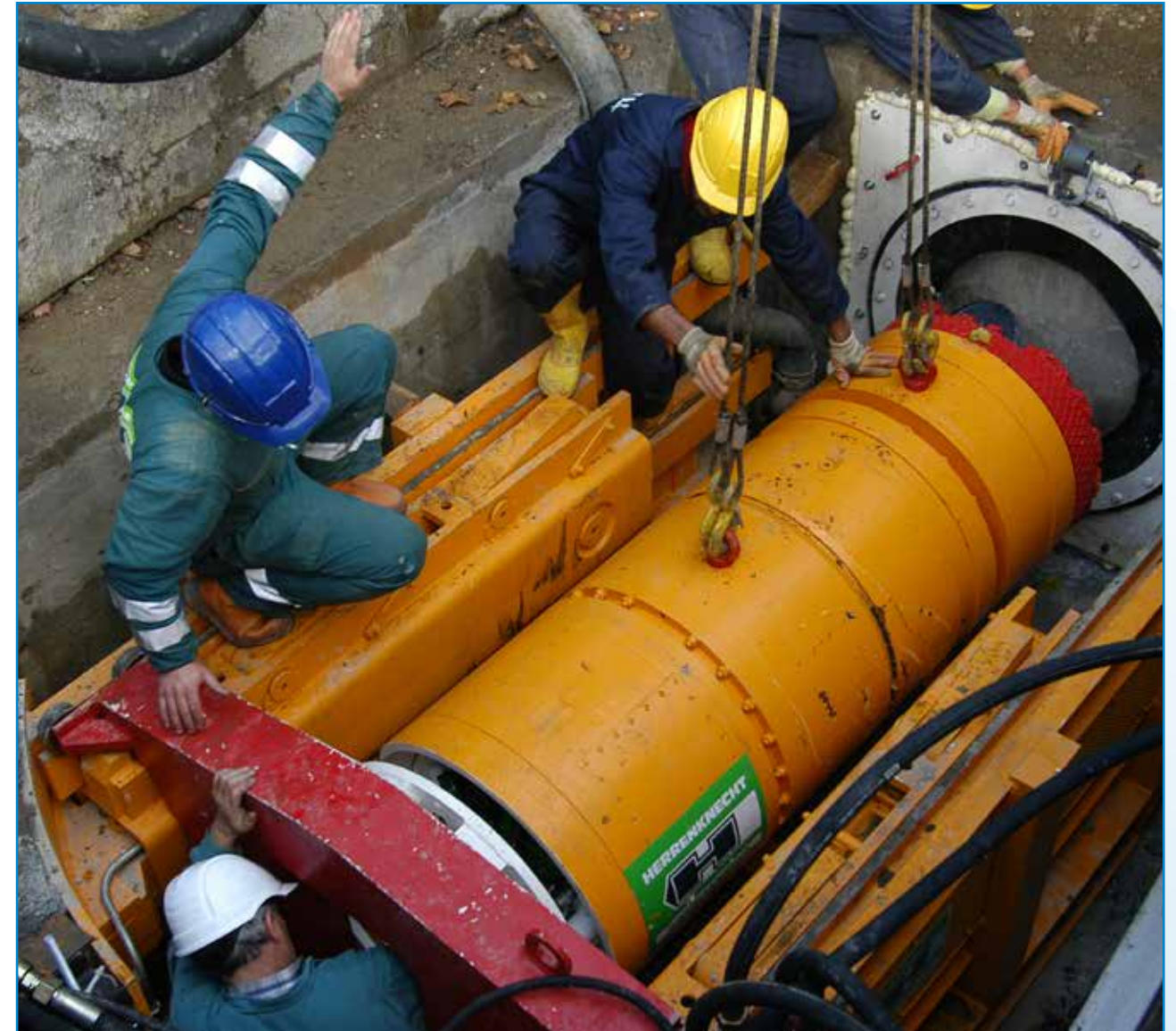
Atık Su Mikrotünel Çalışmaları
