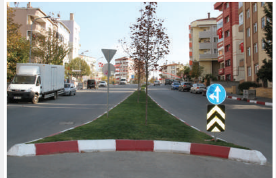
Petroliş Mahallesi Samanyolu Sokak Asfalt ve Çevre Düzenlenmesi
