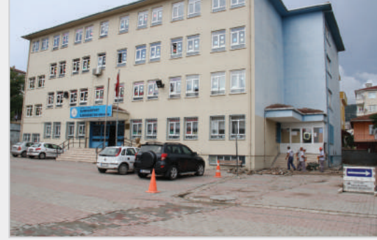
Cumhuriyet Mahallesi Cumhuriyet İlkokulu Kilittaşı Döşenmesi
