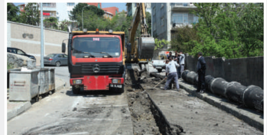
Yukarı Mahalle Dikey Sokak Yağmursuyu Kanal Çalışması
