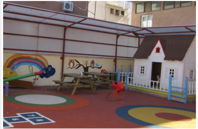
Atalar Mahallesi Çocuk Gelişim Merkezi Bahçesi Kauçuk Döşeme Çalışması
