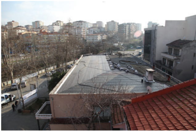
Hasan Ali Yücel Kültür Merkezi Çatı Bakım ve Onarım Çalışması
