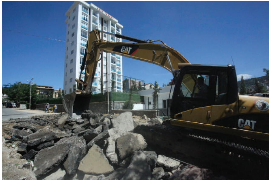
Hürriyet Mahallesi Tatlısu Sokak Yol Çalışması
