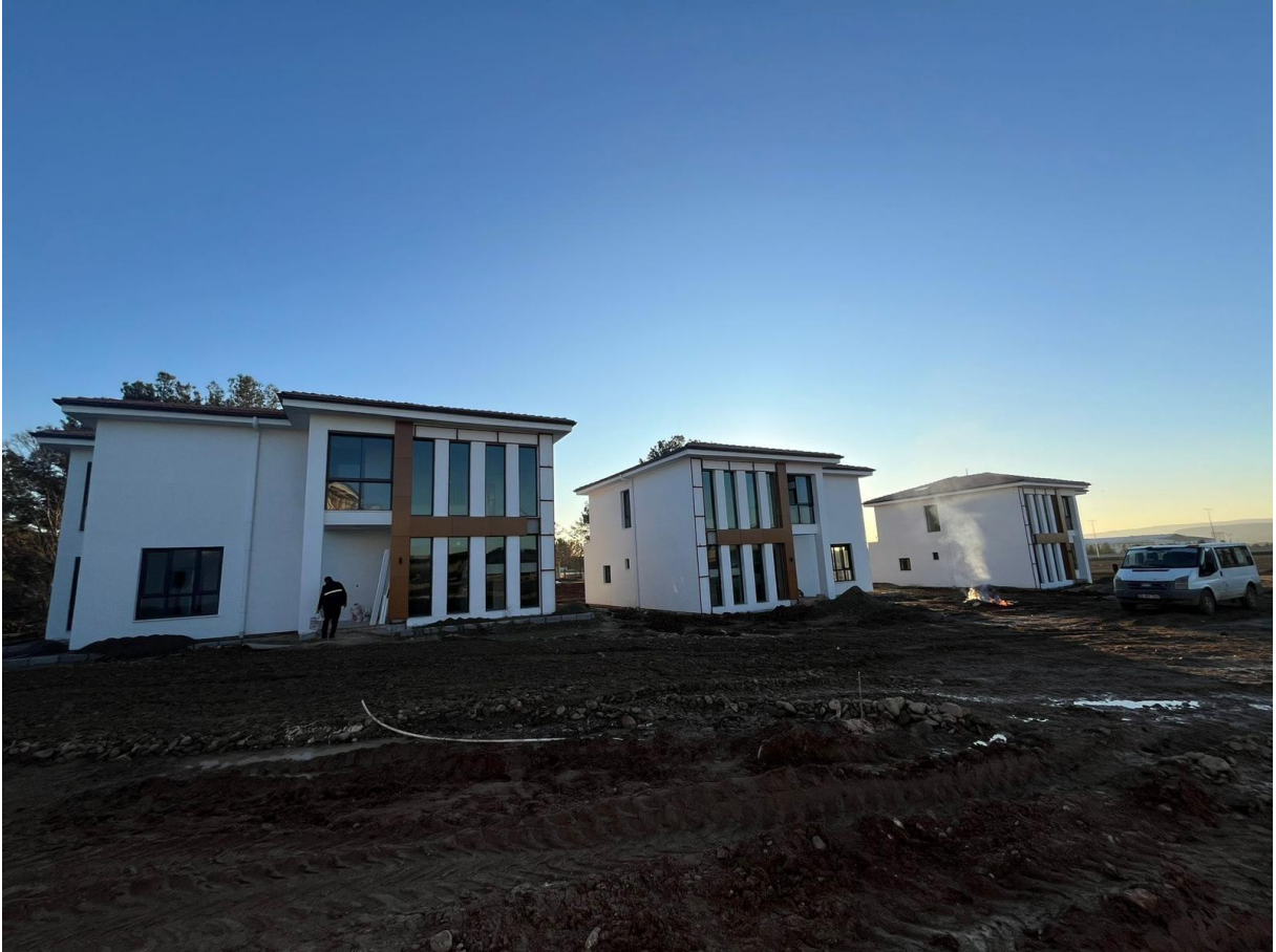
BATMAN KOZLUK İLÇE HALK KÜTÜPHANESİ YAPIM İŞİ ÇALIŞMASI
