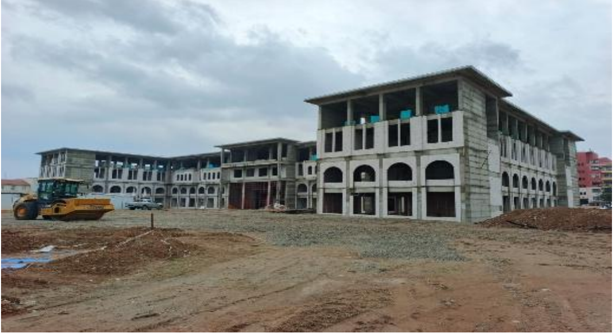
BATMAN MERKEZ MUHTELİF KAMU BİNASI YAPIM VE ÇEVRE DÜZENLEME İŞİ ÇALIŞMASI
