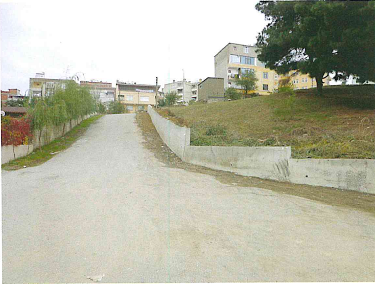
ADALET MAH.40 SK. PERDE DUVAR
