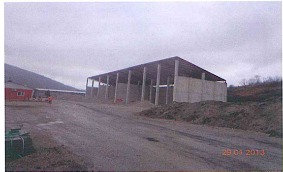
ASFALT PLENTİ SUNDURMA YAPIMI
