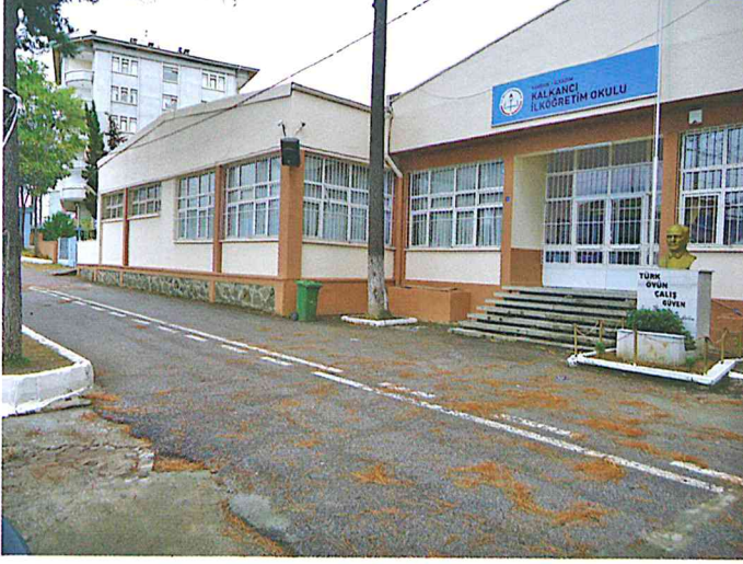
KALKANCA İLK ÖĞRETİM OKULU ( İÇ CEPHE VE DIŞ CEPHE BOYA YAPILMASI)
