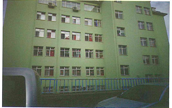
ALPARSLAN İLKÖĞRETİM. OKULU DIŞ CEPHE VE LAVOBA YAPILMASI)
