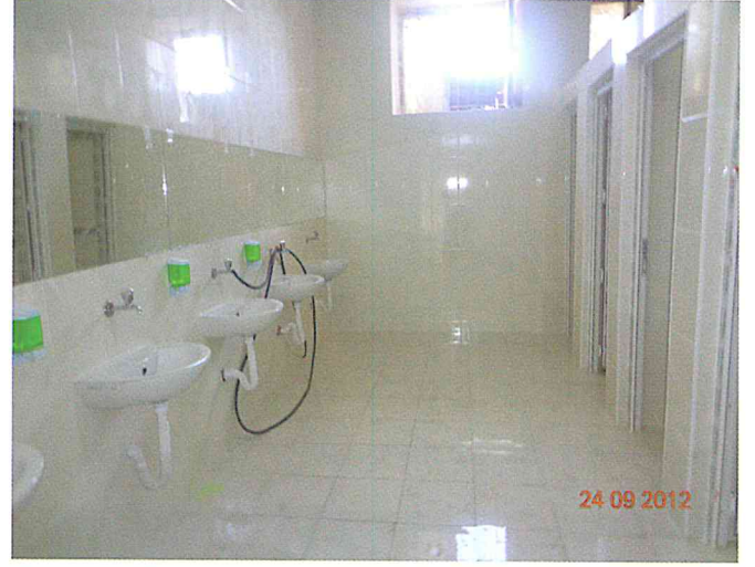
KAZIM PAŞA İLKÖĞRETİM OKULU (WC TADİLAT YAPILMASI)
