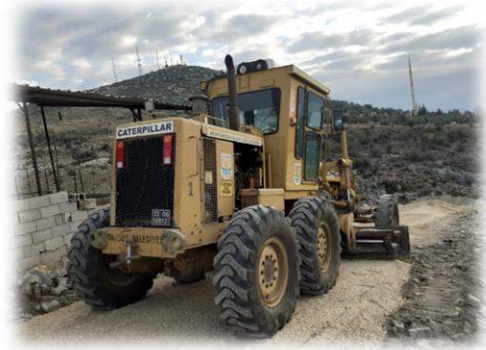
Şekil 2. Dedeler Mah. Yol Bakım Onarım Çalışması
