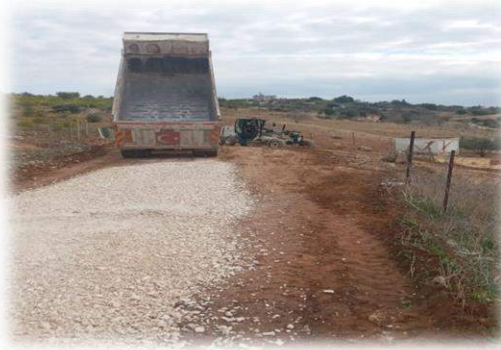
Şekil 1. Kaleburcu Mah. Yol Bakım ve Onarım Çalışması
