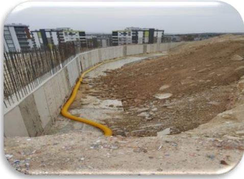
Şekil 8 İstinat Duvarı Yapım İşi
