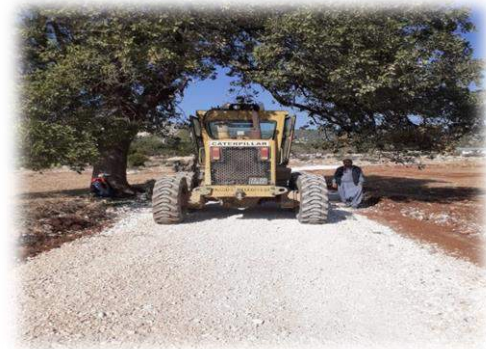
Şekil 4. Topaklı Mah. Yol Bakım ve Onarım Çalışması
