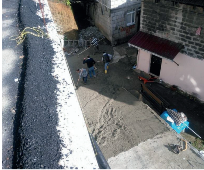
Çorapçılar Caddesinde yol betonlama çalışması
