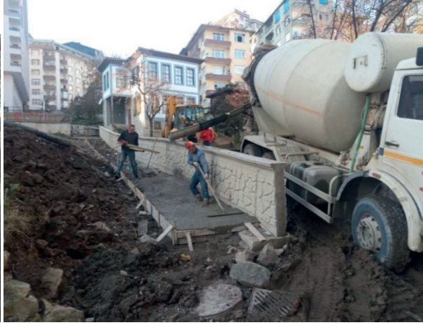
1 Nolu Dere Sokak'ta perde duvar ve yol betonlama çalışmaları
