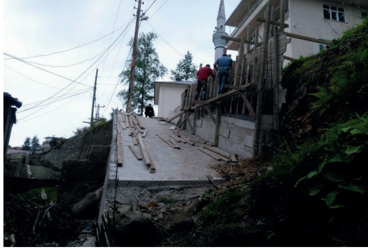
Çorapçılar Caddesinde seri ve yama asfalt çalışmaları (1800 ton – 79 ton)
