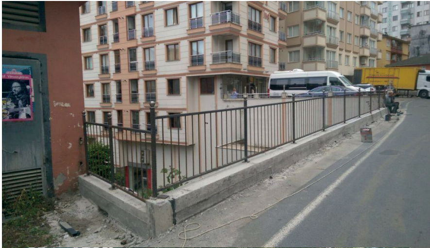
Atatürk Caddesi mevki ve Soğuksu sokak'ta ferforje montaj çalışmaları
