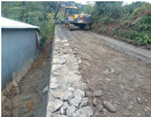
1 Nolu Okul Sokak'ta taş duvar yapım çalışmaları
