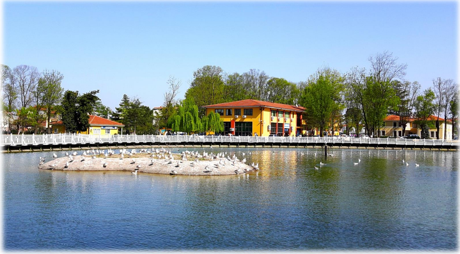
SASKİ Genel Müdürlük Binası
