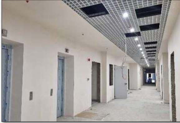
Resim 289. Avcılar Yerleşkesi Kimya Bölümü, Kimya Müh. Ve Metalürji ve Malzeme Müh. Binası Yapılması İşi
