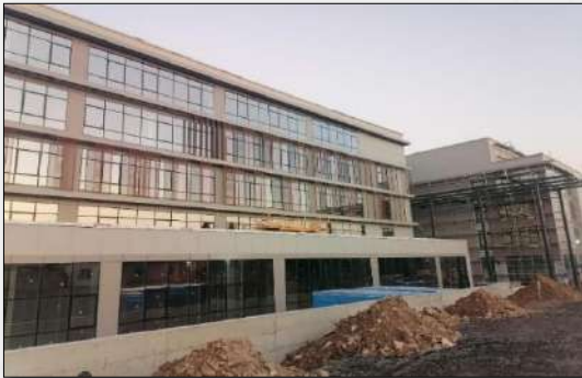
Resim 283. Rektörlük ve İdari Birimler Binası Yapımı İşi
