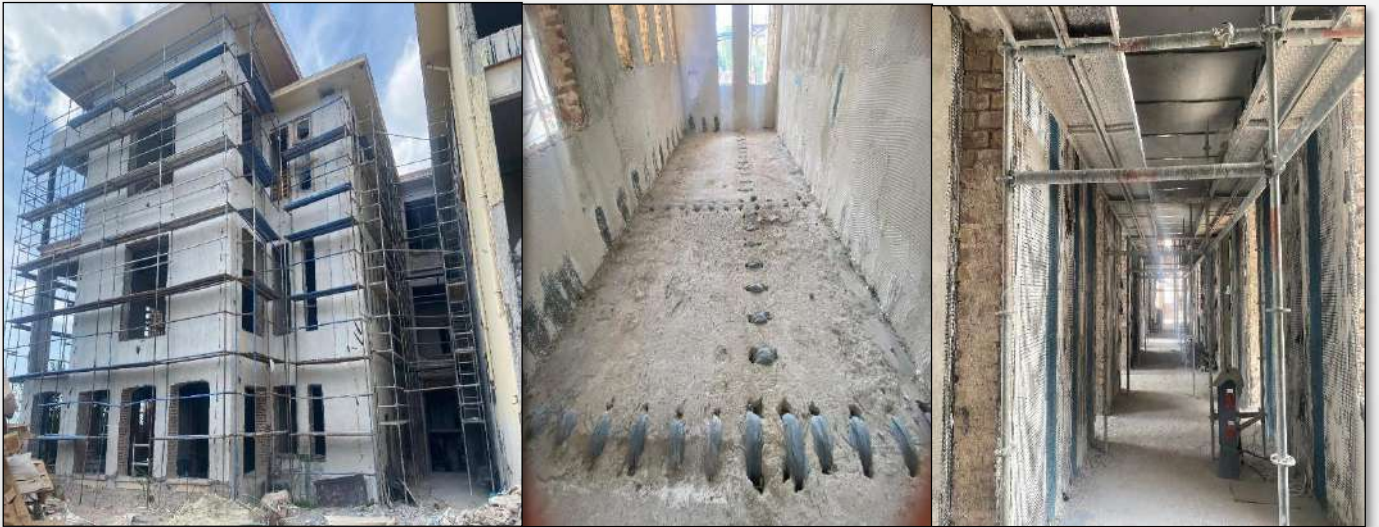
Resim 297. Cerrahpaşa Yerleşkesi İdari Bina (Eski Psikiyatri Binası) Restorasyonu
