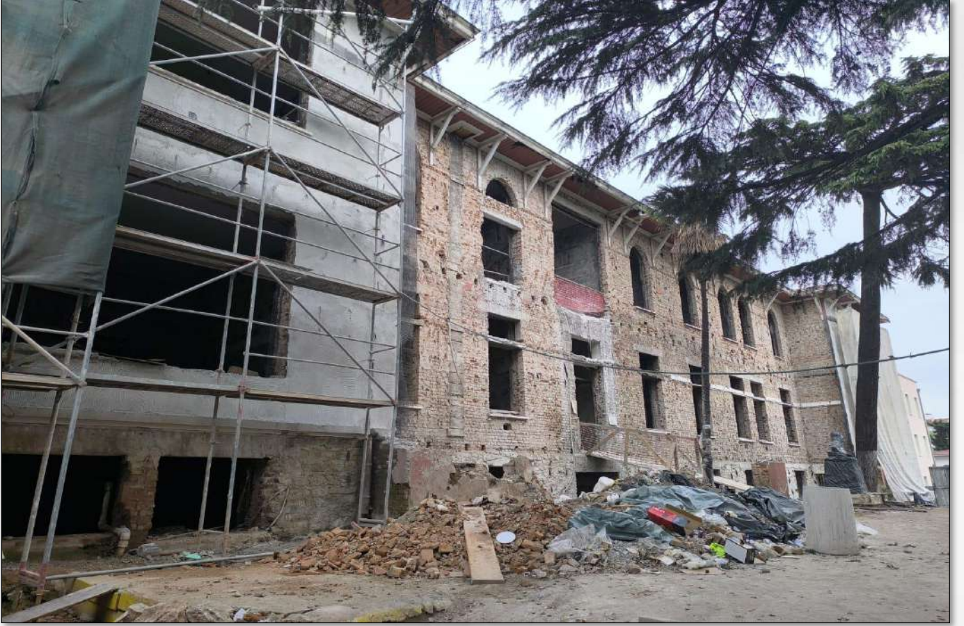
Resim 298. Cerrahpaşa Yerleşkesi Dekanlık Binası İşi
