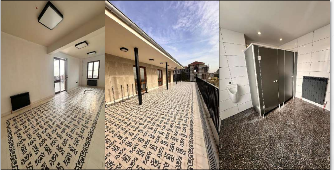
Resim 295. Cerrahpaşa Yerleşkesi Başhekimlik (Eski Jinekolojik Onkoloji) Binası Rekonstrüksiyonu İşi
