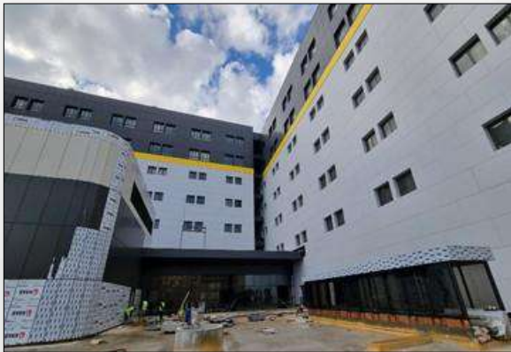
Resim 291. Avcılar Yerleşkesi Kimya Bölümü, Kimya Müh. Ve Metalürji ve Malzeme Müh. Binası Yapılması İşi
