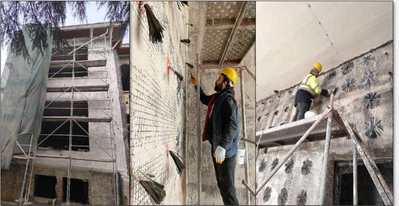
Resim 299. Cerrahpaşa Yerleşkesi Dekanlık Binası İşi
