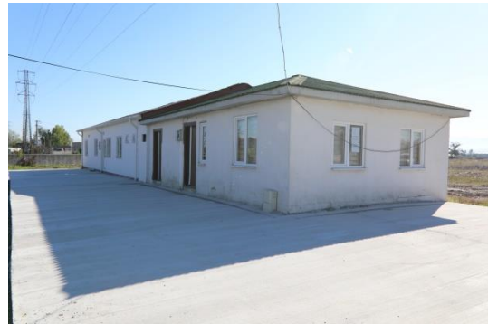
Kozluk Mahallesi, Erenler 2022
